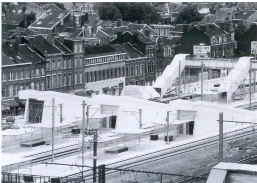
Équipement des nouveaux quais avec abris légers provisoires (sept. 2002)
