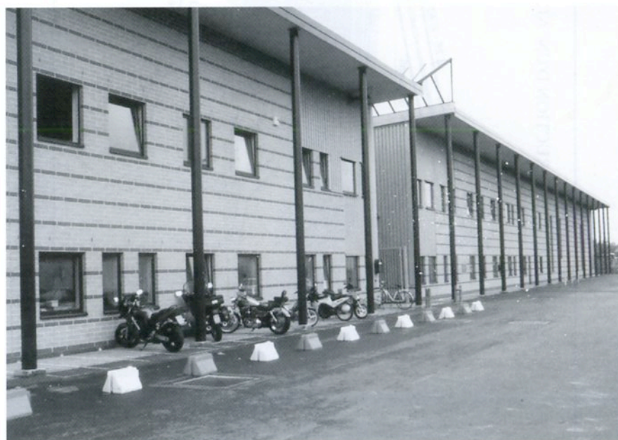
Atelier de traction de Charleroi-Sud-Quai ↑ Vue d'un des faisceaux extérieurs ↓ Architecture de la façade principale Photos SNCB – F. Dewulf (août 2002)
