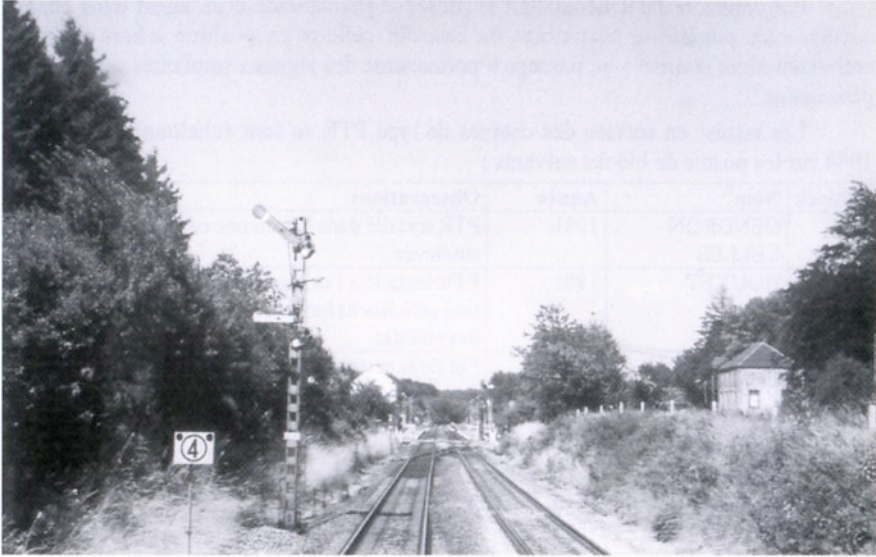
L'Athus-Meuse à l'époque, pas si lointaine, des palettes : Le signal F15, implanté sur la voie B, protège l'entrée de la gare de Gedinne côté Bertrix. La palette de manœuvre permet d'accéder à la voie de garage 3 via la voie A. 12 juillet 1994
