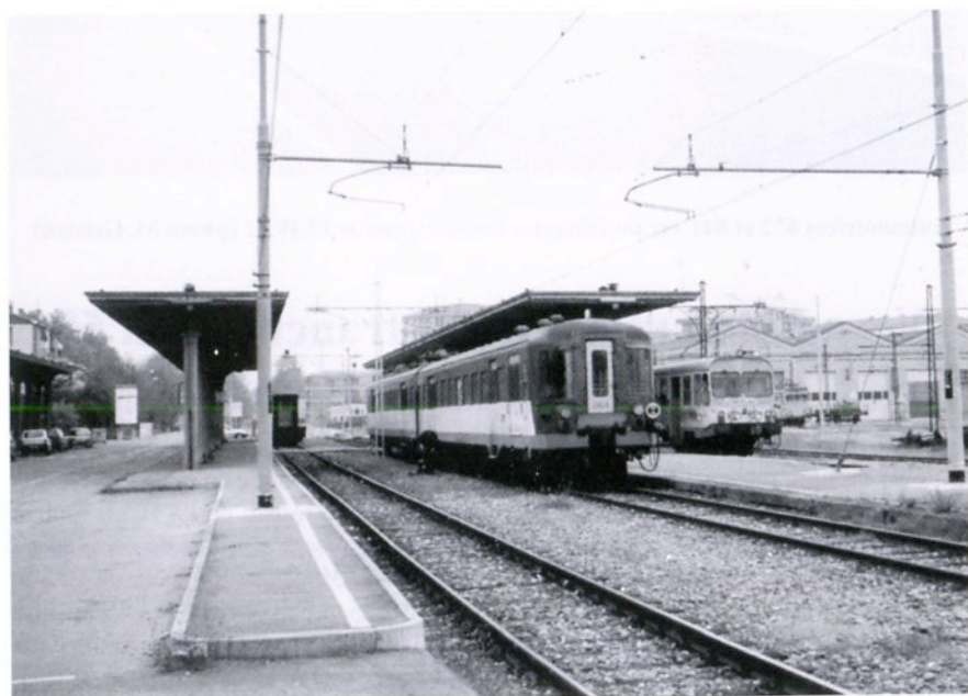
Modena (Italia) : gare du ATCM – à droite, le dépôt (21.10.02)
