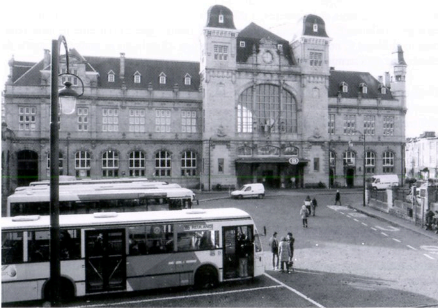
Façade côté ville de la gare de Verviers-Central (photo SNCB)
