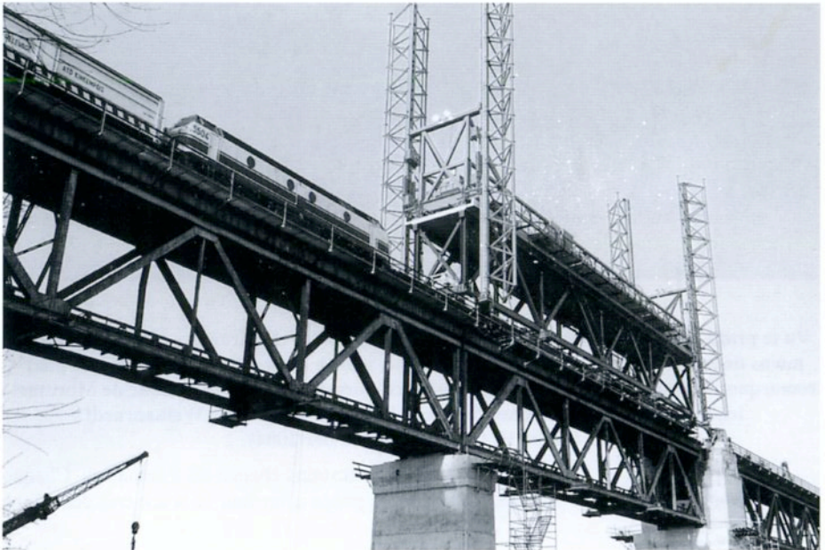
Travaux de remplacement d'un tablier (photo A. Spailier)
