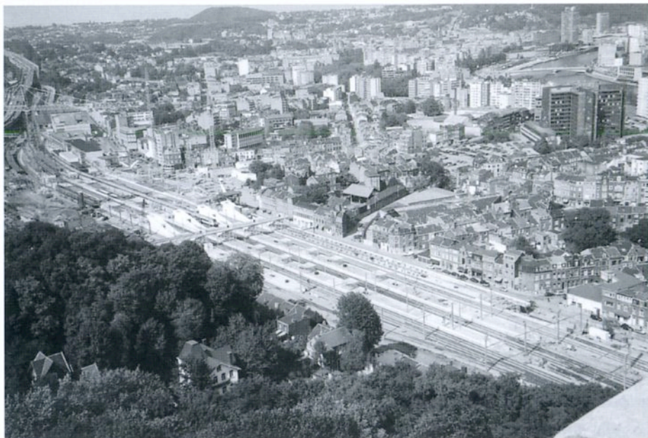
Site de la gare de Liège-Guillemins, vu du monument interallié de Cointe (photo R. Stekke – 31.08.04)
