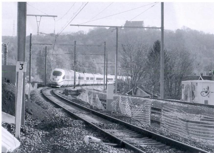
**Evolution des travaux à Chênée (photo W. Brock) : une rame ICE de la DB assurant le train INT 15 en direction de Köln et Frankfurt/a/Main Hbf, passe le 21/11/04 sur la voie unique restant en service. On distingue sur sa droite la zone de construction des nouvelles voies A et B, en l'état de la phase B du chantier (13/06/04 au 11/12/04) tel que décrit en p.5 du supplément à *trans-fer* 132.**
