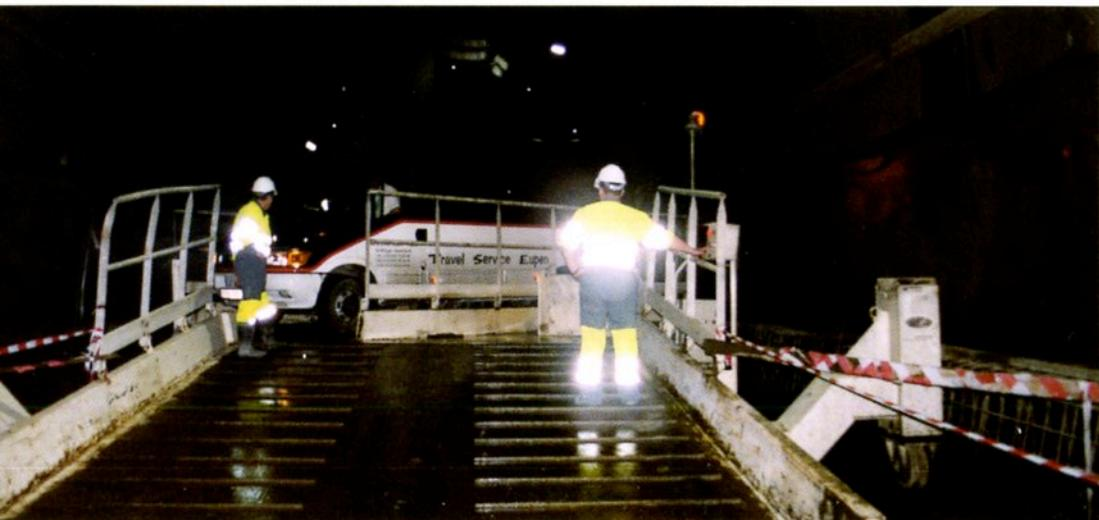
Le plateau servait à l'inversion des camions à cuve de béton
