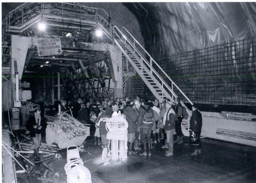
**Promenade pédestre des membres du GTF asbl dans les entrailles de la terre, dans le tunnel de Soumagne : le groupe écoute les explications de M. Couchard à l'endroit où la voûte se construit : à droite, bien visible, la membrane en PVC, membrane soudée, qui capte et isole l'eau d'infiltration très abondante (photo M. Lebeau – 20.11.04)**
