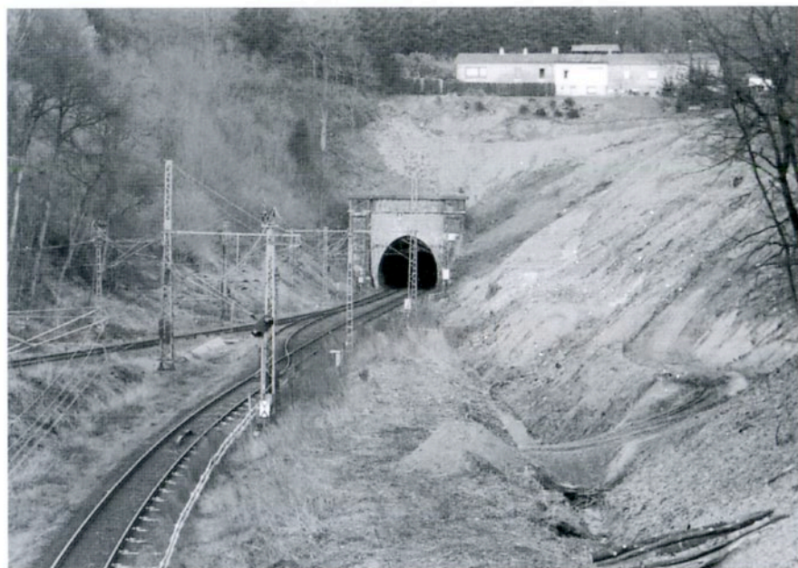
Travaux de forage du nouveau Busstunnel versant « Aix-la-Chapelle » (Aachen Süd) en haut, et versant vers la Belgique (Bildchen) en bas. Sur cette dernière photo, on voit que les deux voies principales se séparent pour aborder l'actuel saut-de-mouton (photos M. Lamboray – 26.03.05)
