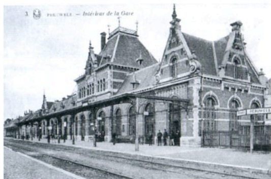
Vue ancienne du bâtiment de Péruwelz (coll. GTF asbl)
