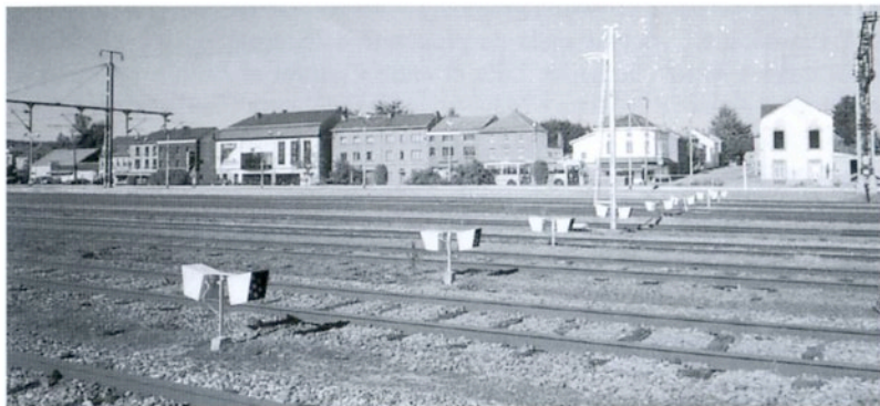
Rangée d'IOT à fleur de sol au faisceau marchandises de Gouvy (photo R. Marganne - 22.09.05)
