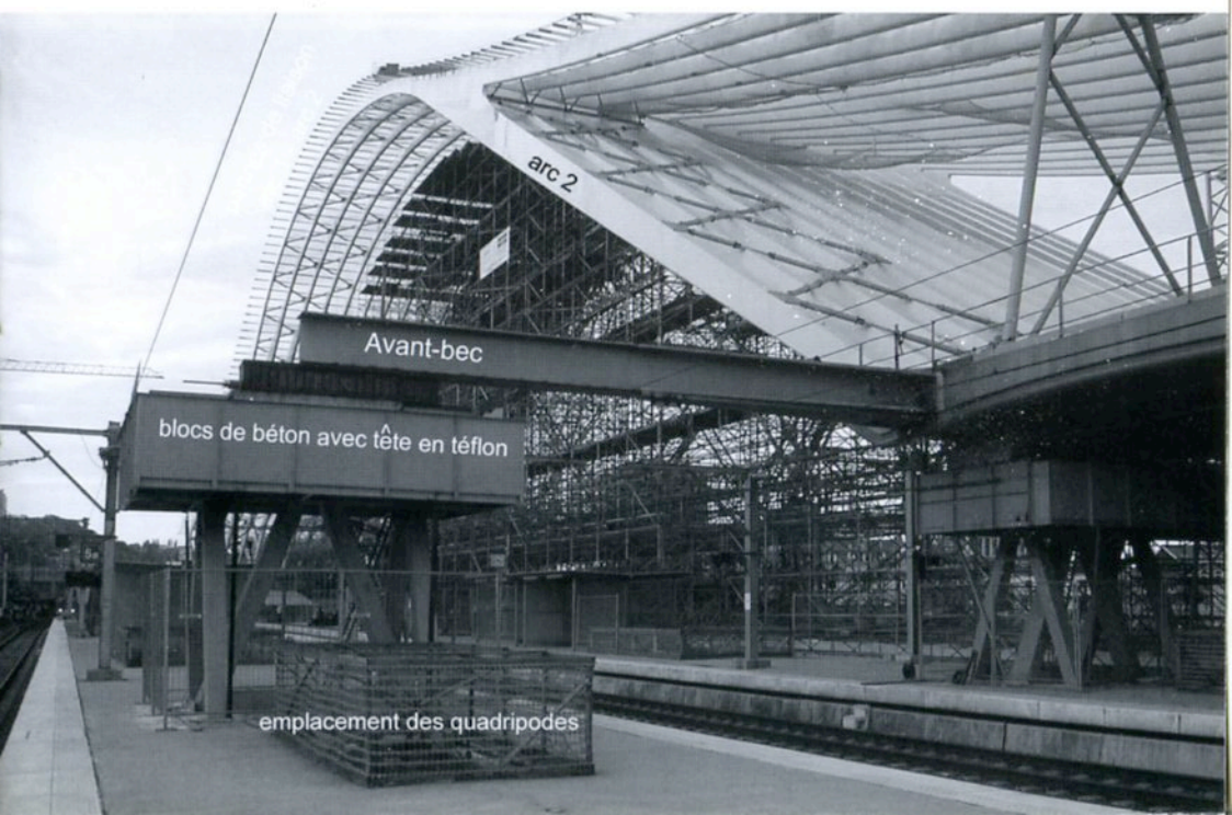
† Ensemble de poussage avant l'installation de la plate-forme de montage
