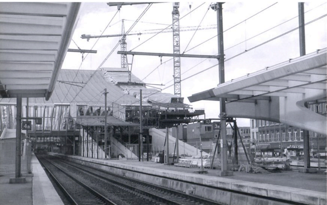
Préparation de la plate-forme d'assemblage des liaisons abris de quai - v o ûte
