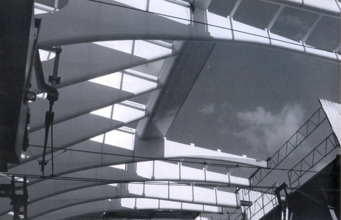
Préparation de la plate-forme d'assemblage des liaisons abris de quai - v o ûte
