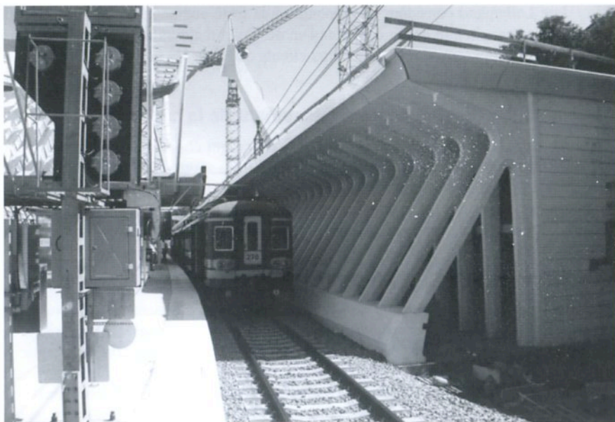
L'ouverture à l'exploitation du dernier quai bordant les voies 8 et 9 de Liège-Guillemins en juillet dernier permettra notamment l'amélioration du service « L » entre Liège et Statte (photo J. Braive – 22.07.06 – voie 9)
