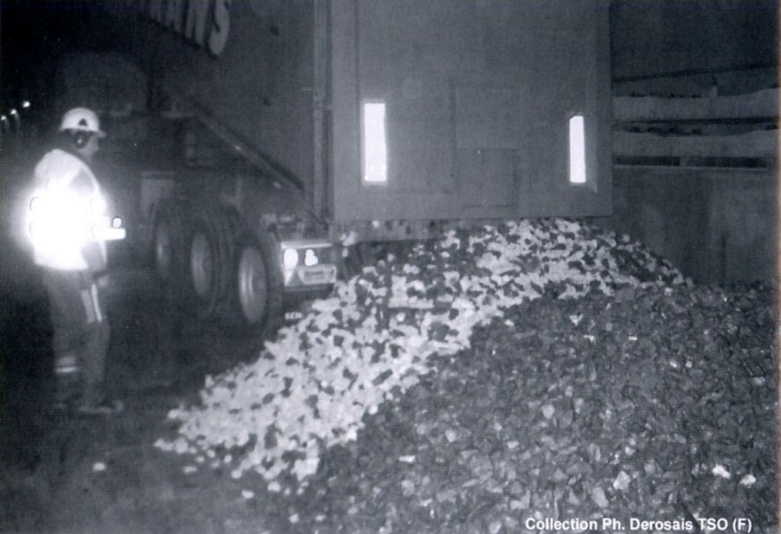
Tunnel de Soumagne (févr. 2006) Déversement du ballast en cordon sur une demi largeur
