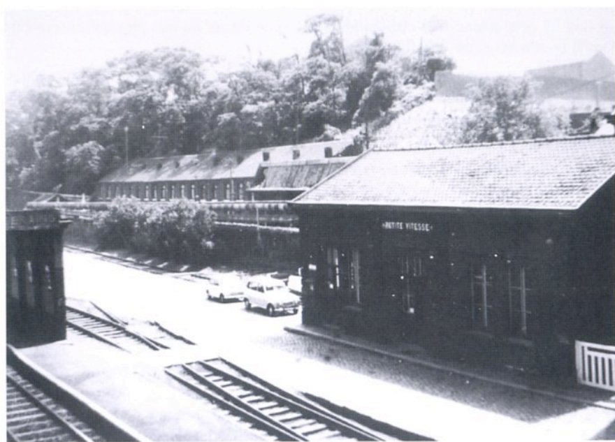
Le BR ( bâtiment des recettes ) de Seraing sans doute au début du XX ème siècle, avec en arrière plan, en direction de Liège, le « pont Collard » en briques. En face du bâtiment voyageurs se trouvait un bâtiment traitant les colis « petite vitesse ». Toutes ces constructions ont aujourd'hui disparu. ( cartes-vues extraites de la collection G. Close / Charlie Hotel )
