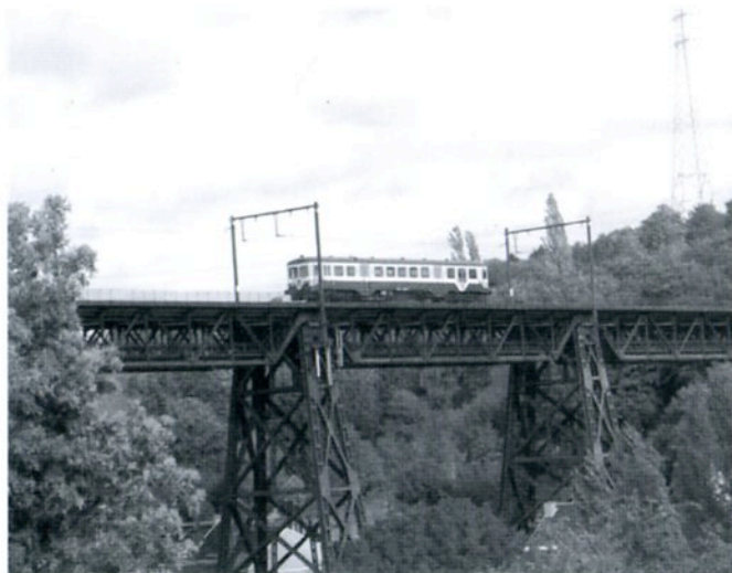
L'autorail affrété par le GTF asbl franchit le viaduc du Horloz le 21.10.06 (photo A. Ferrière)
