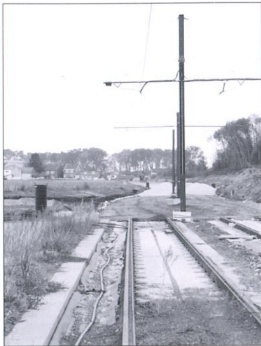
Le 12/10/2006, lors de la visite du GTF : la situation à Dutemple, au bout des voies de la ligne 1.
