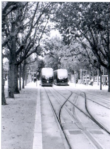
Bordeaux le 23/07/04 : au terminus (provisoire) des Quinconces : les voies et une liaison sur une section avec le rail central d'APS.
