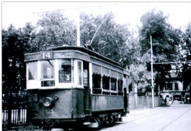
**Toulouse** : devant la Gare Roquet le 13/07/1948, motrice T2 n° 123 au terminus de la ligne 14 desservie par les tramways jusqu'au 15 /07/1952 lorsque les autobus prirent la relève. À la belle saison, ces motrices étaient convertibles par la dépose temporaire des baies vitrées.
