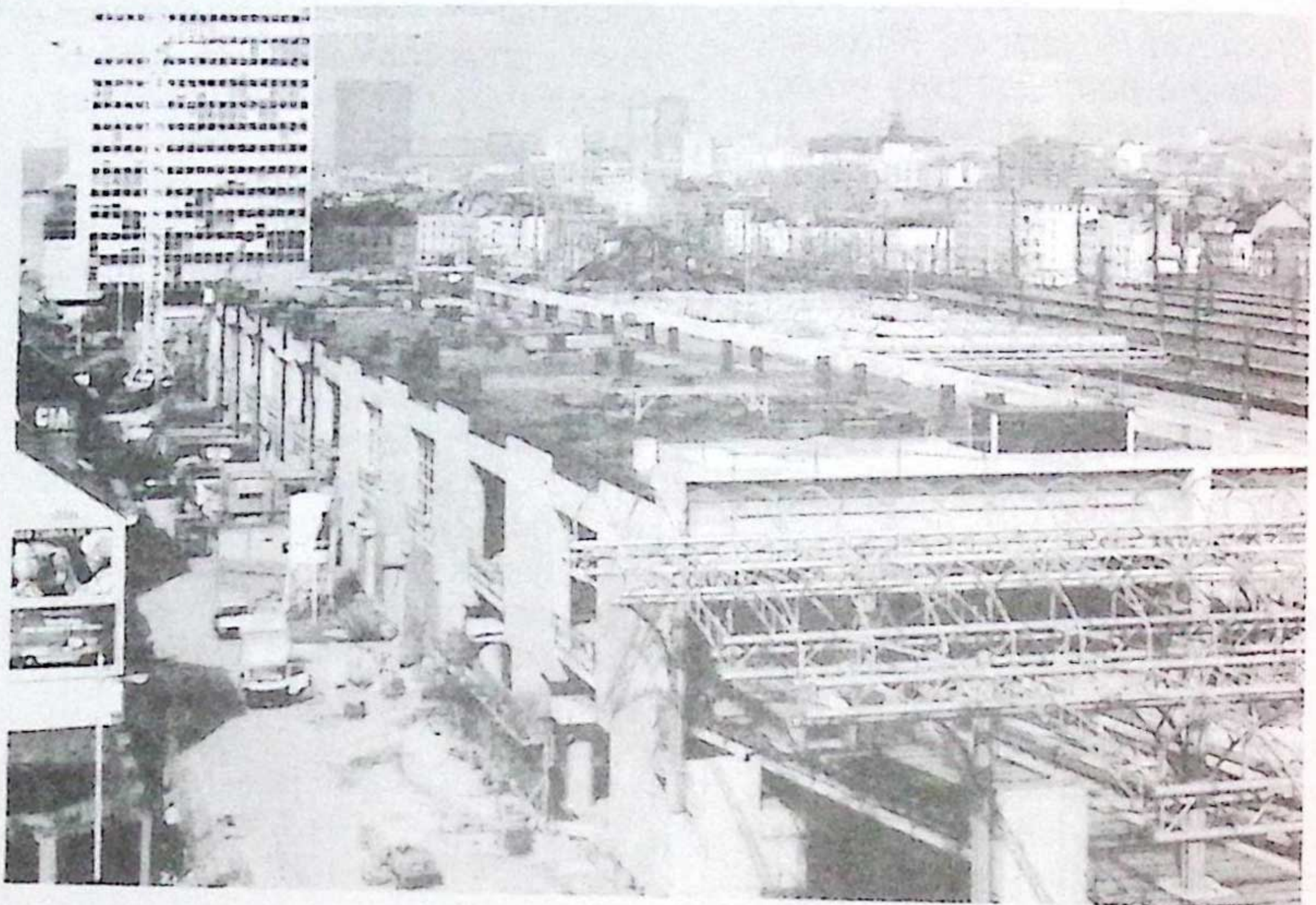
Deux vues du terminal TGV de Bruxelles-Midi en construction (photos D. MOINIL et K. TOURNAY - © SNCB - Moyens Audio-visuels)
