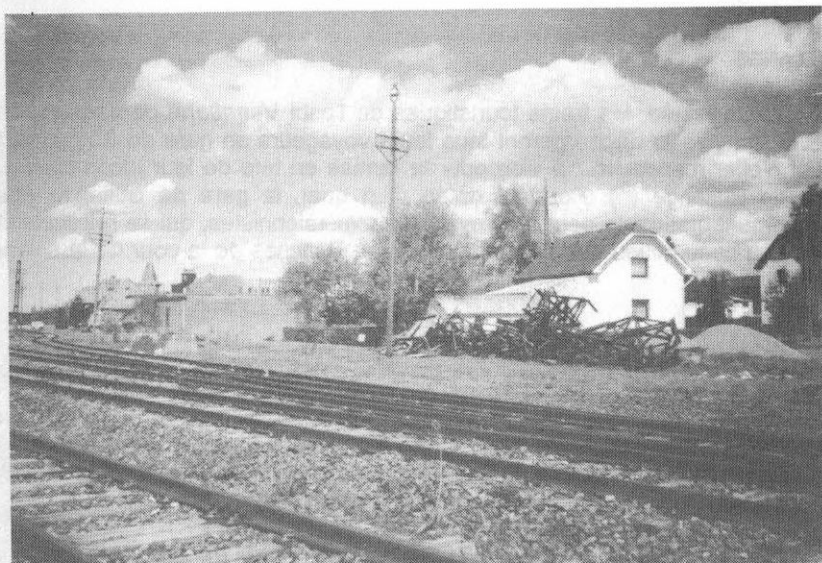
La carcasse de la passerelle à signaux gît à côté des voies à la sortie de Sourbrodt (photo H. Groteclaes - 9 mai 1995)
