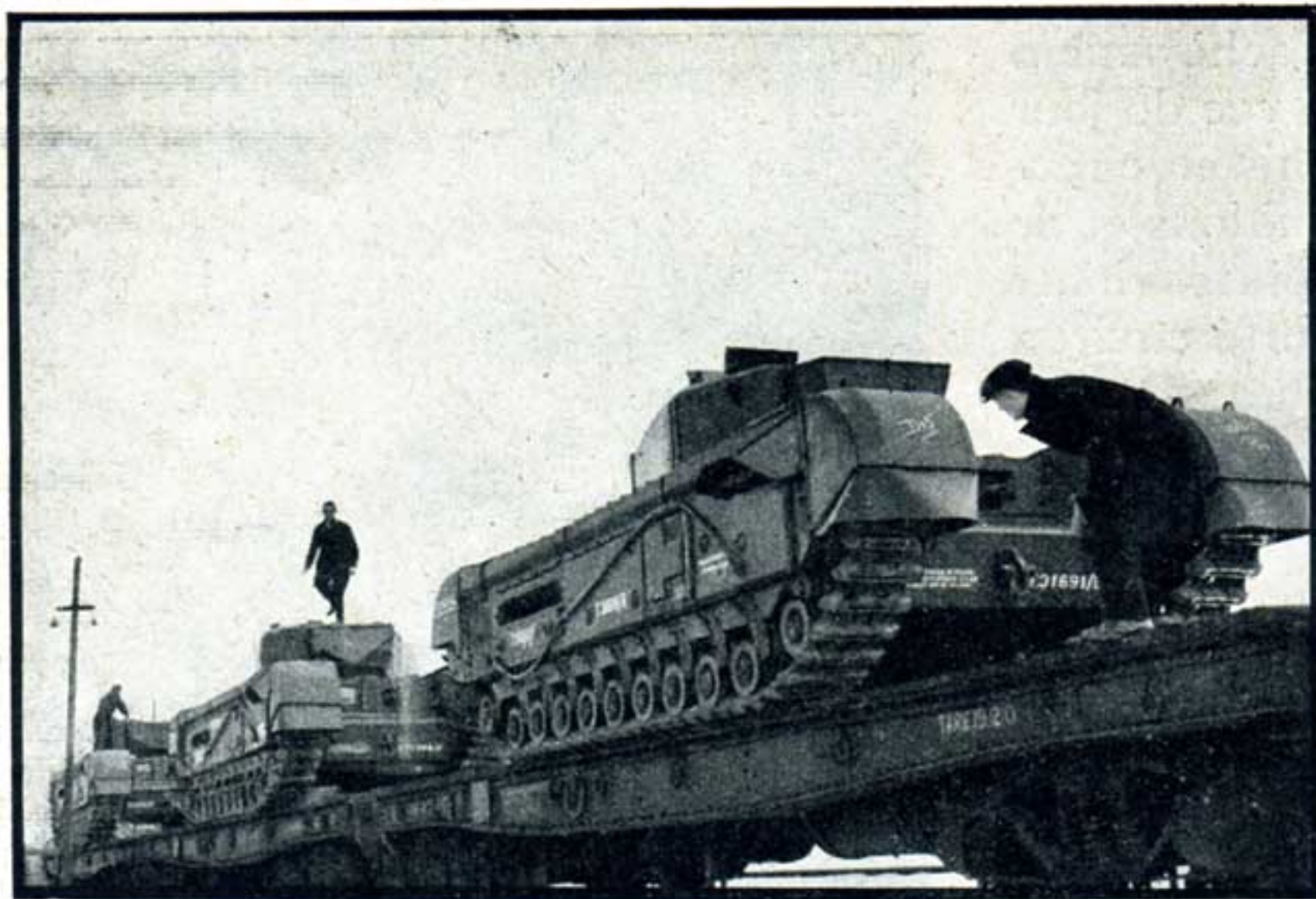
Tanks placés sur des « flats »-wagons surbaissés spécialement conçus et construits pour ce transport.
