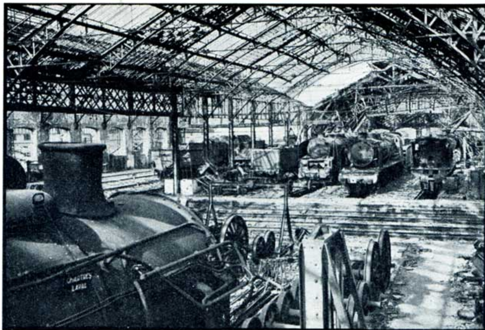
Etat des ateliers de réparations de locomotives de LAVAL, après les bombardements de juillet 1944 qui précédèrent la libération de la ville, le 7 août 1944. (Cliché Mission Militaire Belge.)
