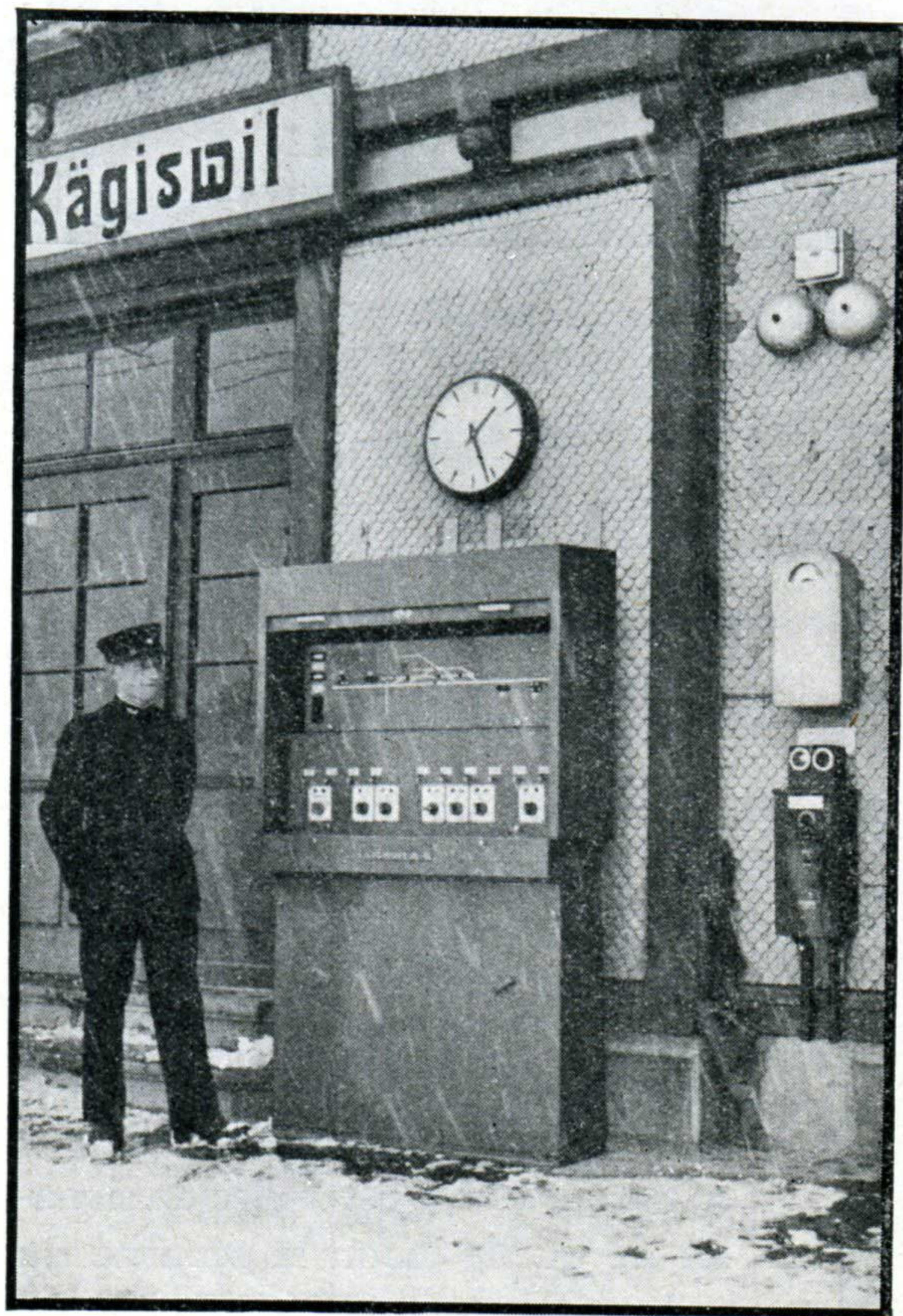
Cabine de signalisation électrique placée sur le quai d'une gare. (Cliché C. F. F.)
