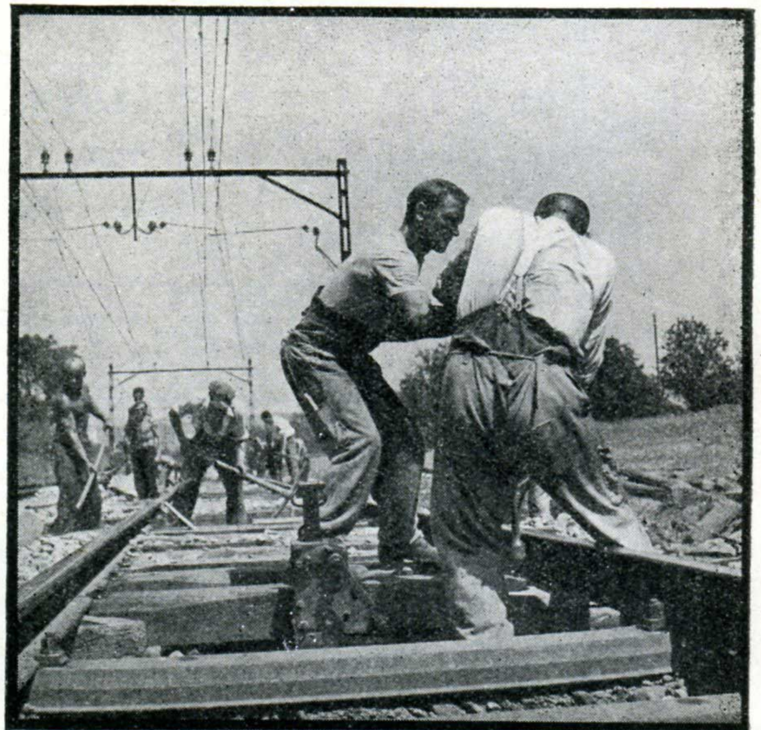
Réfection de voie. (Cliché C. F. F.)
