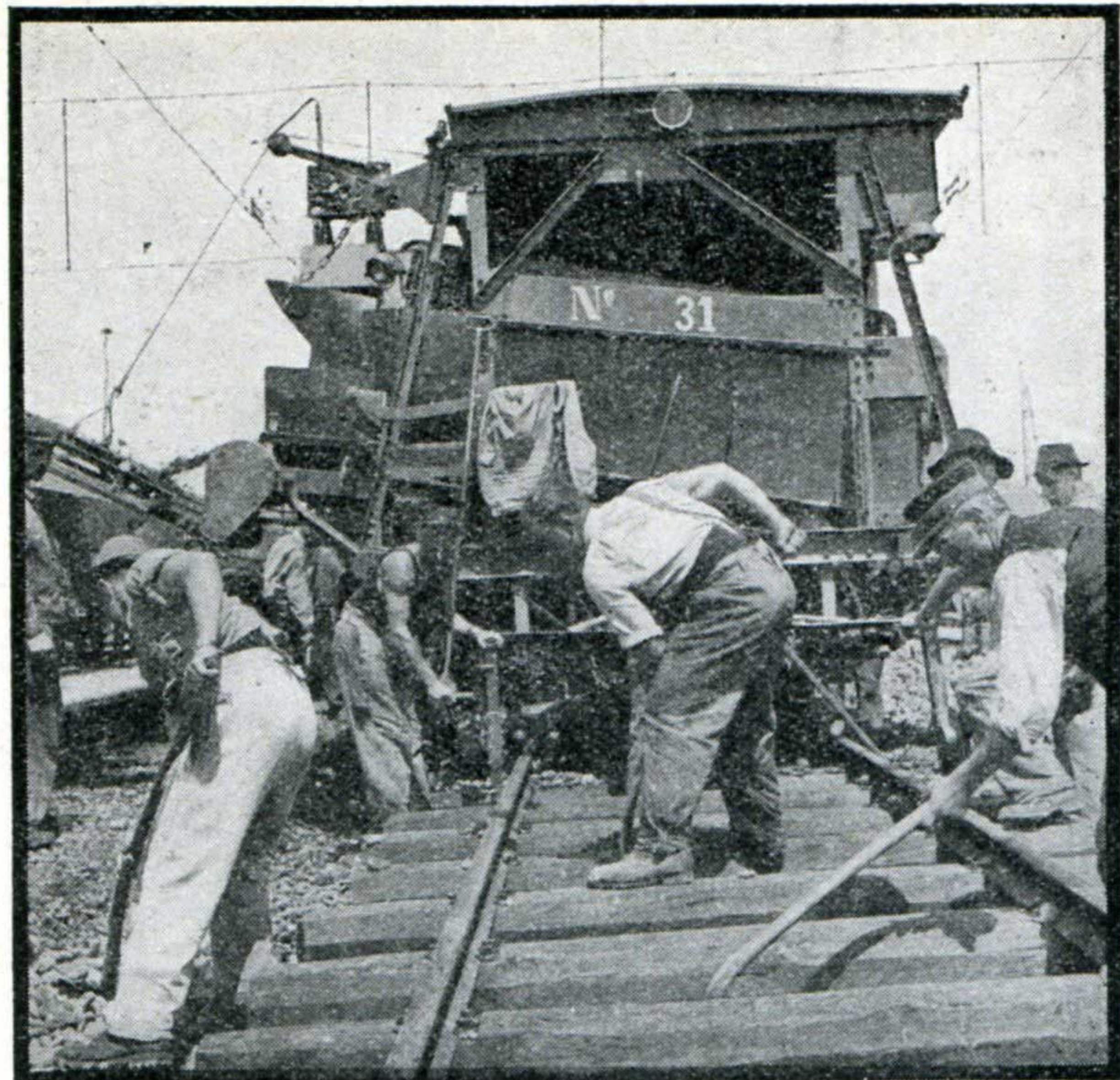
Cribleuse en pleine action.
