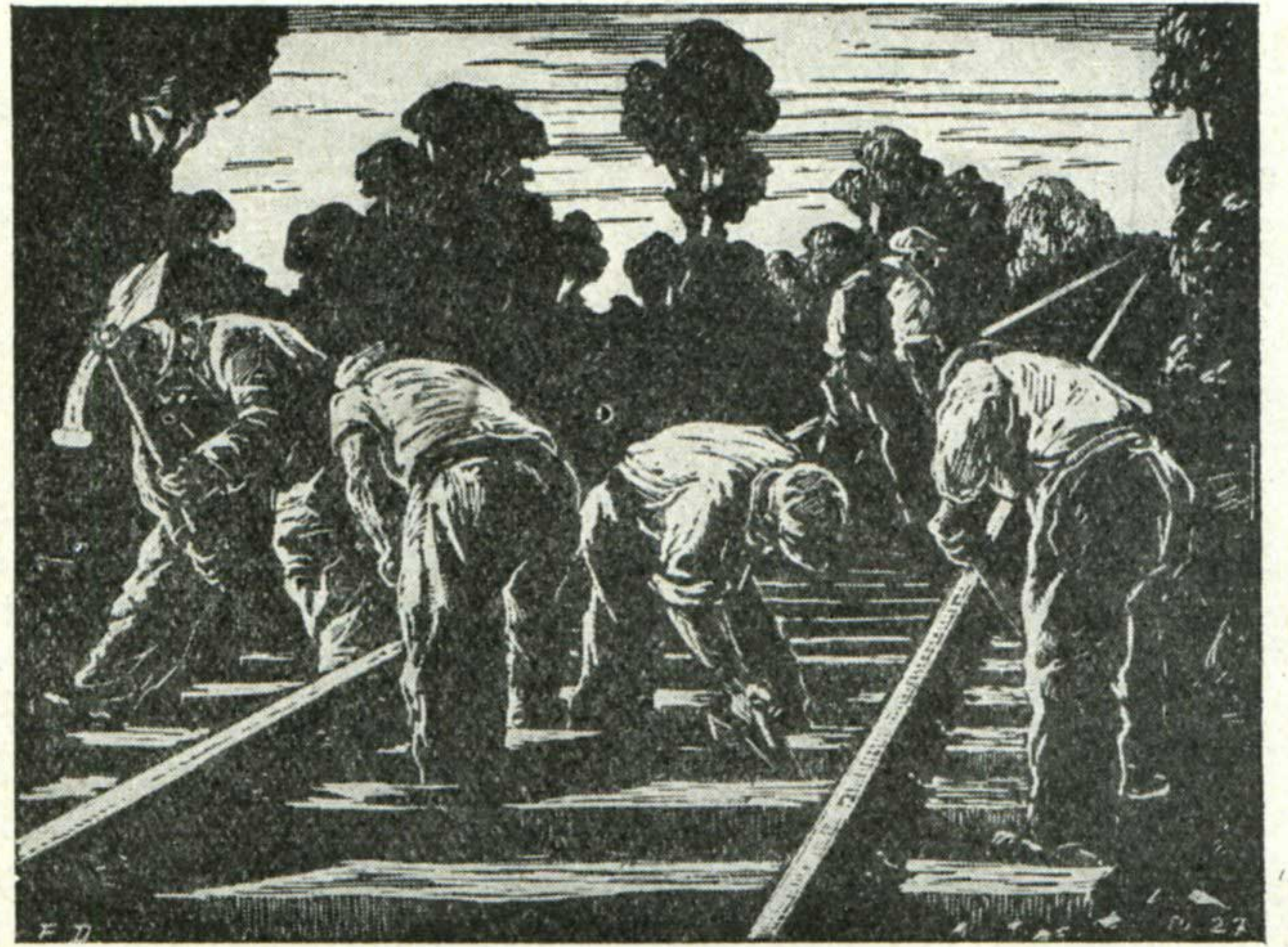
Bourrage de la voie.
