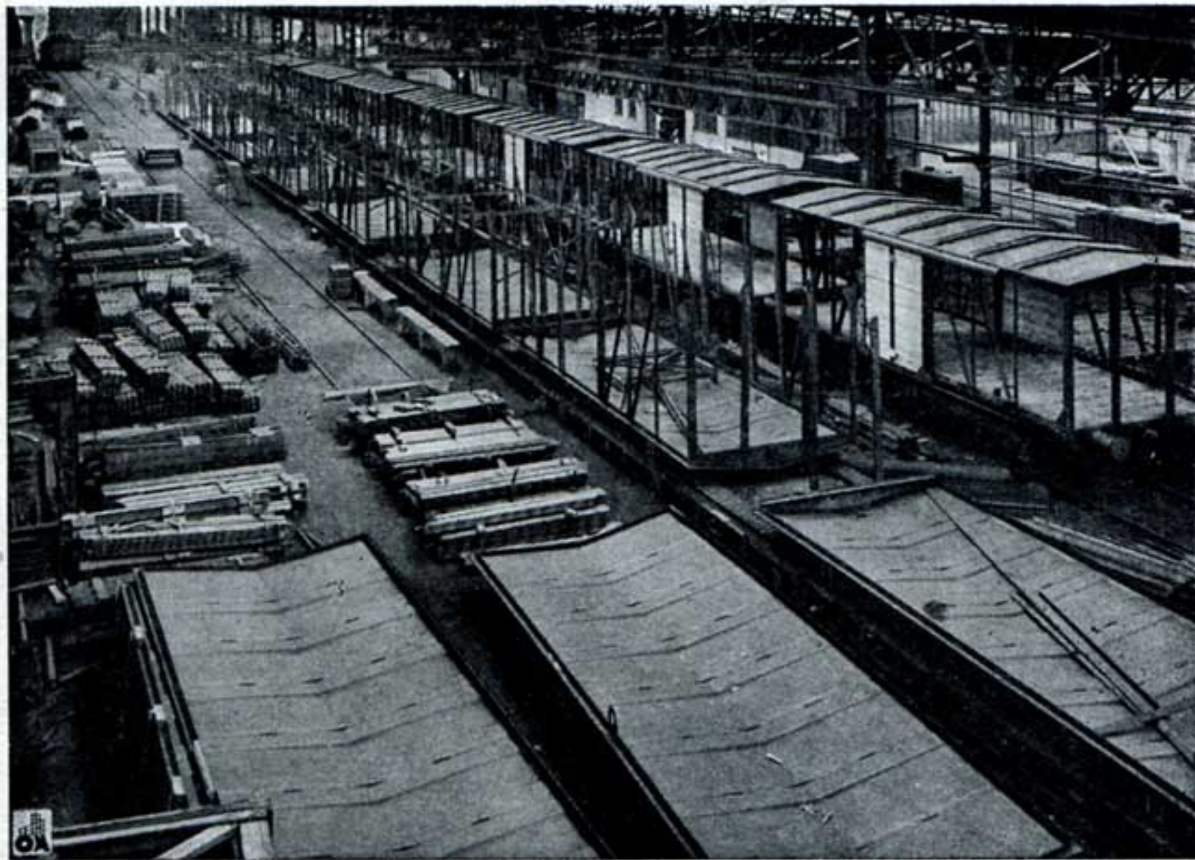
Fig. 7. Vue d'un grand hall de montage à la chaîne des toitures de wagons fermés.
