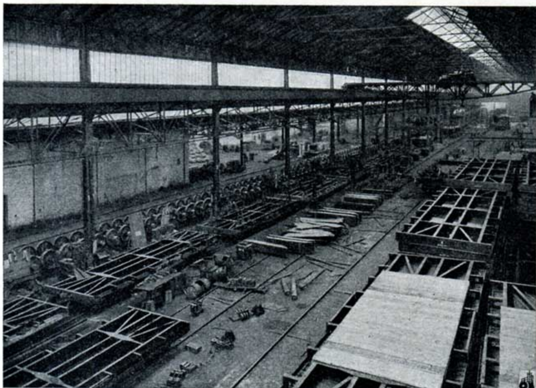
Fig. 4. Construction à la chaîne de wagons.
