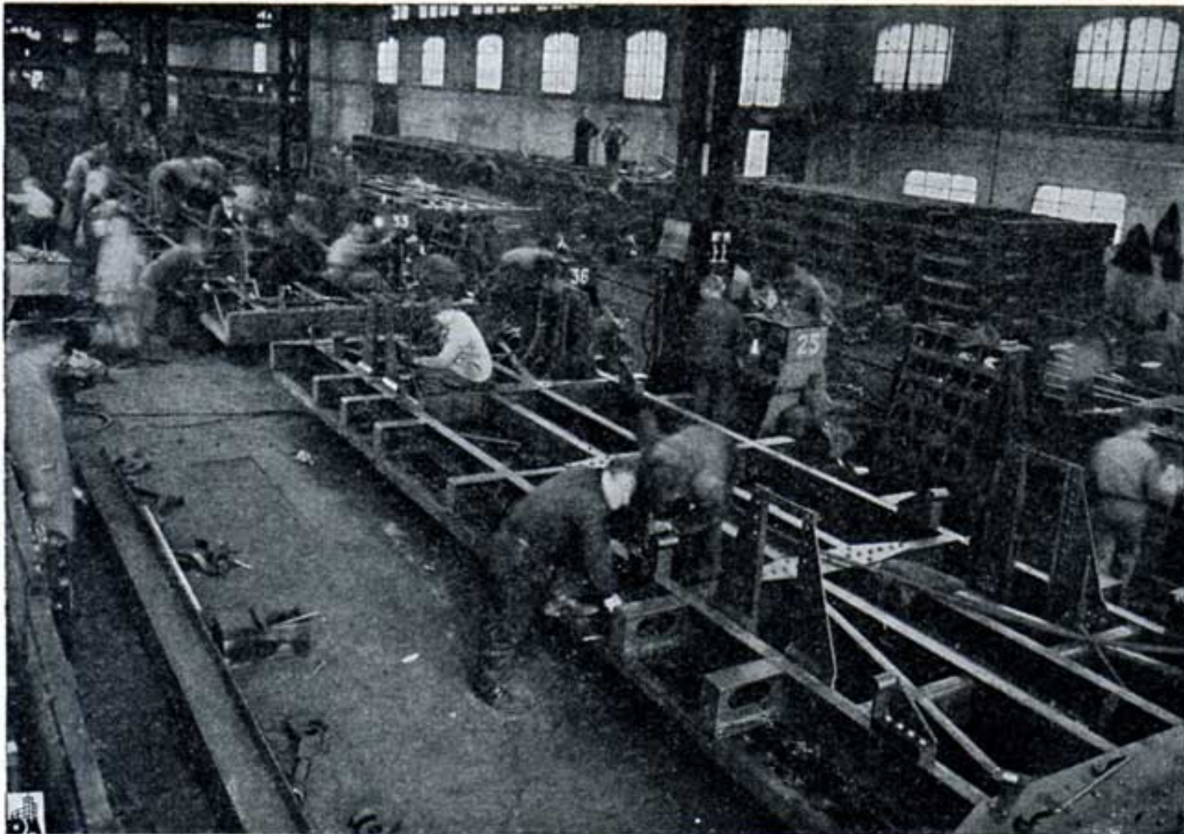
Fig. 8. Montage en série des châssis. L'opération se fait sur châssis retournés.
