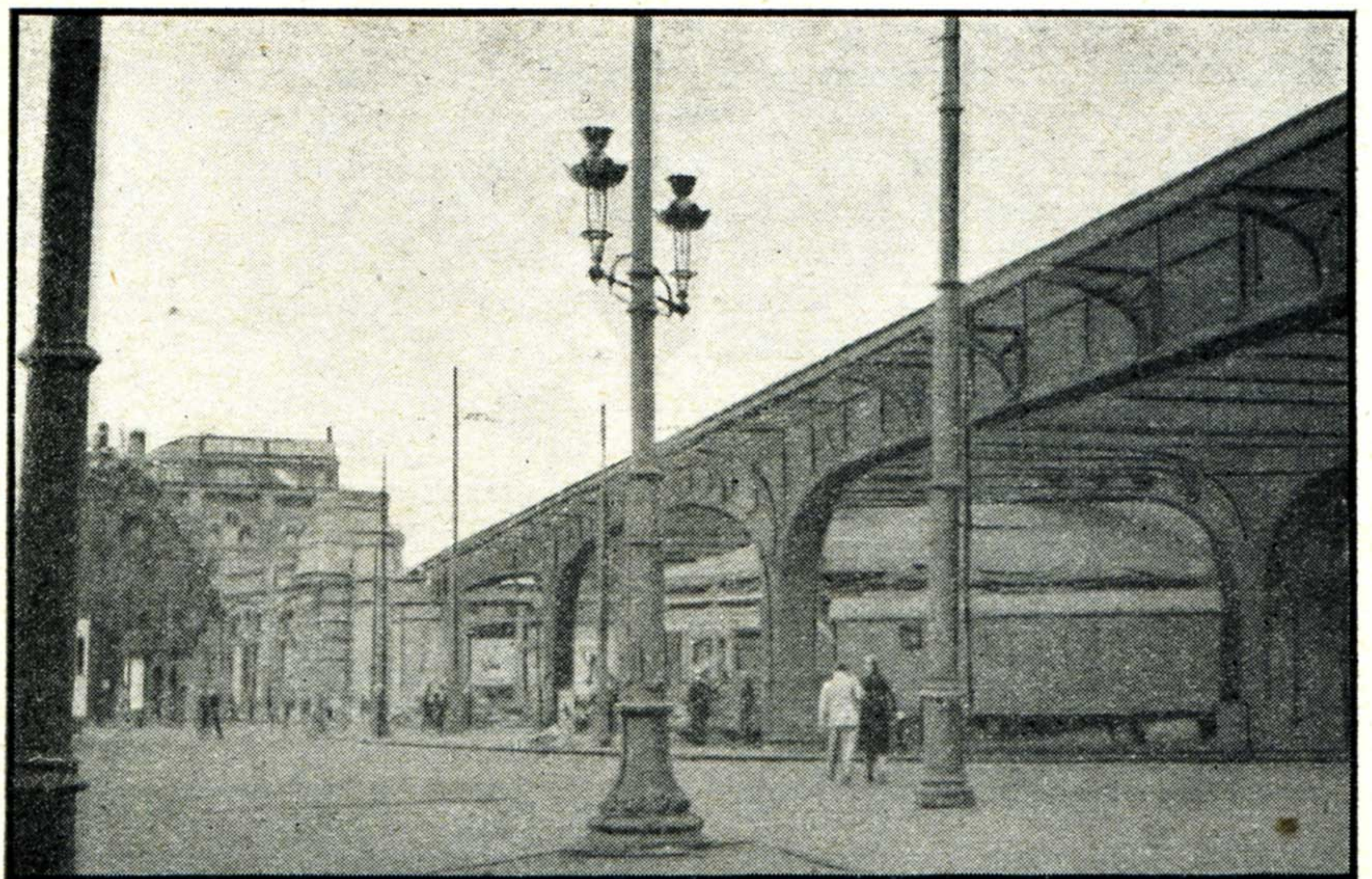
Viaduc métallique du boulevard du Midi (1914).
