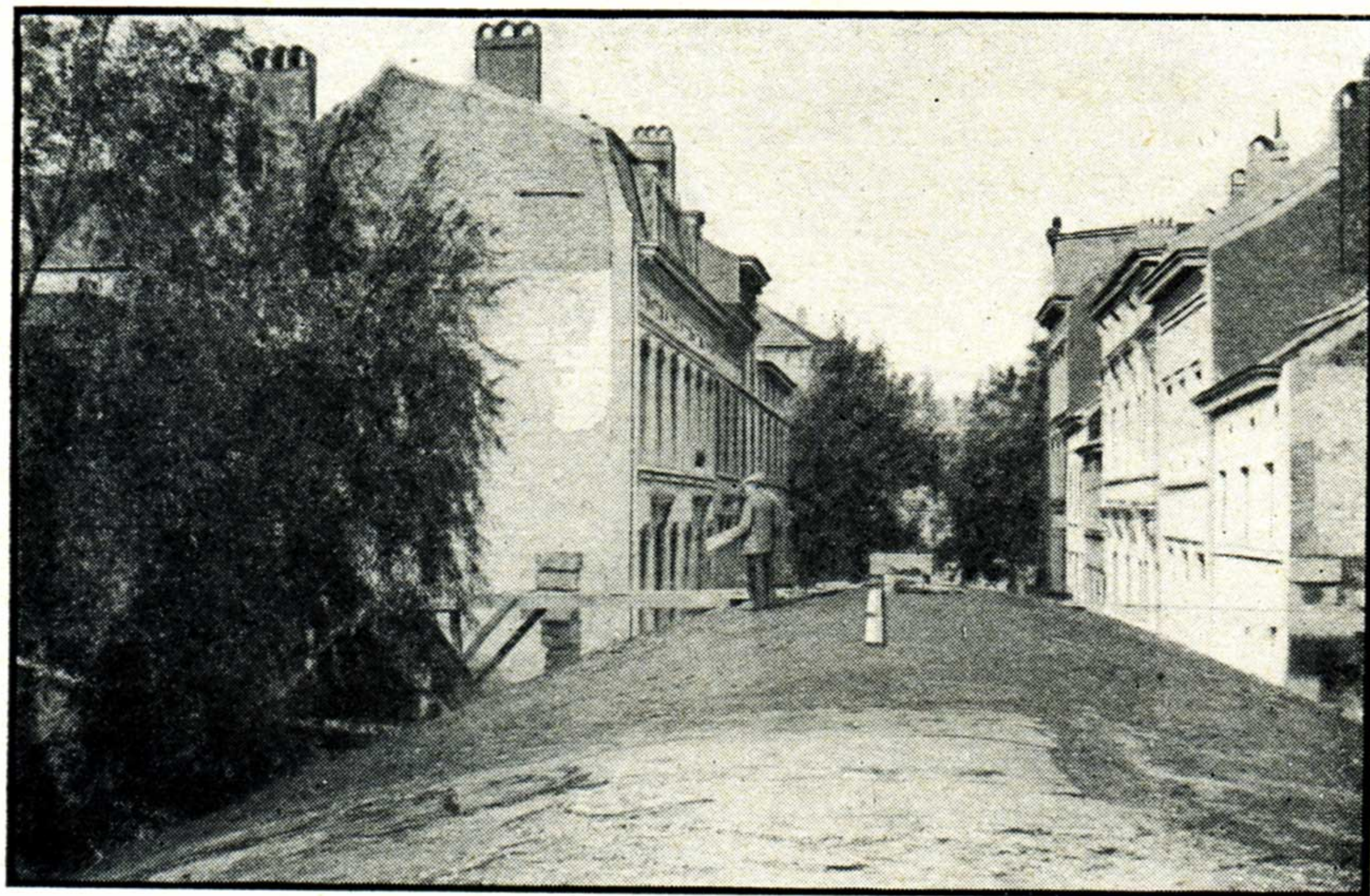
Extrados du pont de la rue de La Fontaine (1914). (Cliché Franchimont.)
