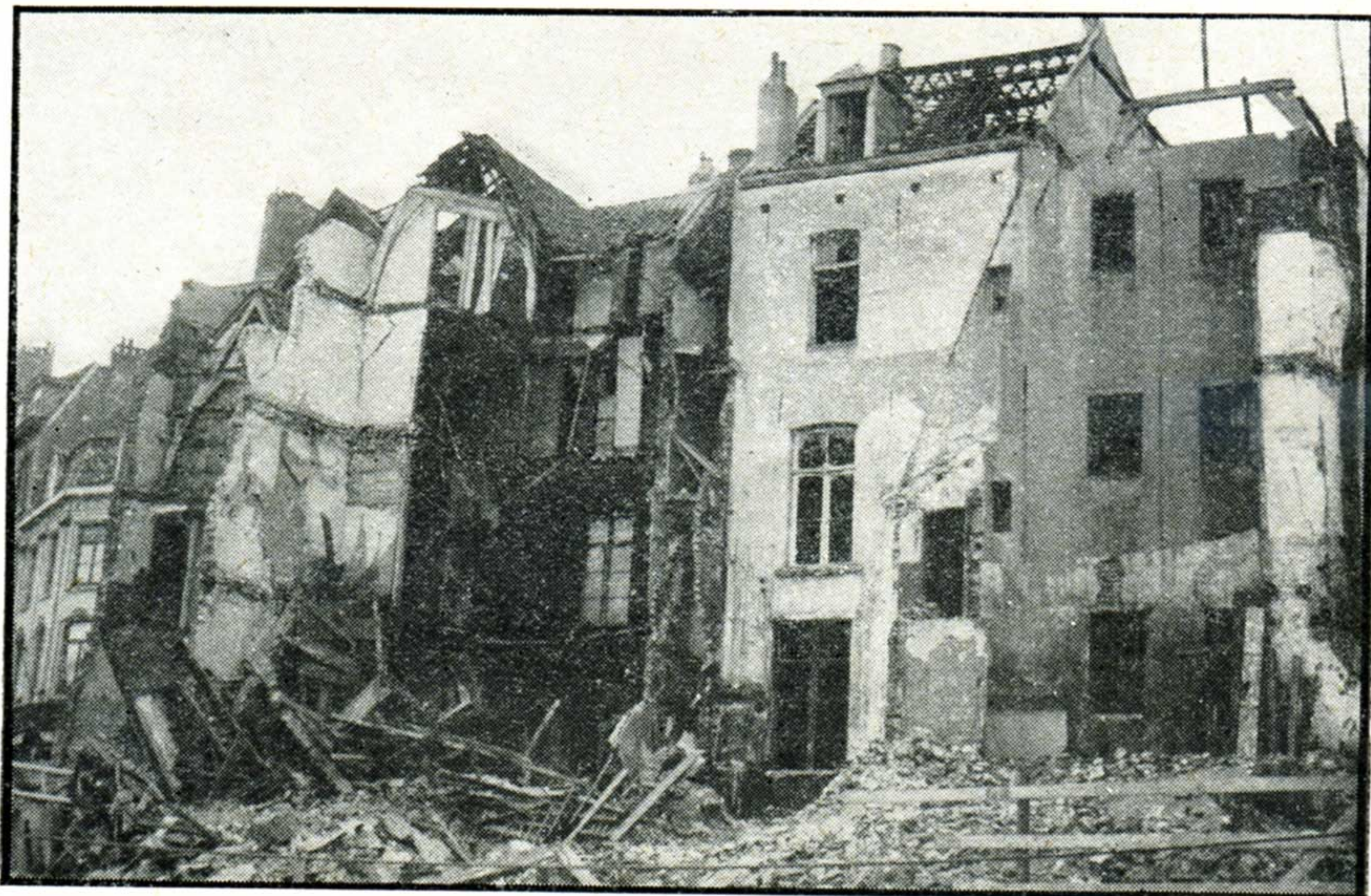
Démolition des quartiers vétustes de Bruxelles.
