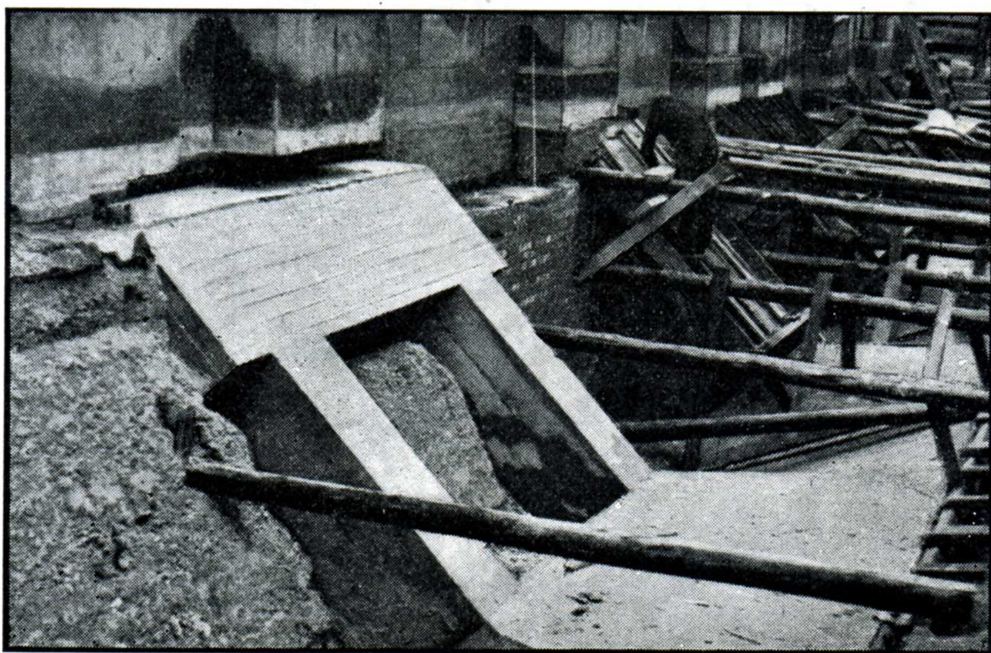
Mars 1942. — Ponts expérimentaux de la rue Van der Weyden. — Renforcement de la culée sud au moyen de contreforts.
