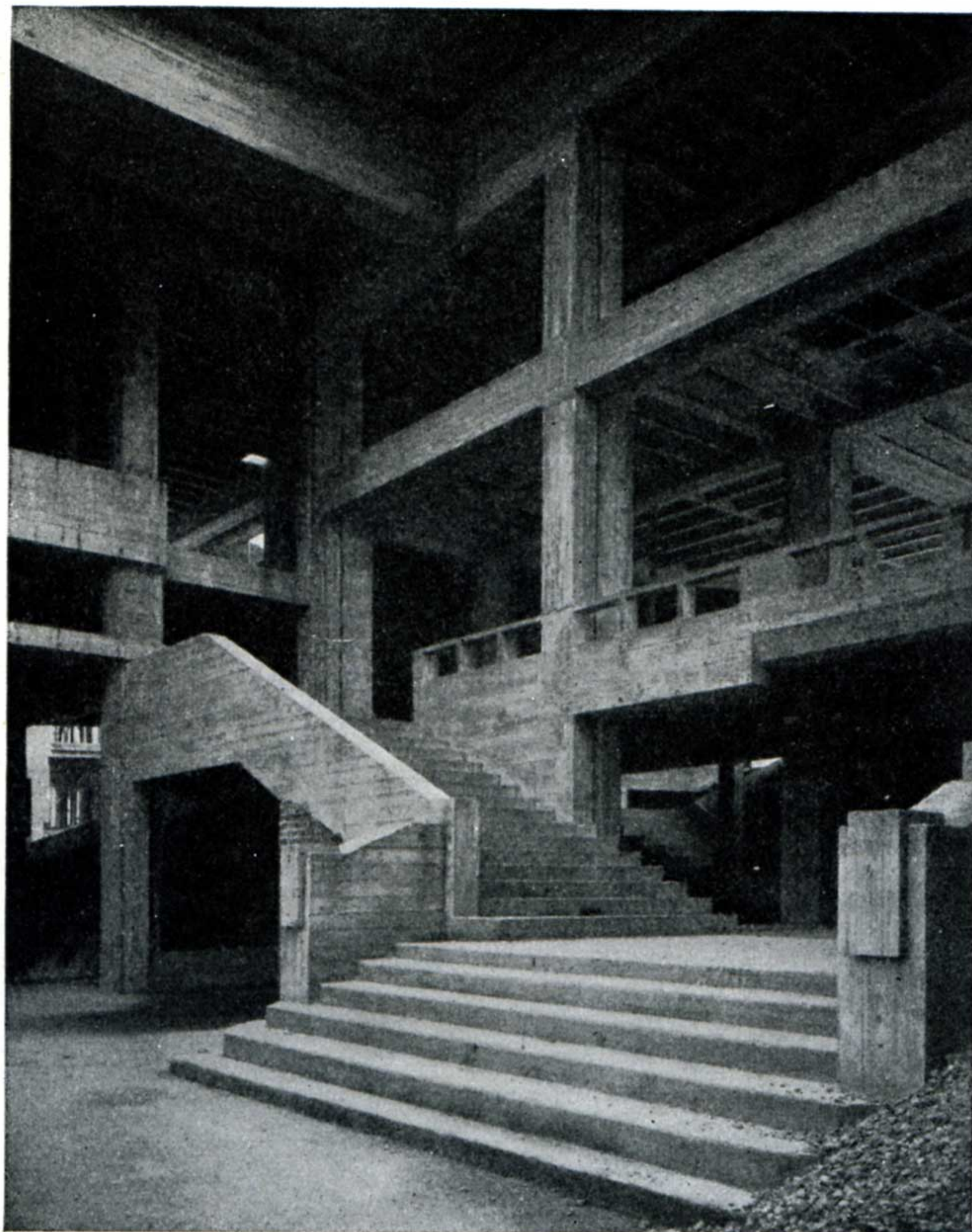
Halle de la Halte Centrale. — Vue de l'escalier d'entrée de la rue Cantersteen. (Cliché « La Technique des Travaux ».)
