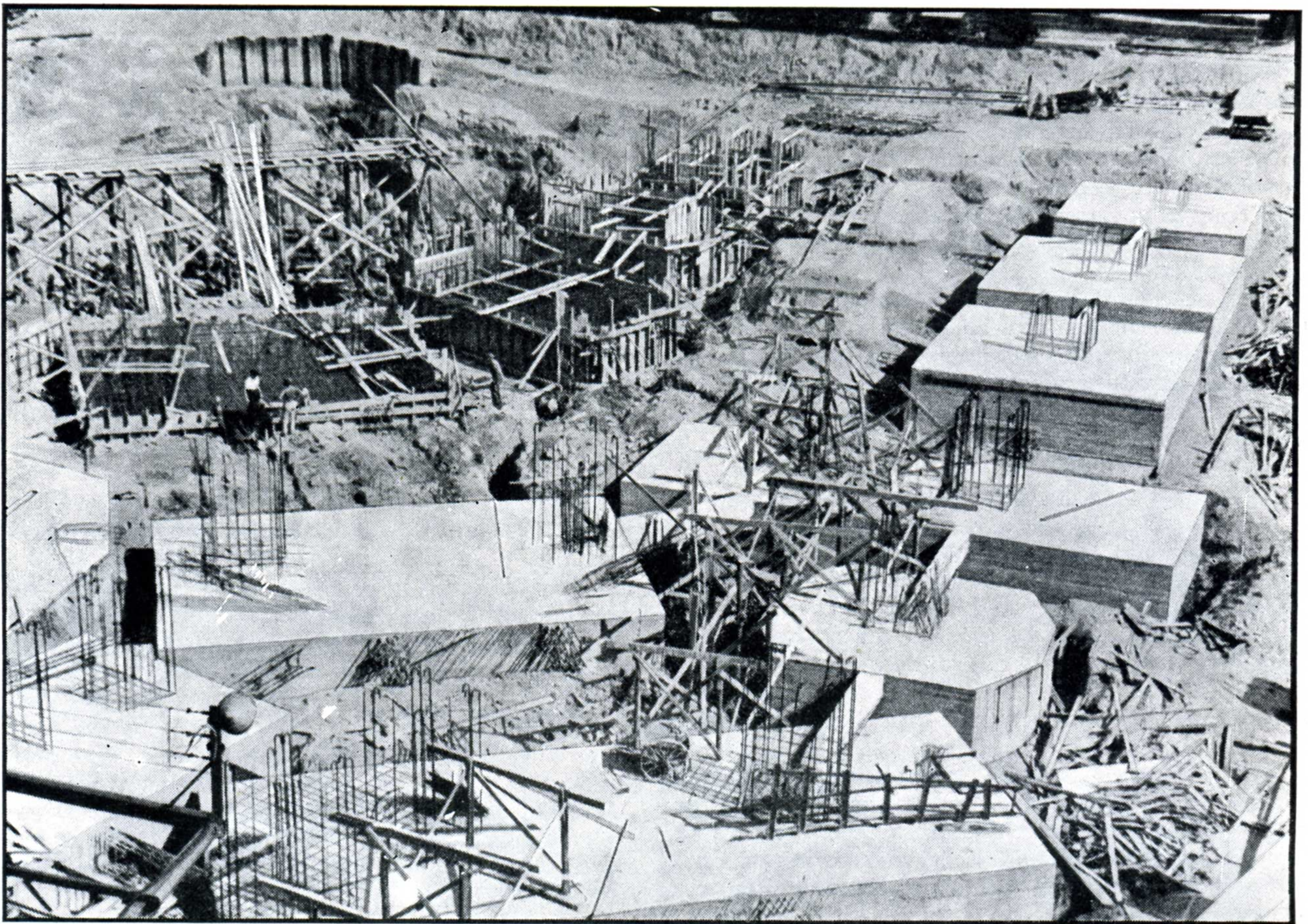
Août 1947. — Pont de la rue Couverte. — Massifs de fondation des colonnes dans la partie courbe à proximité de la Tour. (Photo Van Haute)
