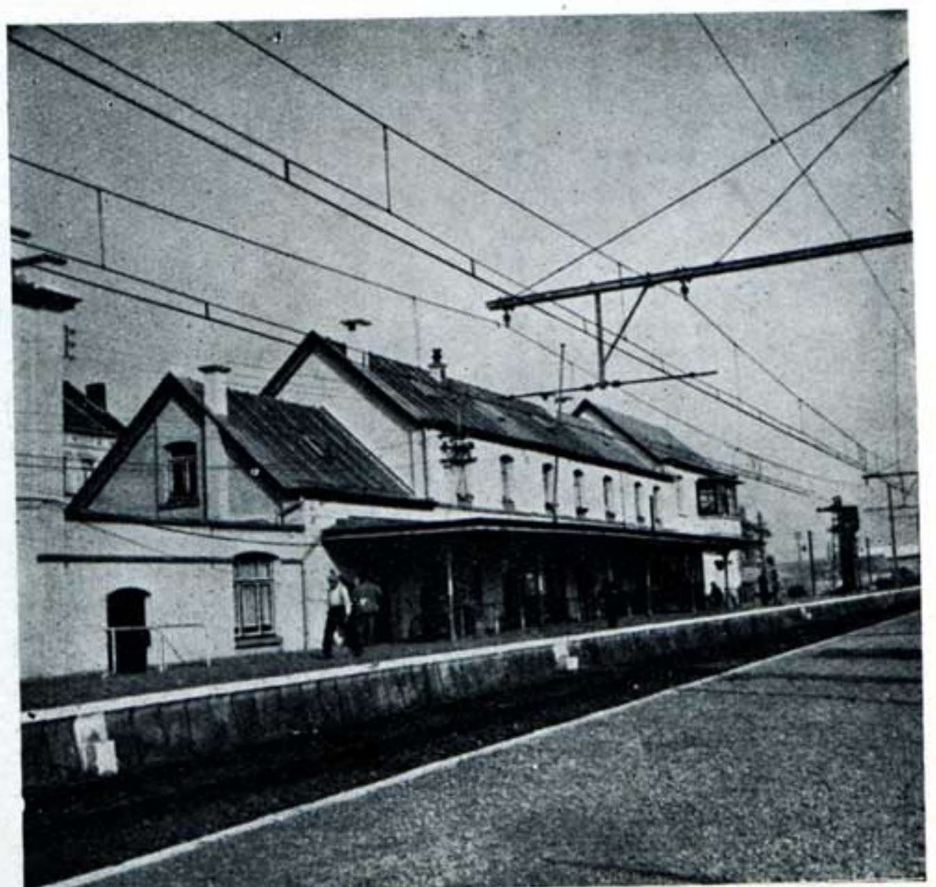
Fig. 10. — Braine-l'Alleud. — Nouvelle cabine et bâtiment des recettes modernisé.
