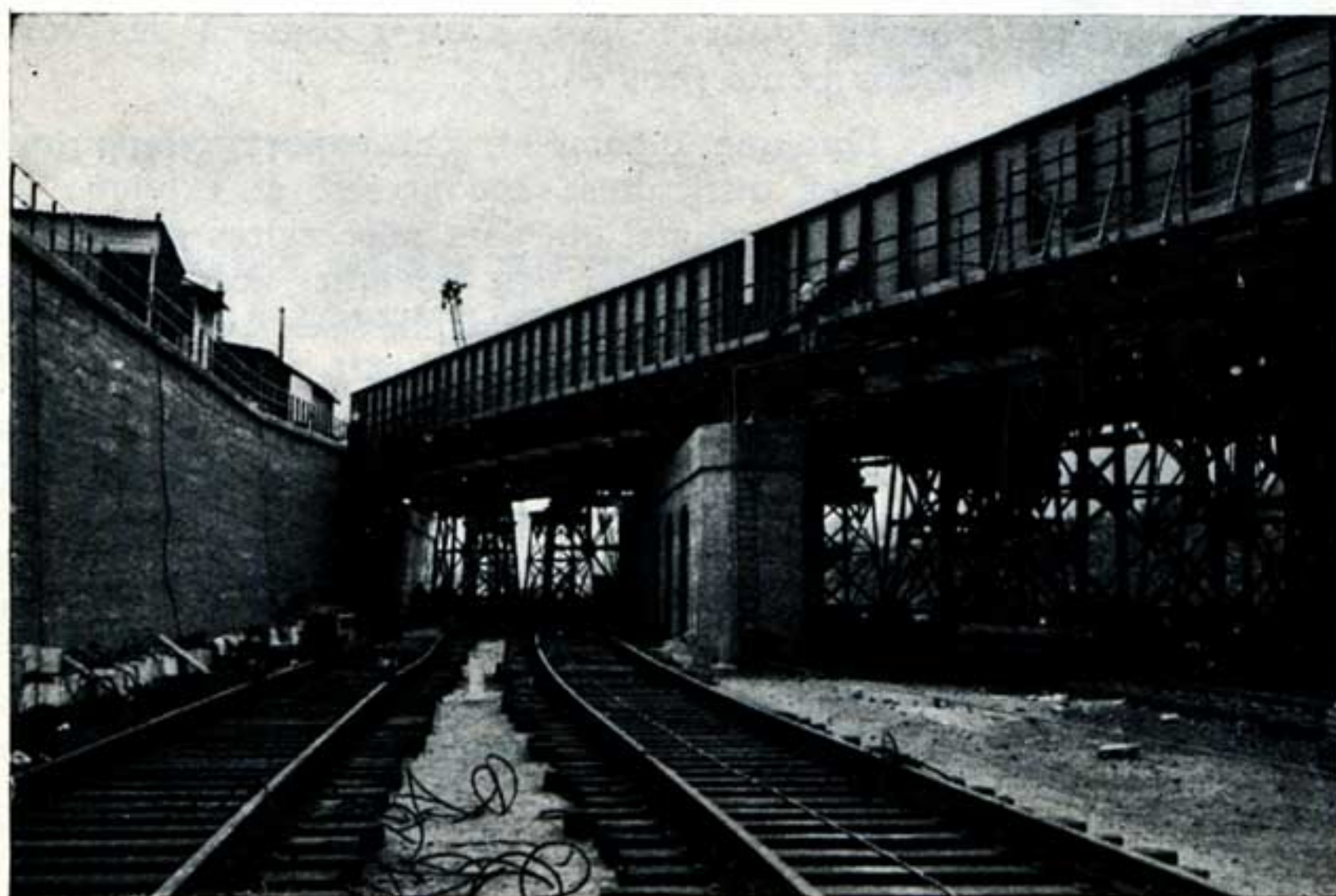
Fig. 14. — Monceau-Formation. — Pont de biais de 80 cm. en cours d'essai.
