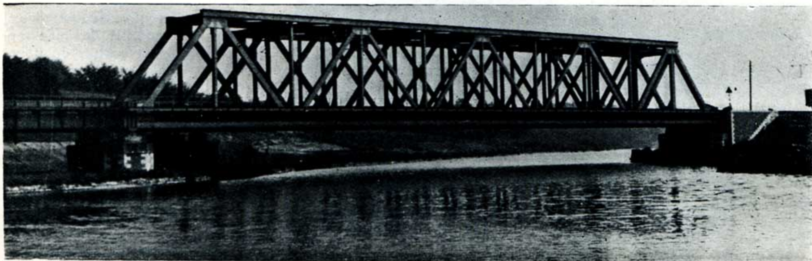
Fig. 6. — Luttre. — Pont métallique sur le canal.
