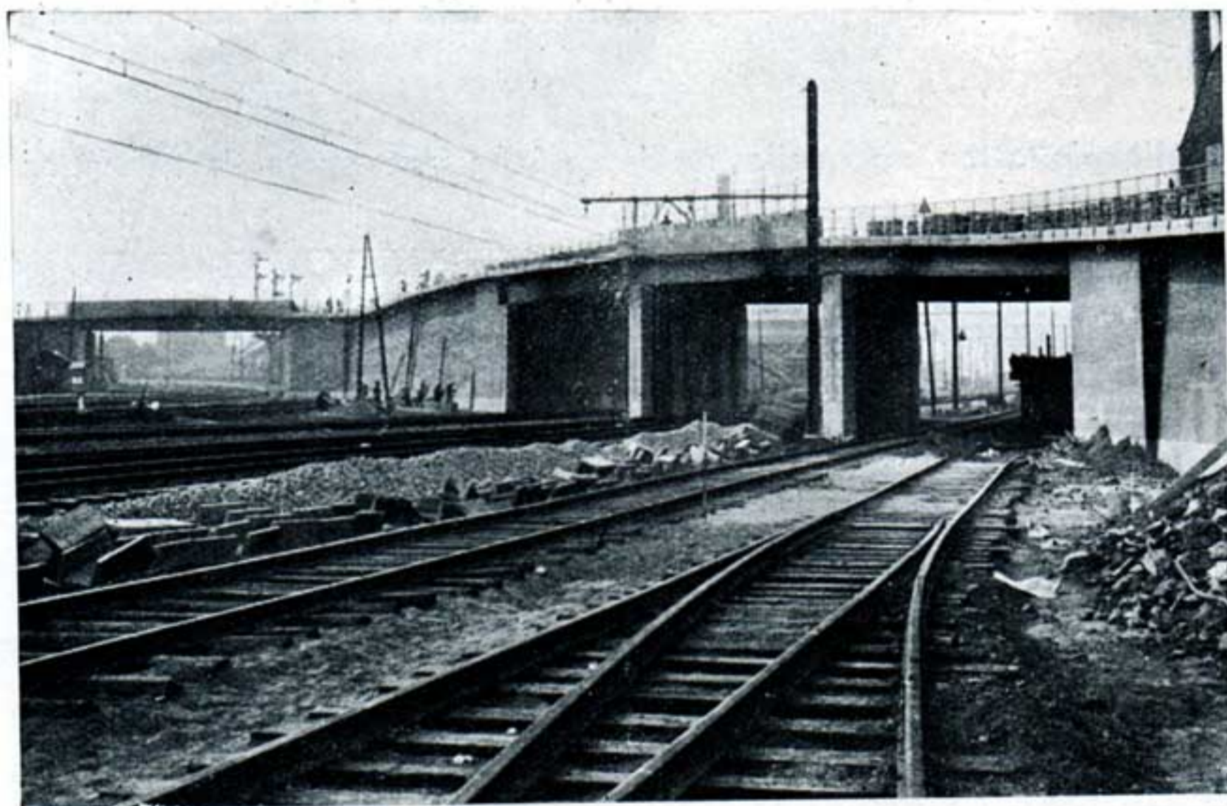
Fig. 8. — Marchienne Est. — Pont au-dessus des voies vers Bruxelles et Paris, construit dans le but de supprimer deux passages à niveau.
