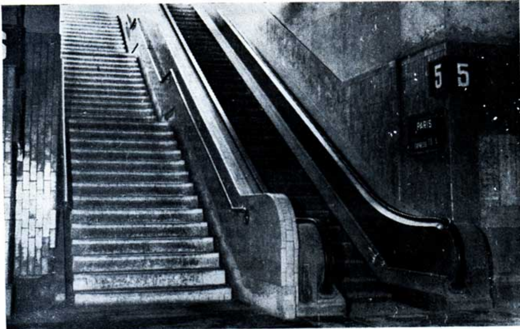
Escalier d'accès aux quais.
