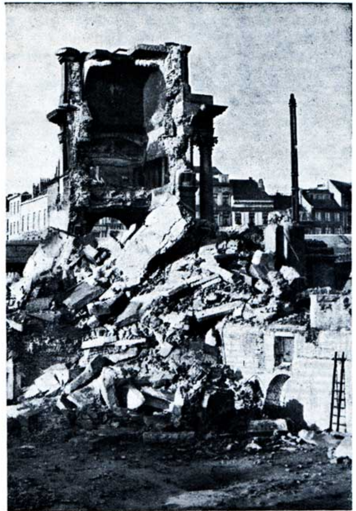
La démolition du portique de l'ancienne gare de Bruxelles-Midi.
