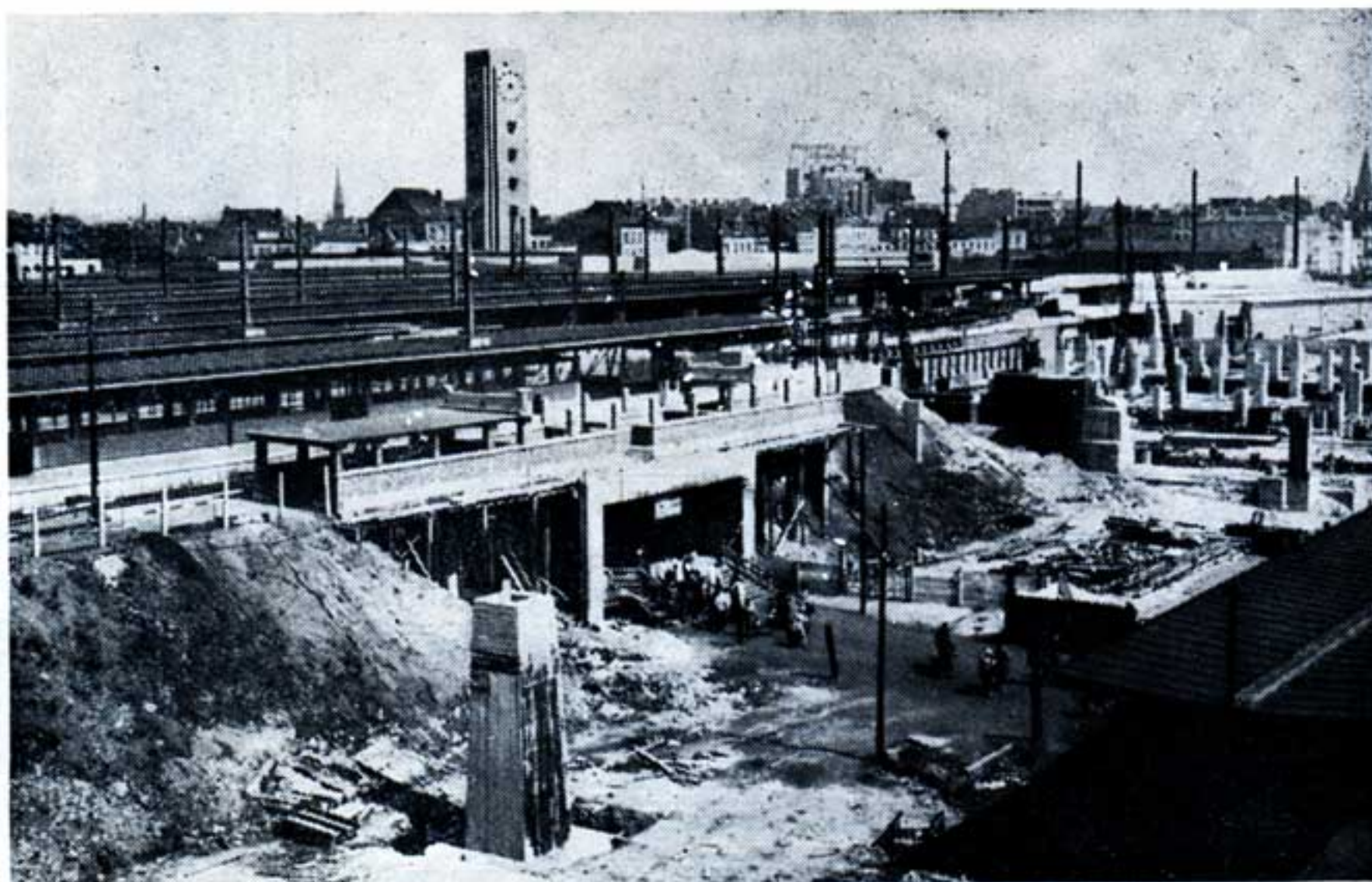
Le couloir transversal en cours de construction.
