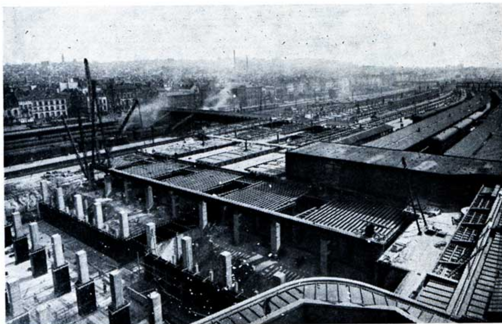
Vue d'ensemble des travaux fin 1947 montrant la passerelle provisoire.
