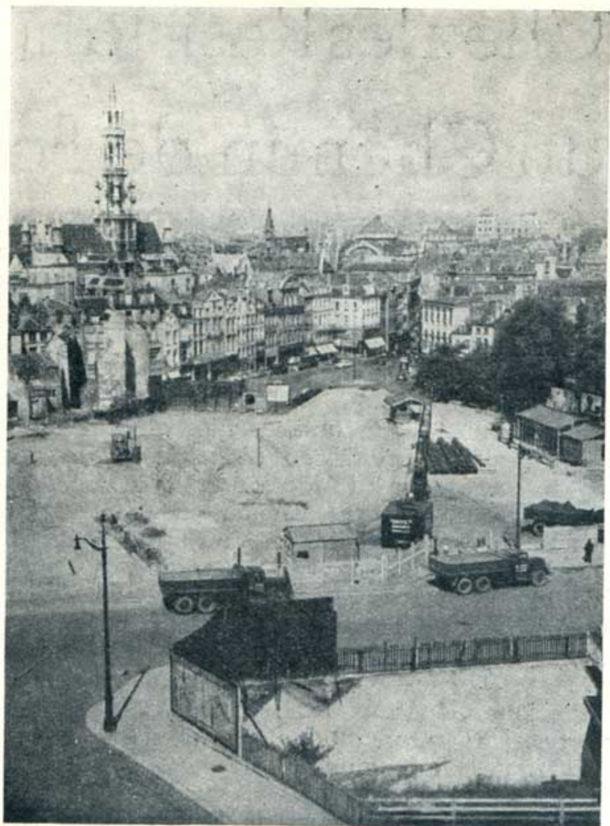
Vue des travaux en cours.
