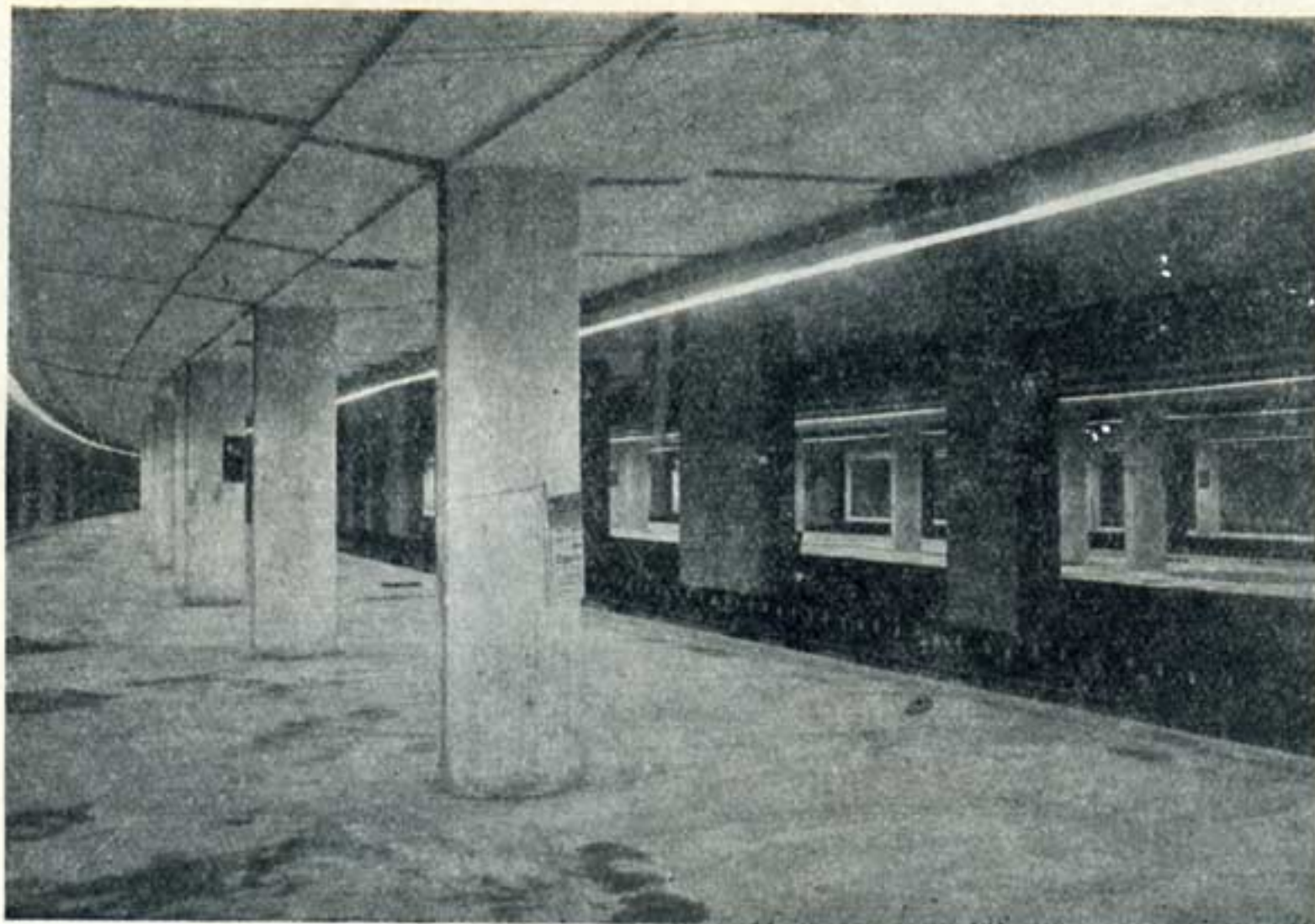
Fig. 21. — Vue des quais de la Halte Centrale le gros-œuvre terminé.
