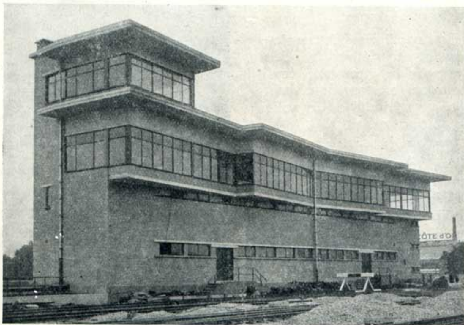
Fig. 16. — Bruxelles-Nord. Cabine « Sud » de signalisation. Façade côté voies.
