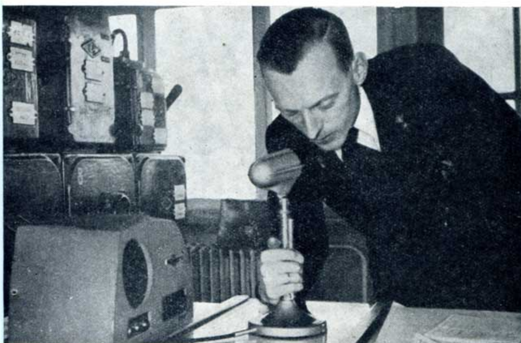
Fig. 26. — Poste émetteur-récepteur dans la cabine de triage de Schaerbeek.
