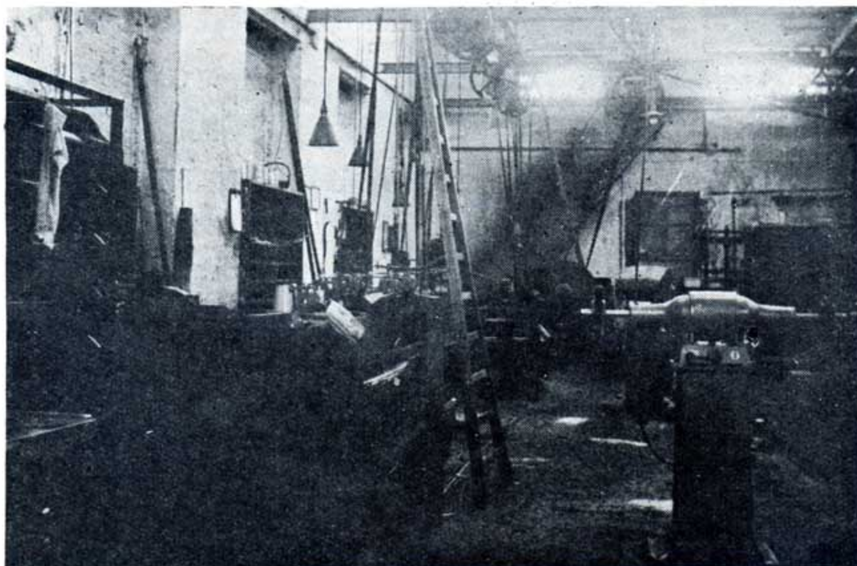
Fig. 34. — Transmission par courroies pour machines-outils.
