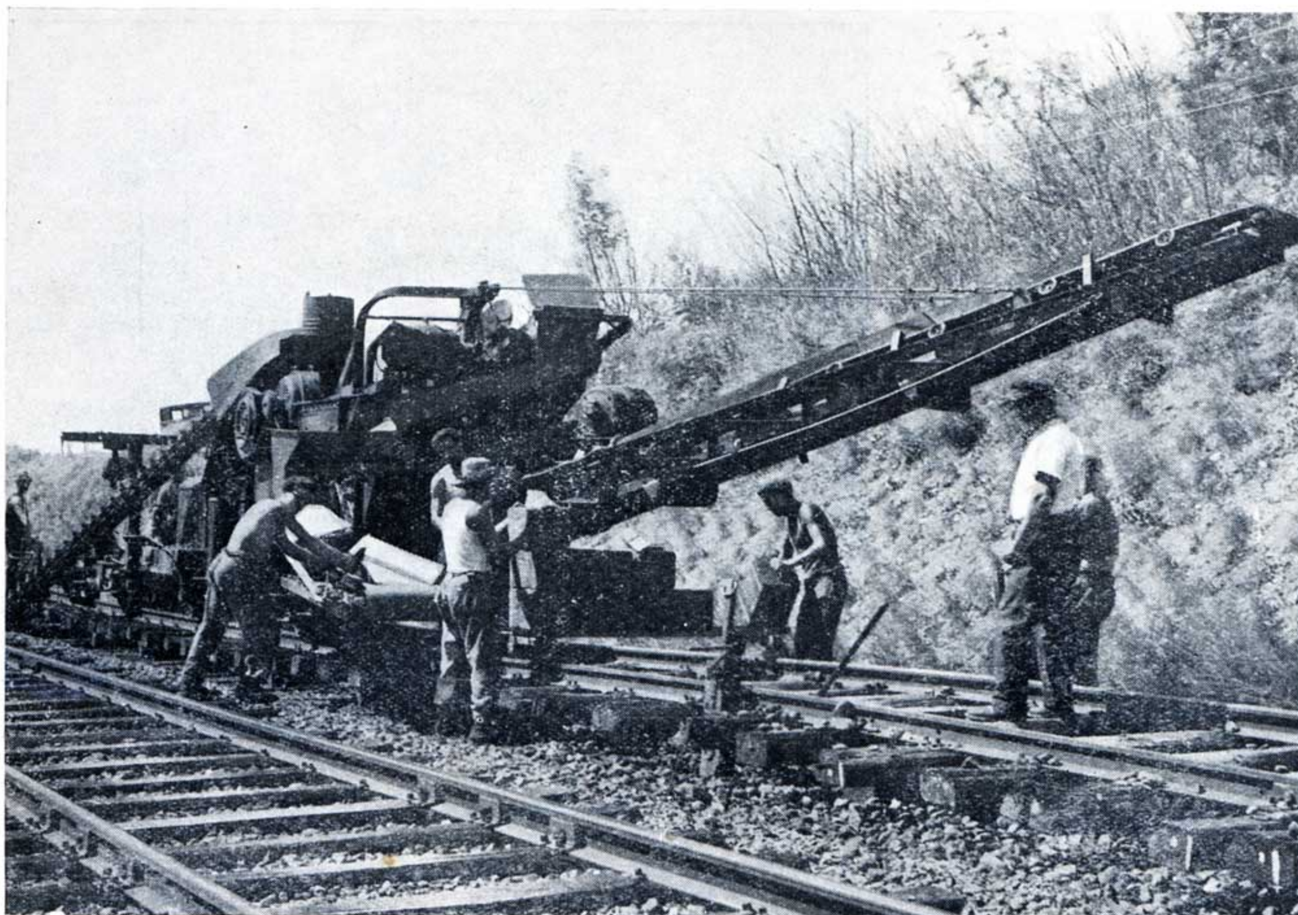
Fig. 3. — Cribleuse Matisa au travail.
