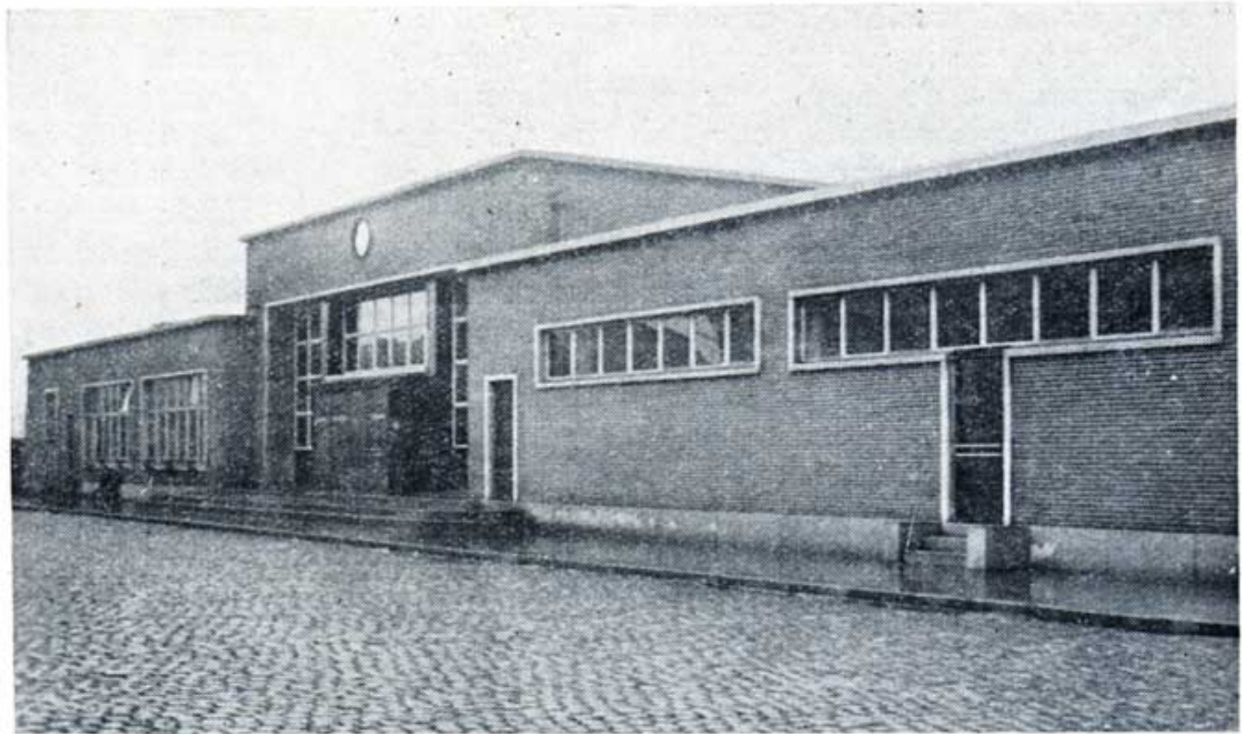
Fig. 7. — Nouvelle gare de Grammont.
