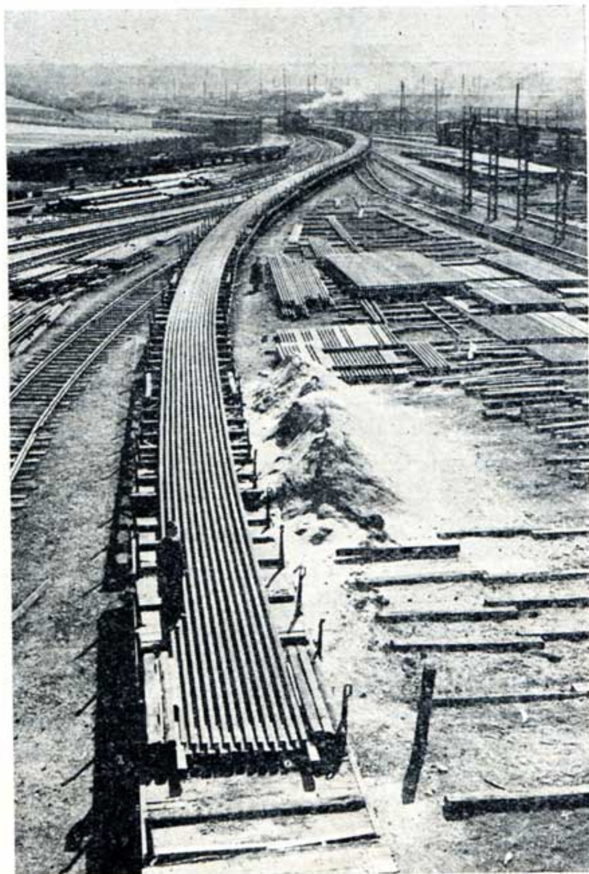
Fig. 1. — Rails de grande longueur chargés sur wagons.
