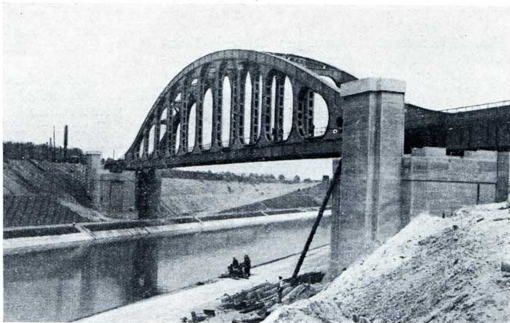
Fig. 10. — Pont de Gellick sur le Canal Albert.
