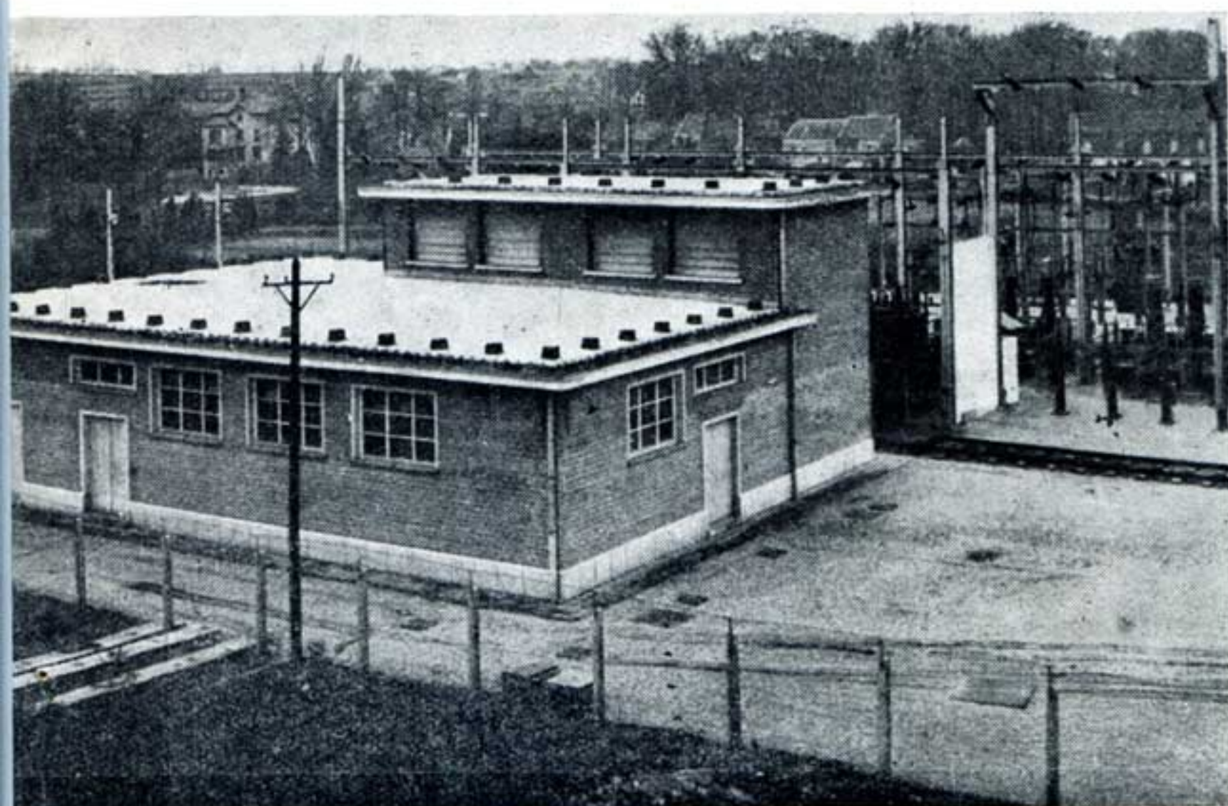
Fig. 45. — Baulers. Vue extérieure de la sous-station de traction électrique.
