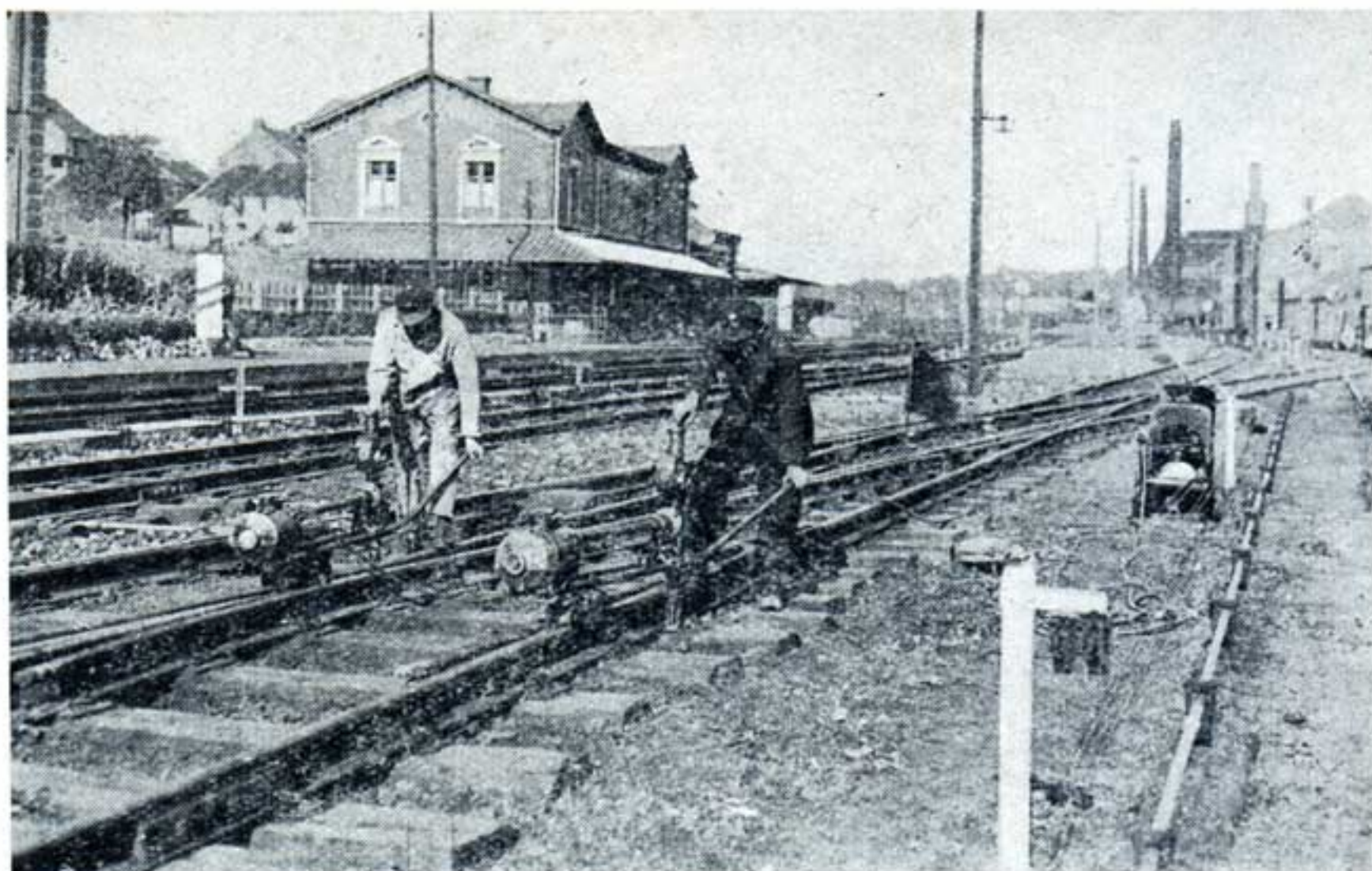
Fig. 2. — Tirefonneuses mécaniques au travail.
