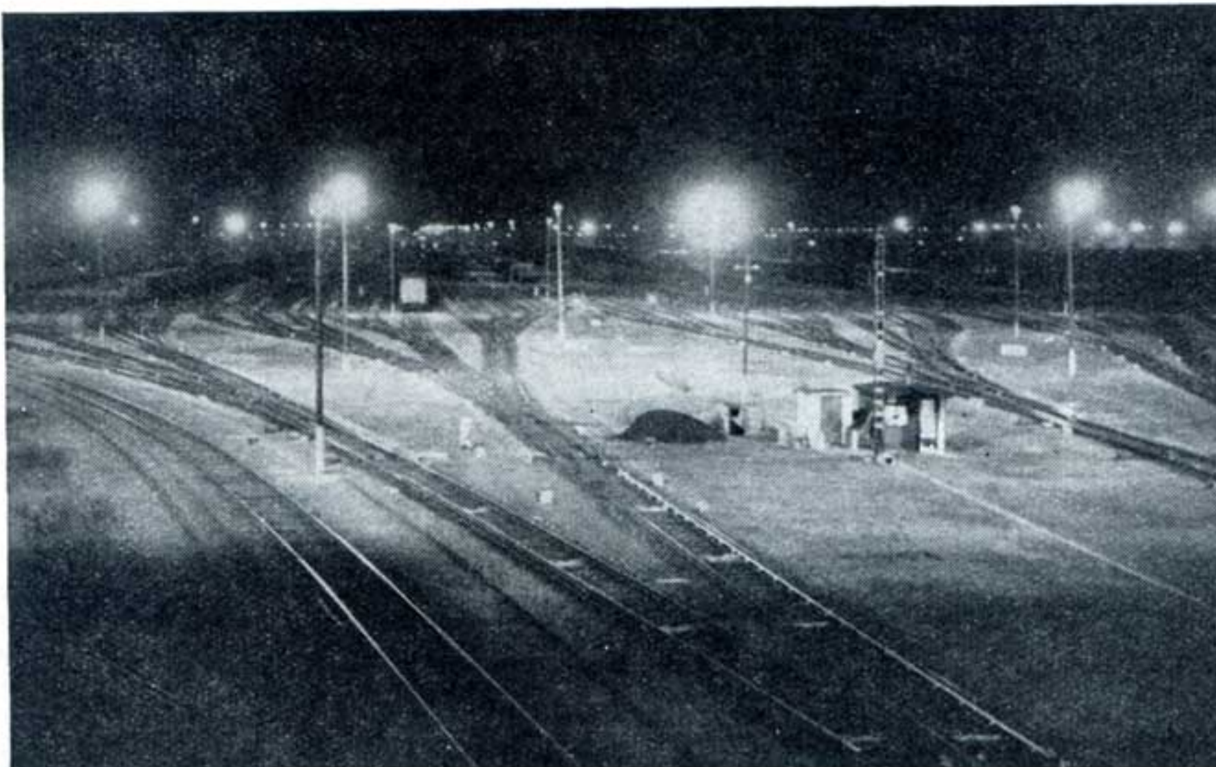
Fig. 30. — Eclairage de la gare de formation d'Anvers-Nord.
