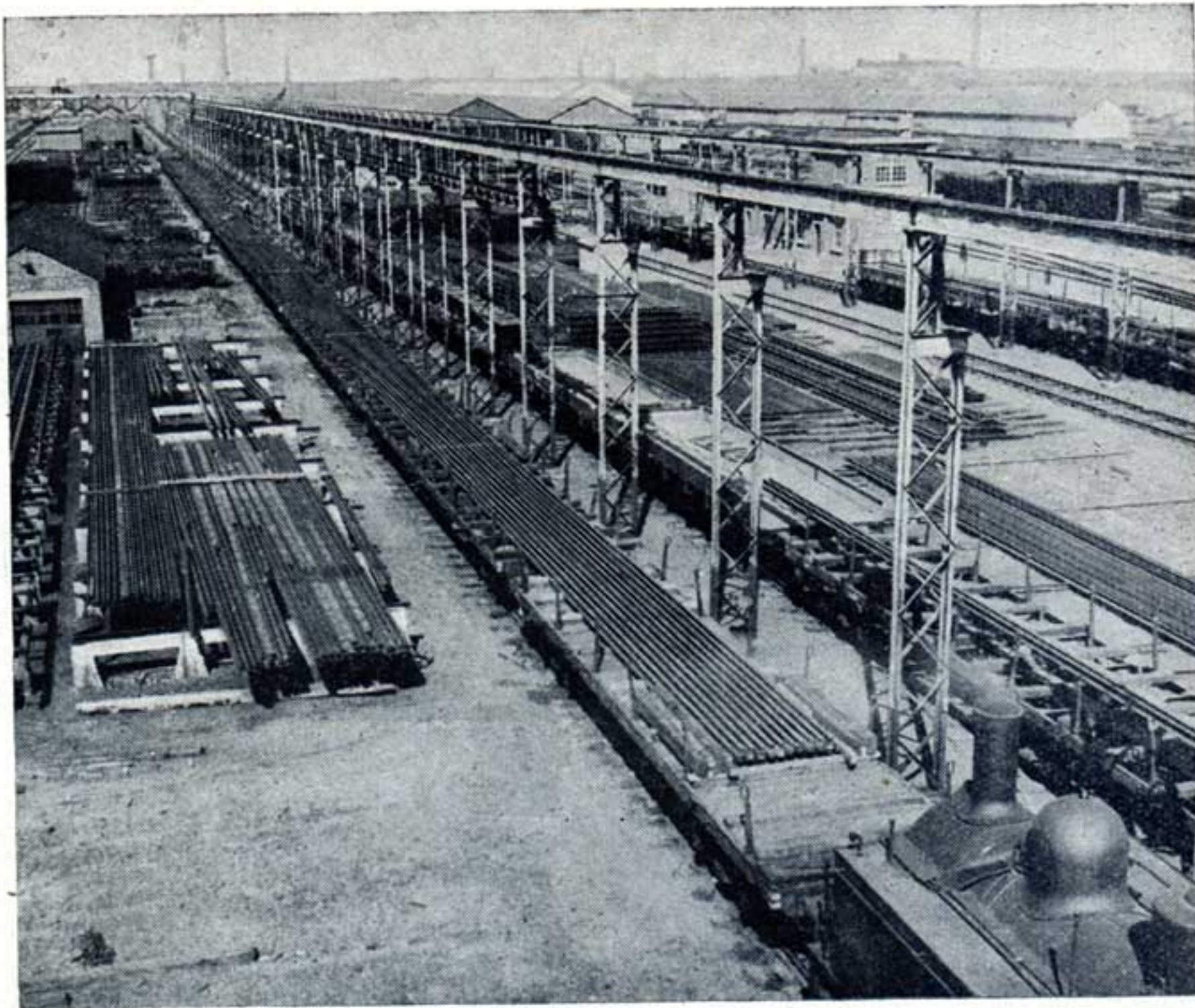
Fig. 4. — Vue partielle du dépôt de la voie à Schaerbeek.
