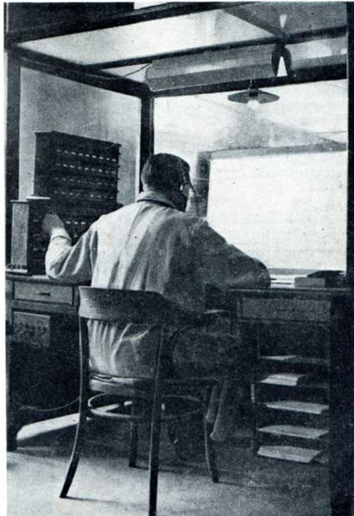
Fig. 23. Ancienne table de dispatching.
