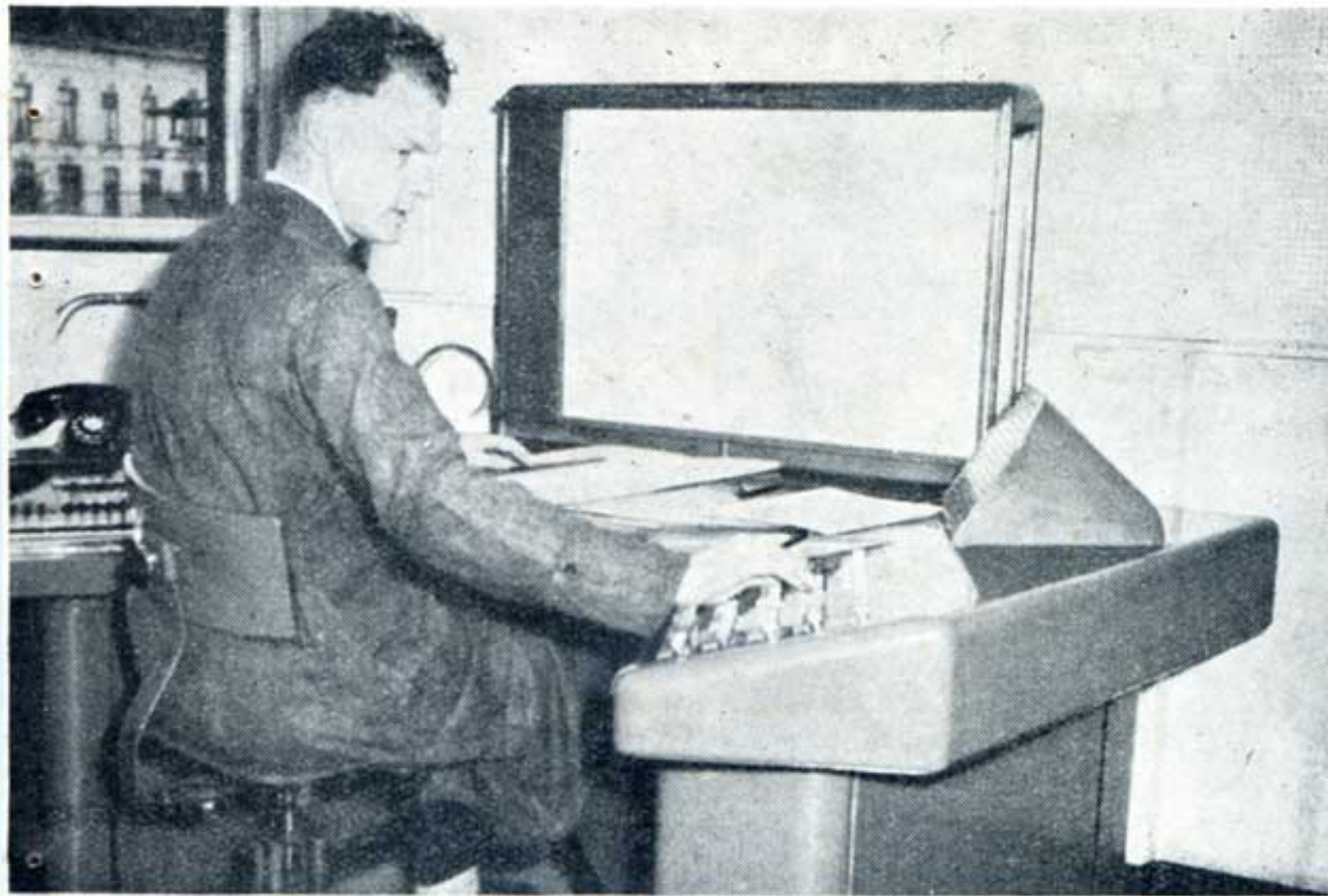
Fig. 24. — Nouvelle table de dispatching.
