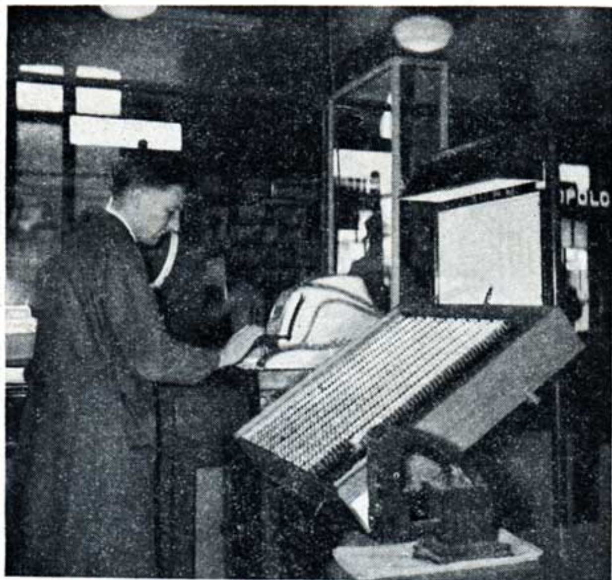
Distributeur de billets (machines Schuster).
