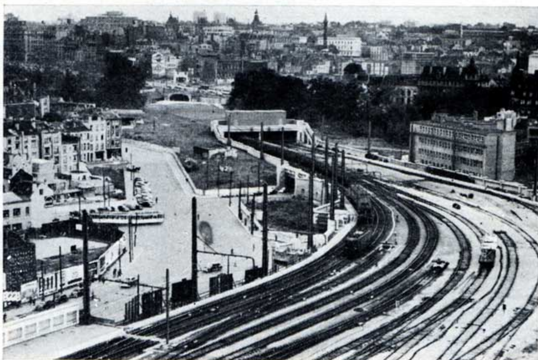
Bruxelles-Nord. — La tête nord du tunnel.
