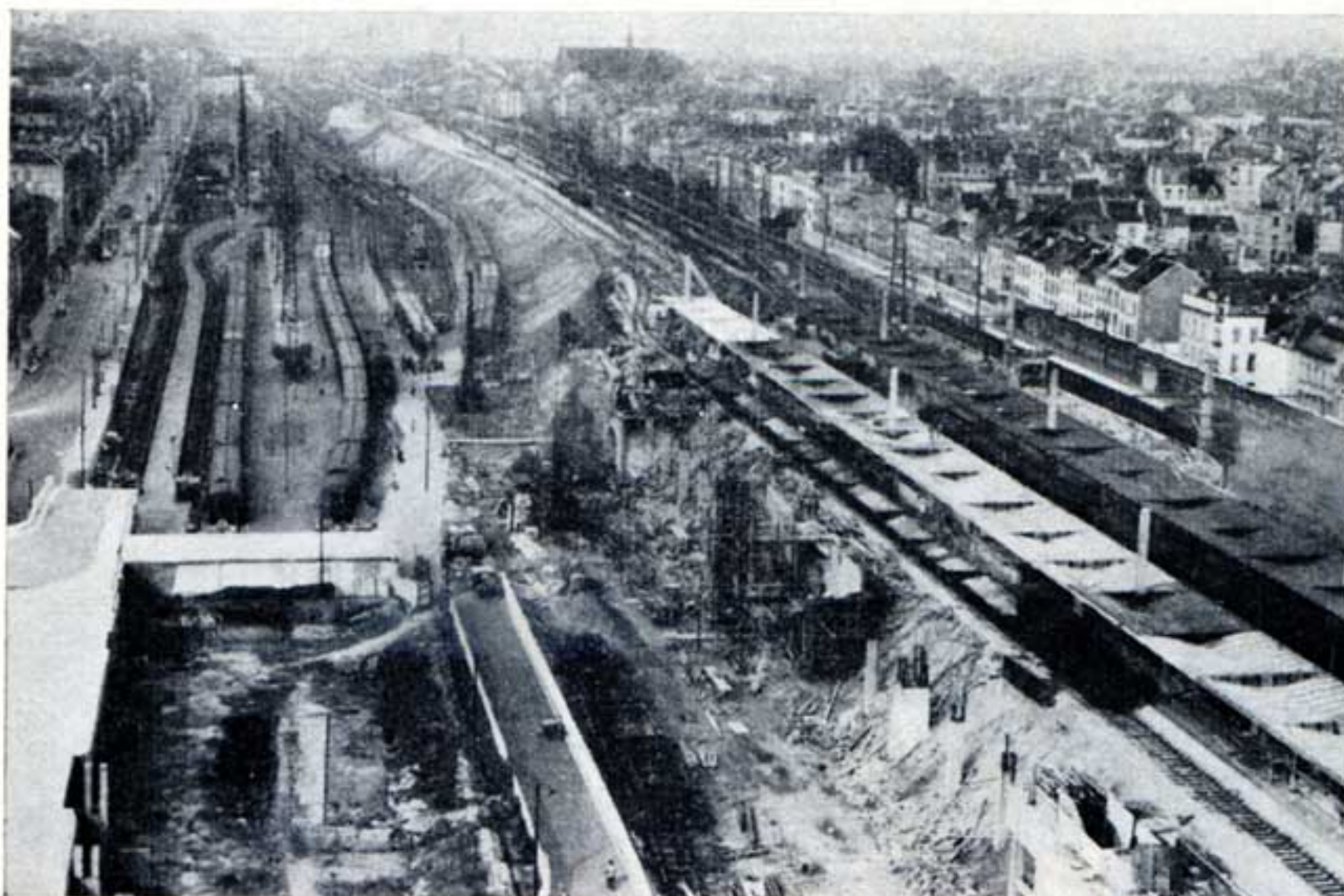
Bruxelles-Nord. — Les travaux de surélévation.
