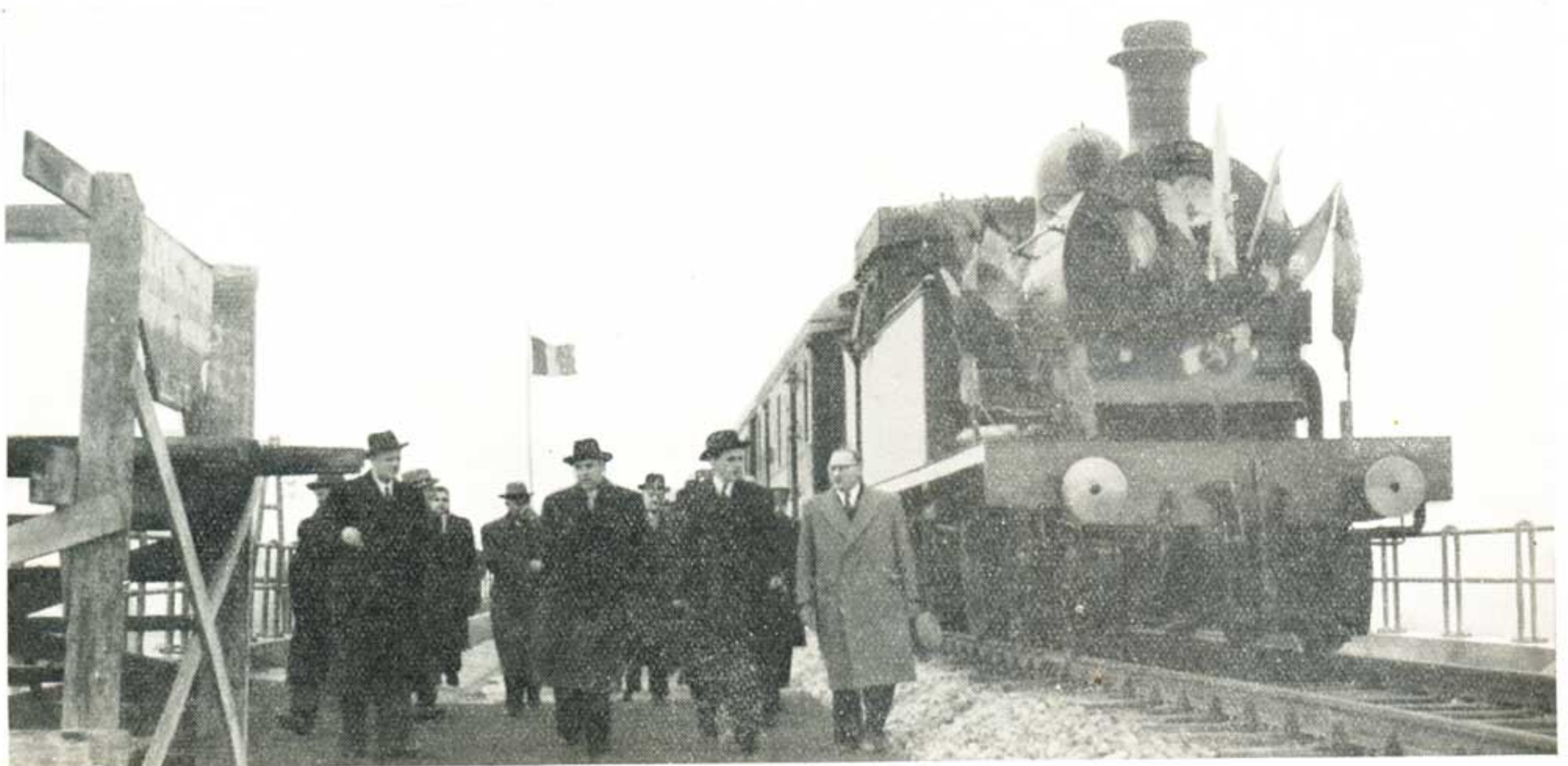
Le train inaugural sur les nouveaux ponts entre Zeebrugge et Heist.
