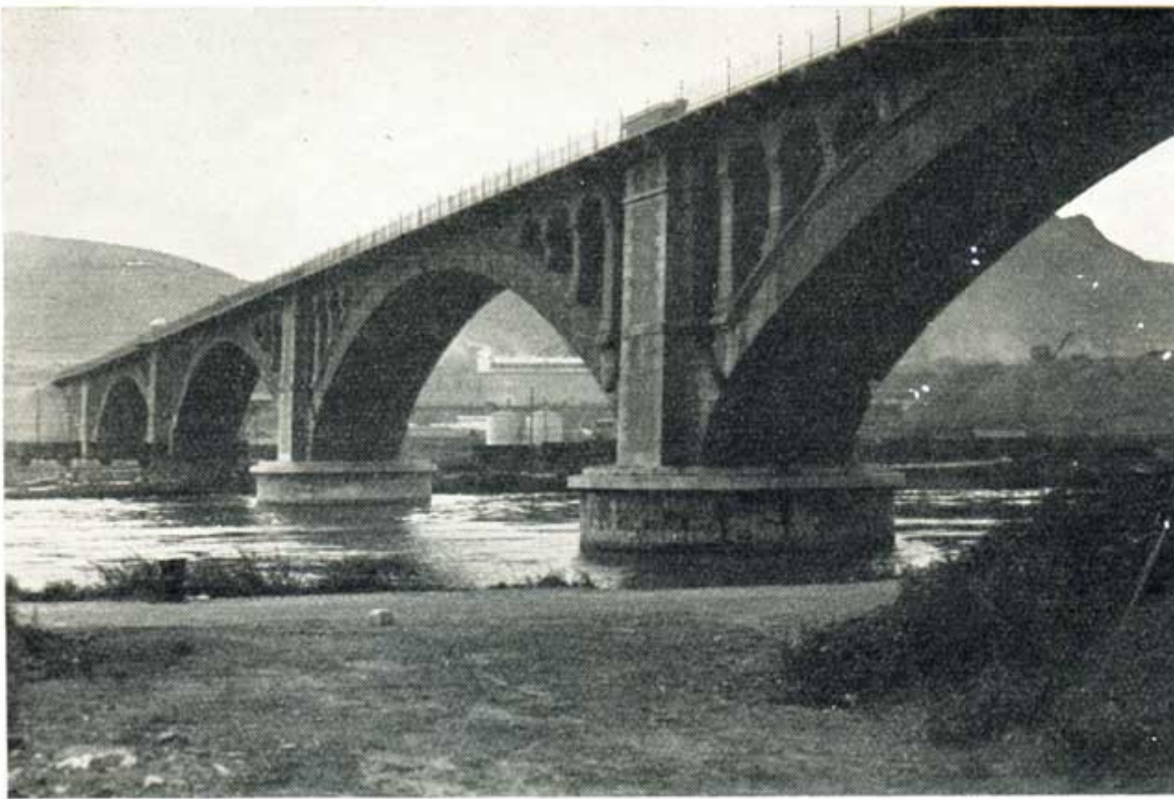
Viaduc de Renory
