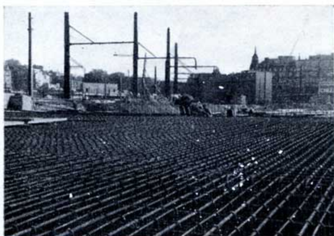
Fig. 4. — Platelage en béton armé (armatures).
