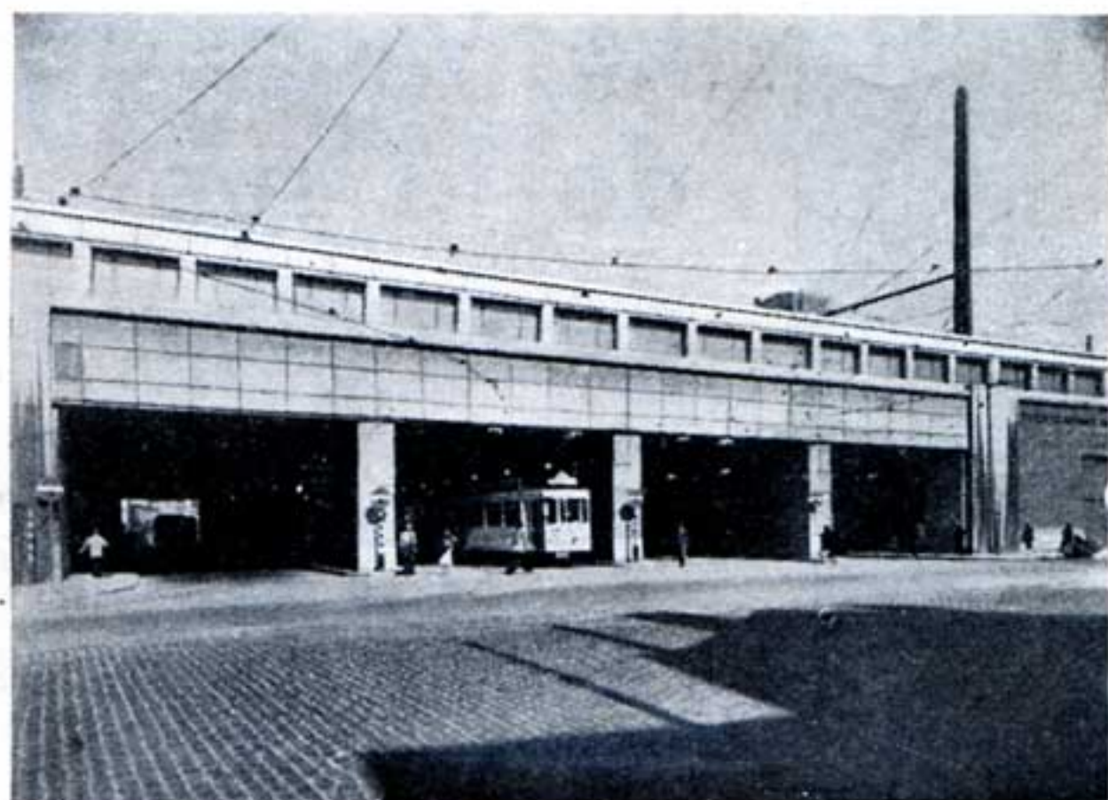
Fig. 3. — Façade côté rue de Brabant.
