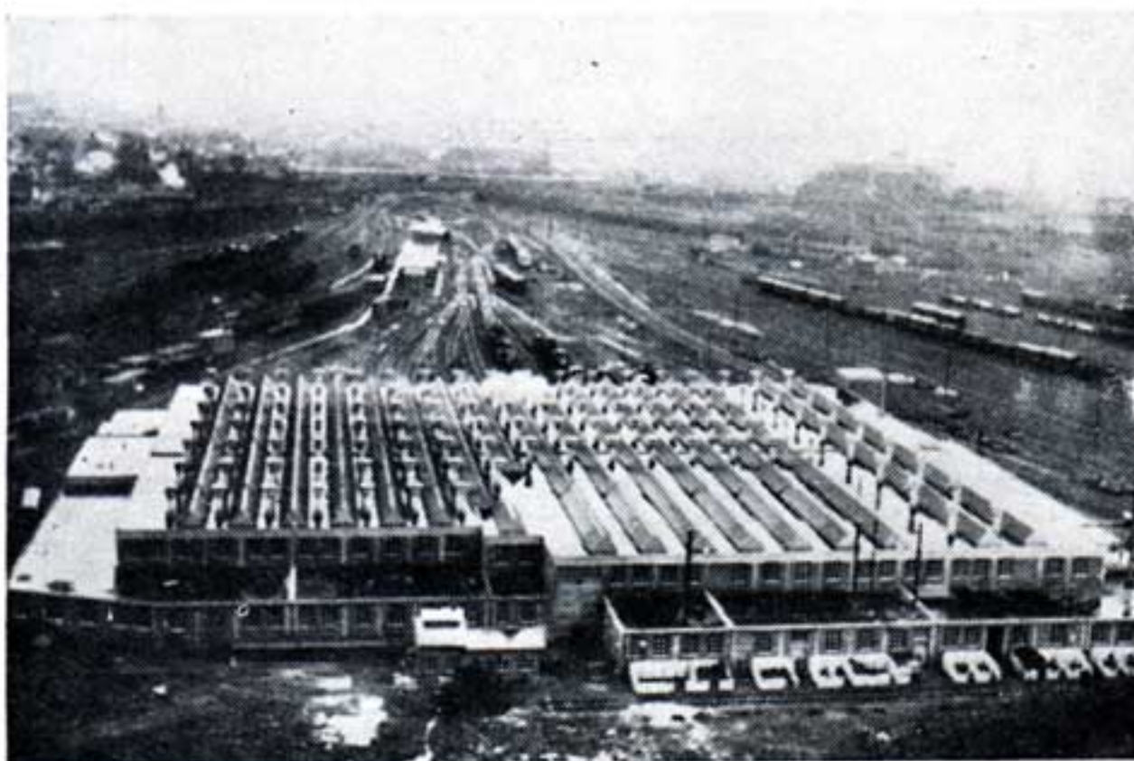
Remise de Haine-Saint-Pierre. — 10.415 m 2
