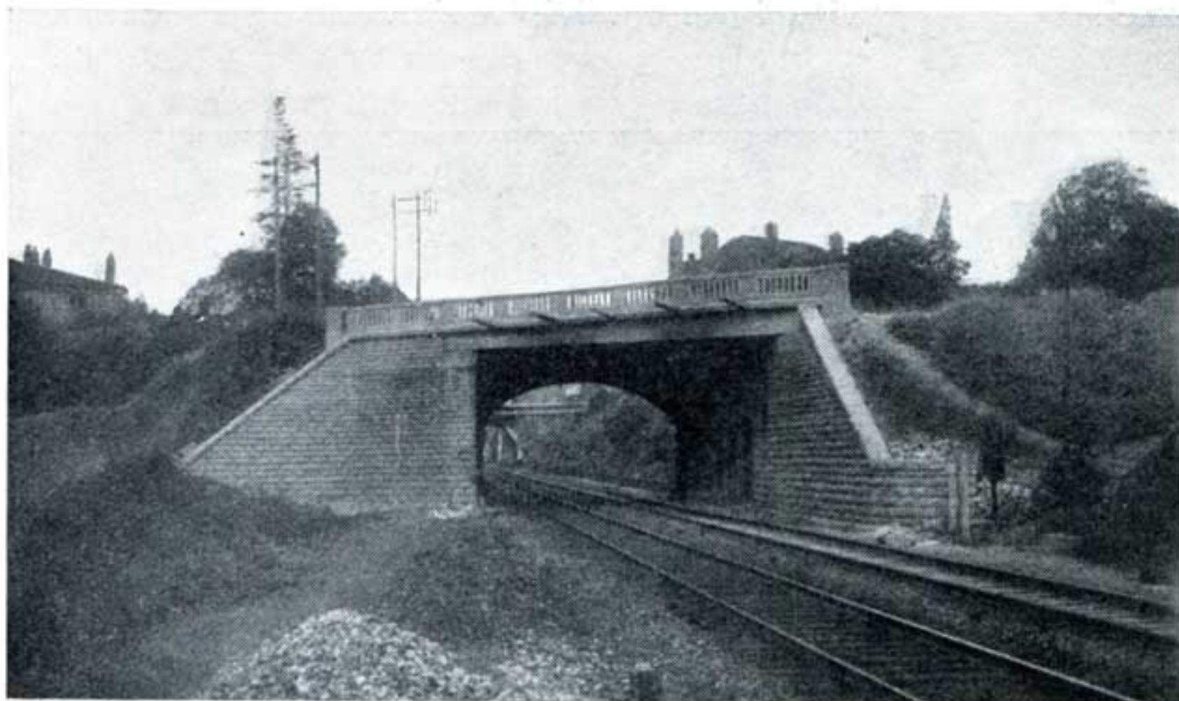
Pont de l'Héritère à Mâcon. — Cet ouvrage a dû être reconstruit. On aperçoit l'ouvrage en maçonnerie vouté.
