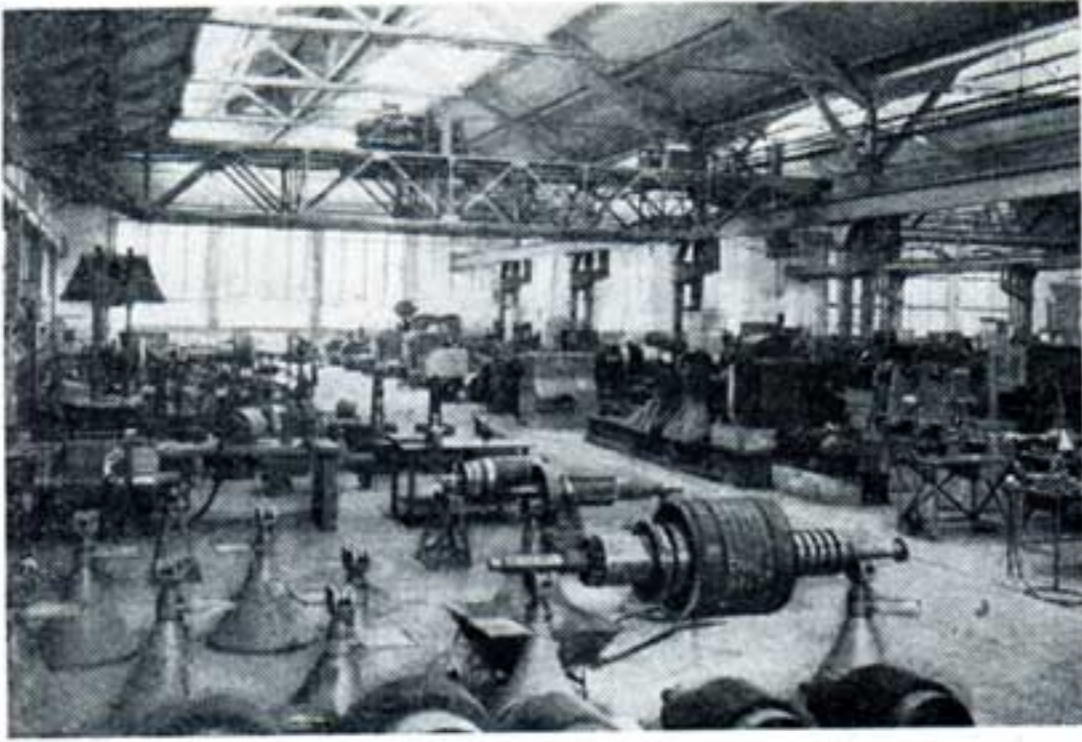
L'atelier de bobinage d'Oullins. Chantier de réparation des induits.
