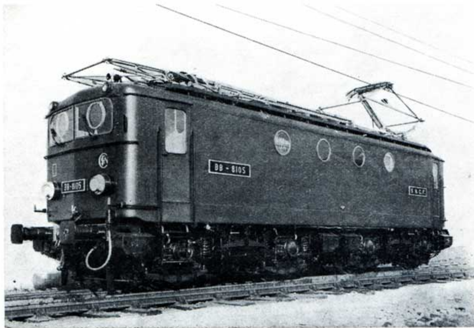
Fig. 3. — Locomotive BB à 105 km/h. pour services mixtes.
