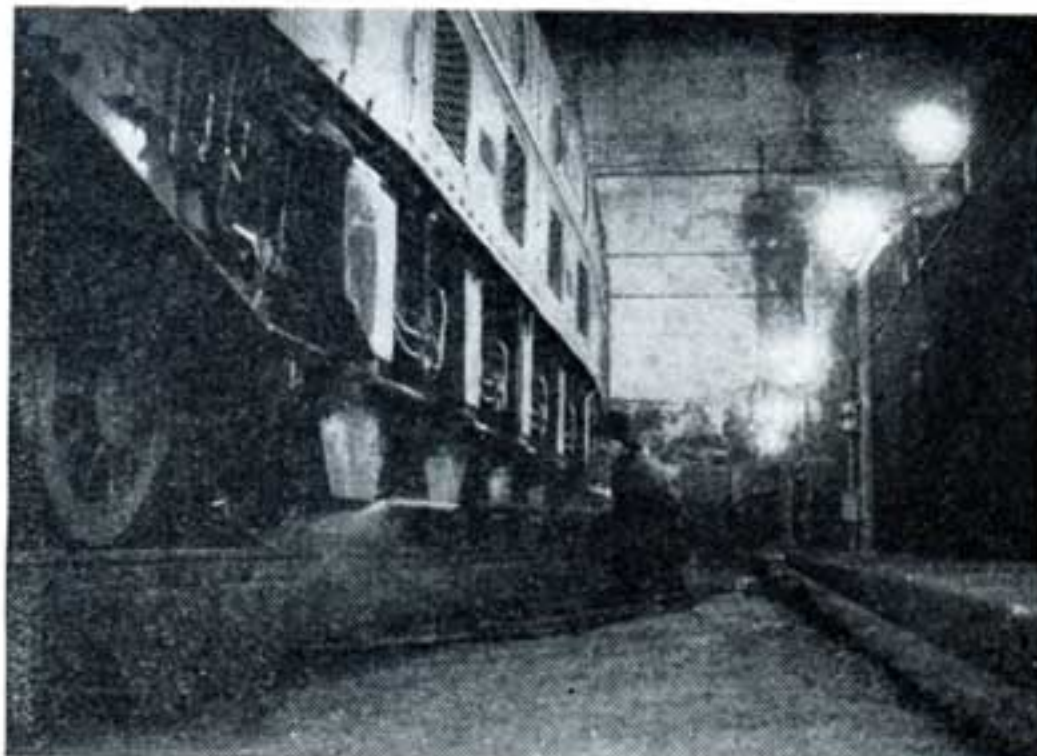
Poste de lavage au jet des 2D2 au dépôt de Paris.
