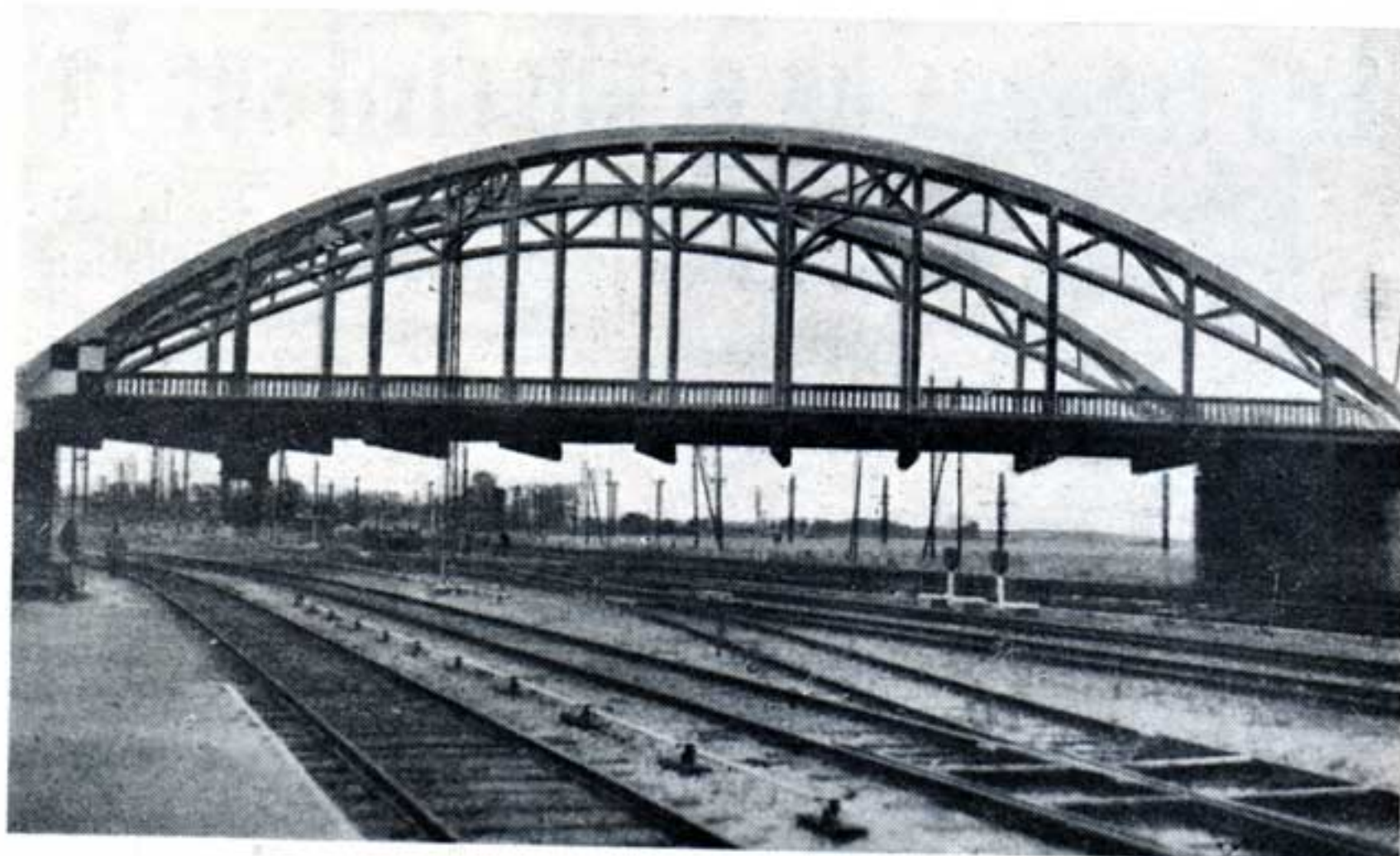
Saint-Florentin. — Exhaussement du P.S. du Km 172,499 (Côté Paris).
