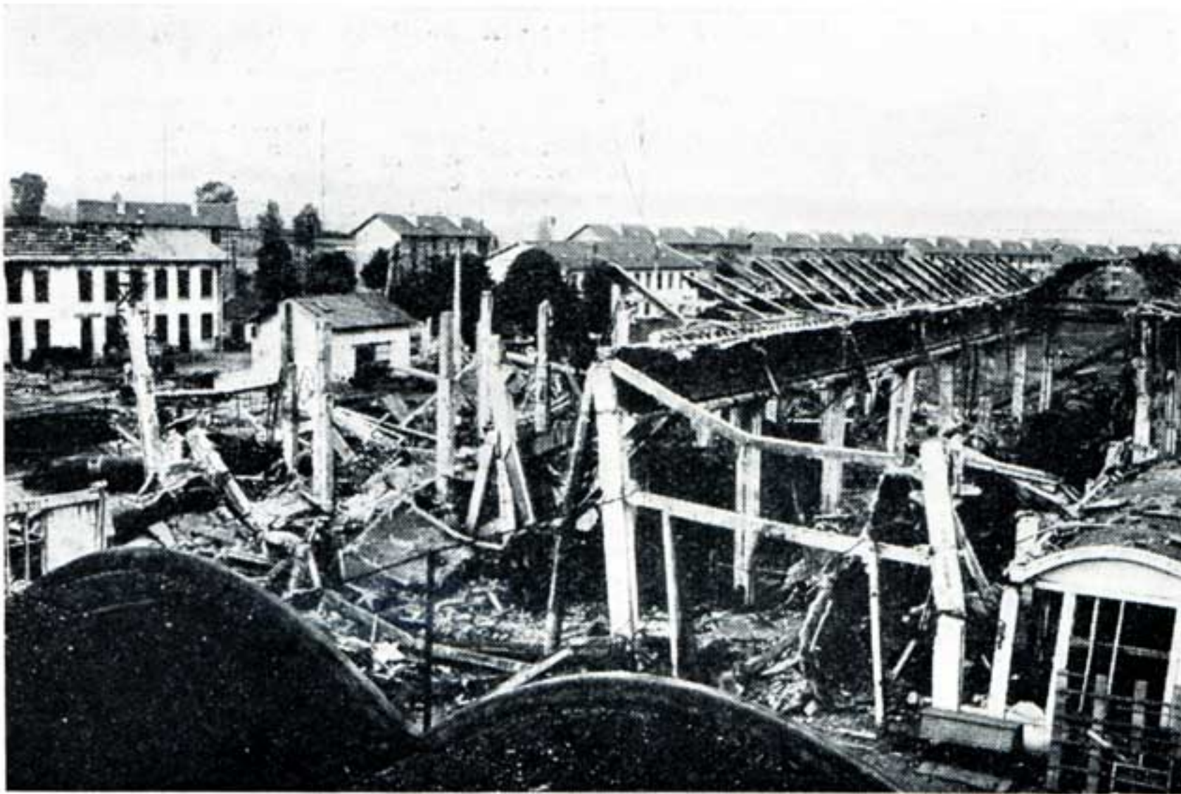
Atelier du dépôt des Laumes. En prévision de l'électrification, cette rotonde et ces ateliers n'ont pas été reconstruits.
