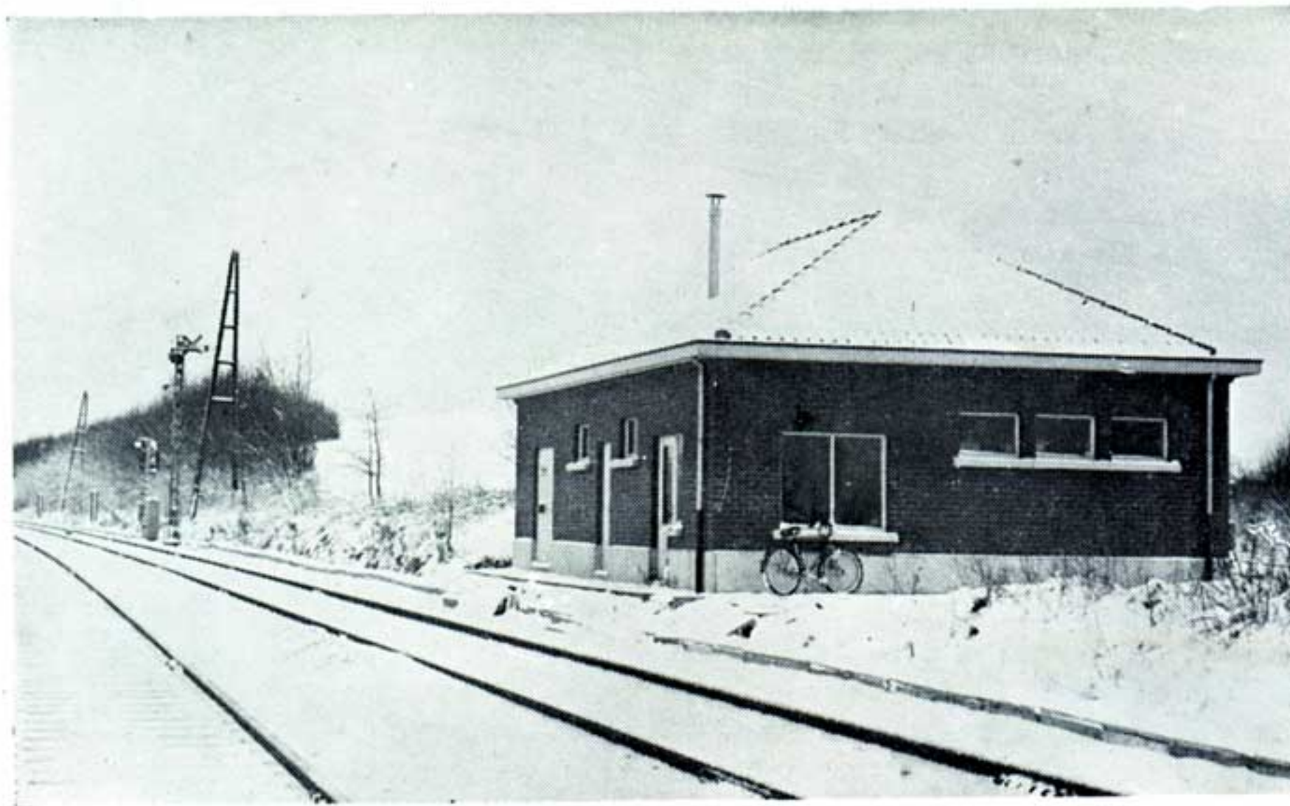
Vue extérieure du poste satellite télécommandé.
