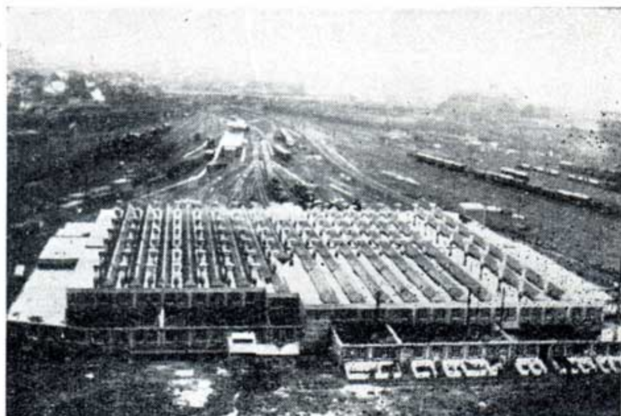
Remise à locomotives de Monceau.
