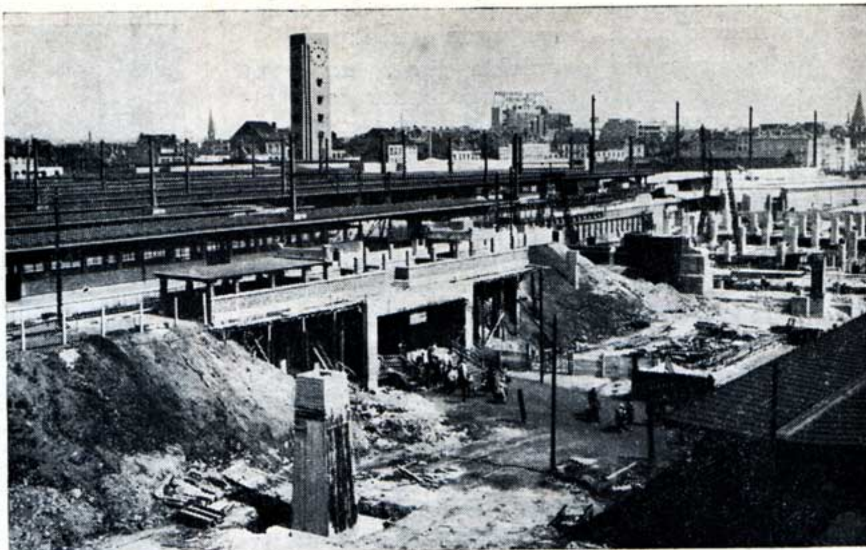
De dwarsgang in uitvoering.
