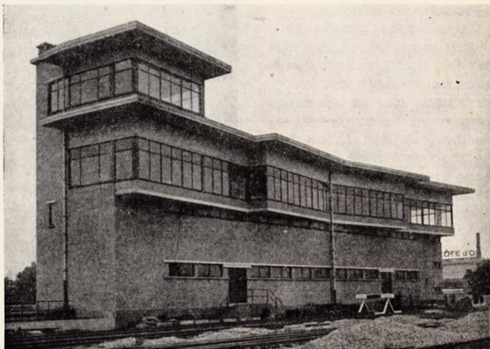
Fig. 16. — Brussel-Zuid. Seinhaus « Zuid ». — Gevel kant sporen.
