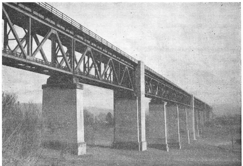
Viadukt van Montzen.
