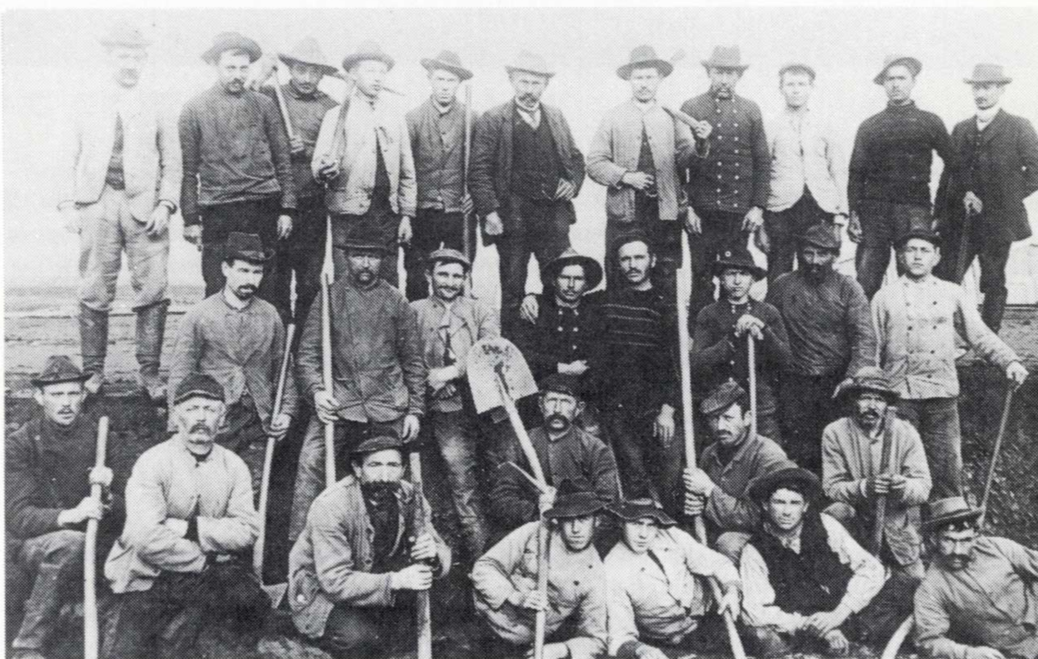
Bauarbeiten 1884 zwischen Sourbrodt und Weywertz. Chantier entre Sourbrodt et Wévercé en 1884. Bouwwerkzaamheden tussen Sourbrodt en Weywertz in 1884.
