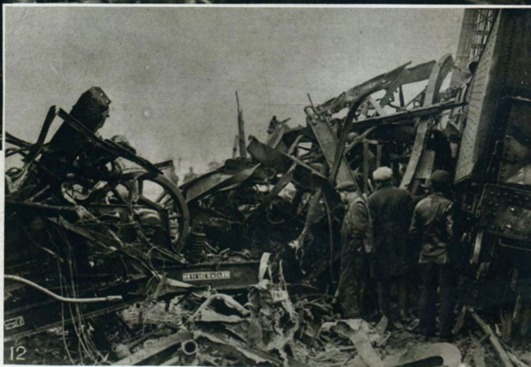
FIG. 11. ASPECT DE LA LOCOMOTIVE DU TRAIN TAMPONNEUR DANS L'ACCIDENT DE LAGNY. — LES VOITURES EN BOIS SONT ENTIEREMENT DETRUITES. LES VOITURES METALLIQUES ONT RESISTE. (PHOTO « ACTUALIT ».)
