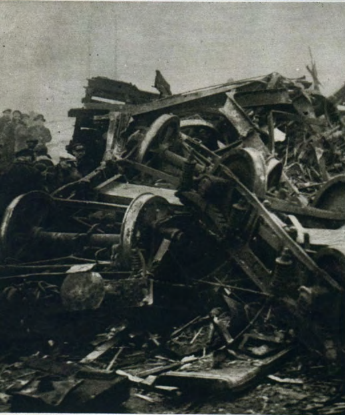
FIG. 11. ASPECT DE LA LOCOMOTIVE DU TRAIN TAMPONNEUR DANS L'ACCIDENT DE LAGNY. — LES VOITURES EN BOIS SONT ENTIEREMENT DETRUITES. LES VOITURES METALLIQUES ONT RESISTE. (PHOTO « ACTUALIT ».)
