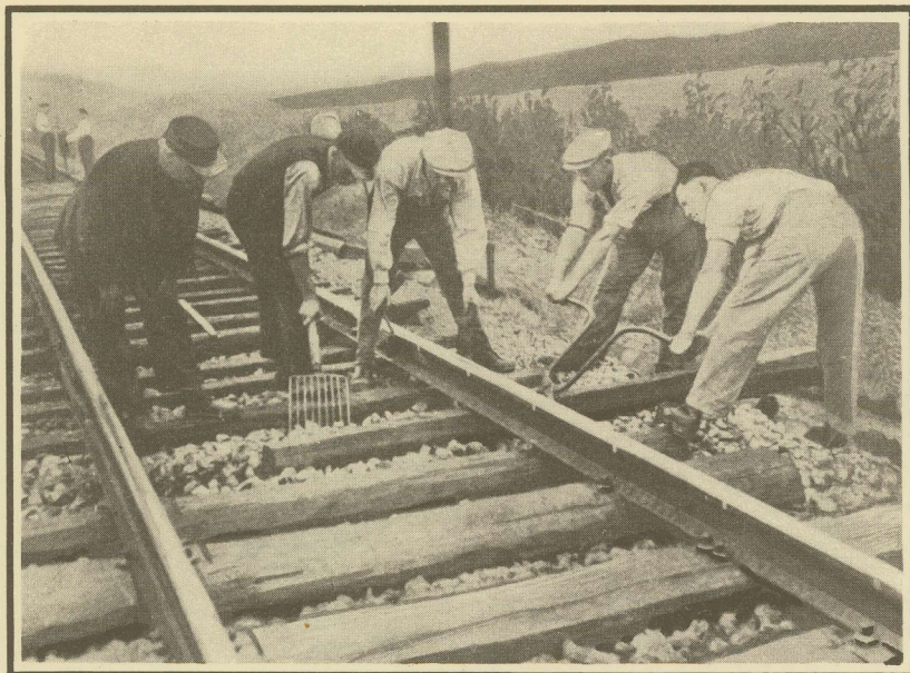
REPLACEMENT D'UNE TRAVERSE AU COURS D'UNE REVISION
