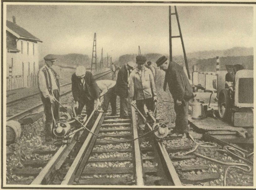
LE MEULAGE MÉCANIQUE DES JOINTS DE LA VOIE
