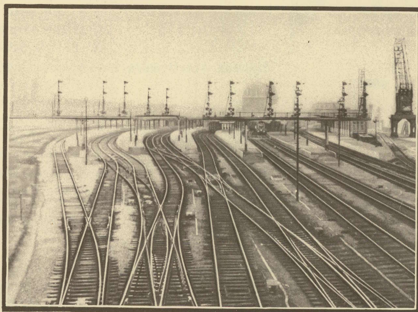
PASSERELLES A SIGNAUX A OSTENDE-QUAI SIGNALISATION A PALETTE A TROIS POSITIONS
