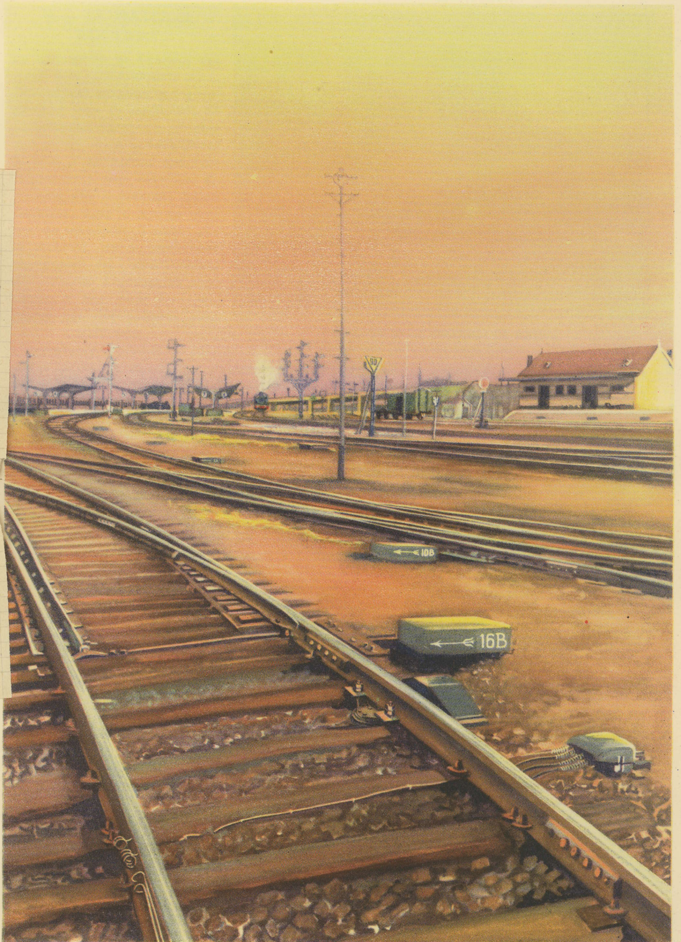
PÉDALE AU MERCURE - CIRCUITS DE VOIE
