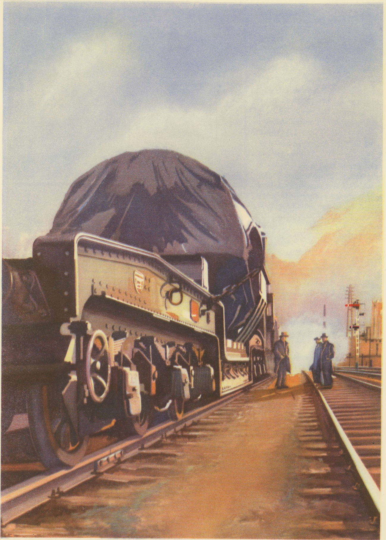
TRANSPORT D'ALTERNATEUR SUR WAGON SURBAISSÉ DE 100 TONNES
