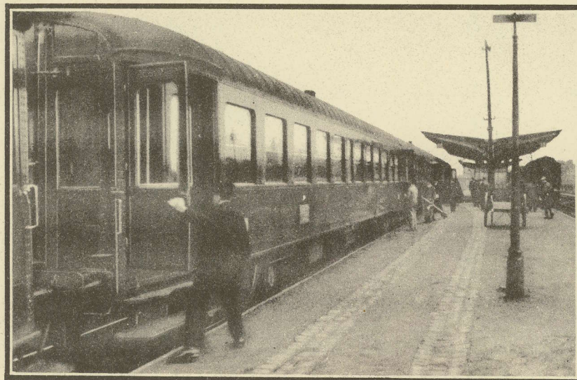
VOITURE MÉTALLIQUE A BOGIES (1934)
