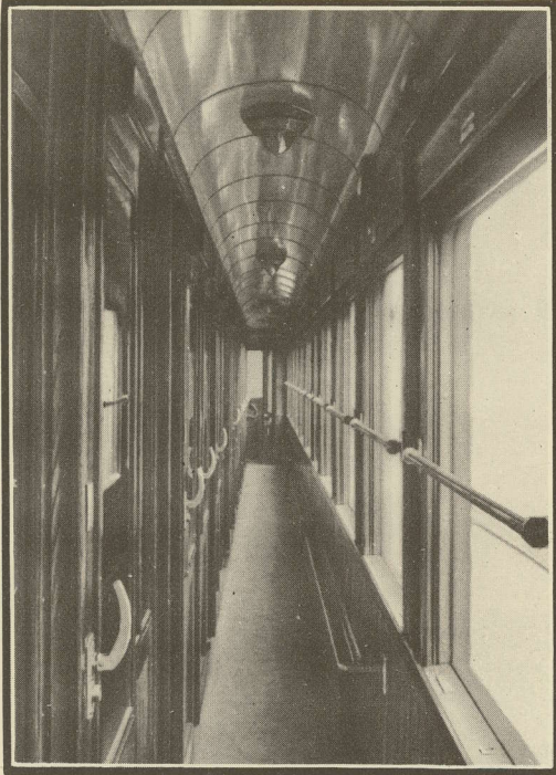
VUE DU COULOIR LATÉRAL D'UNE VOITURE INTERNATIONALE DE TROISIÈME CLASSE
