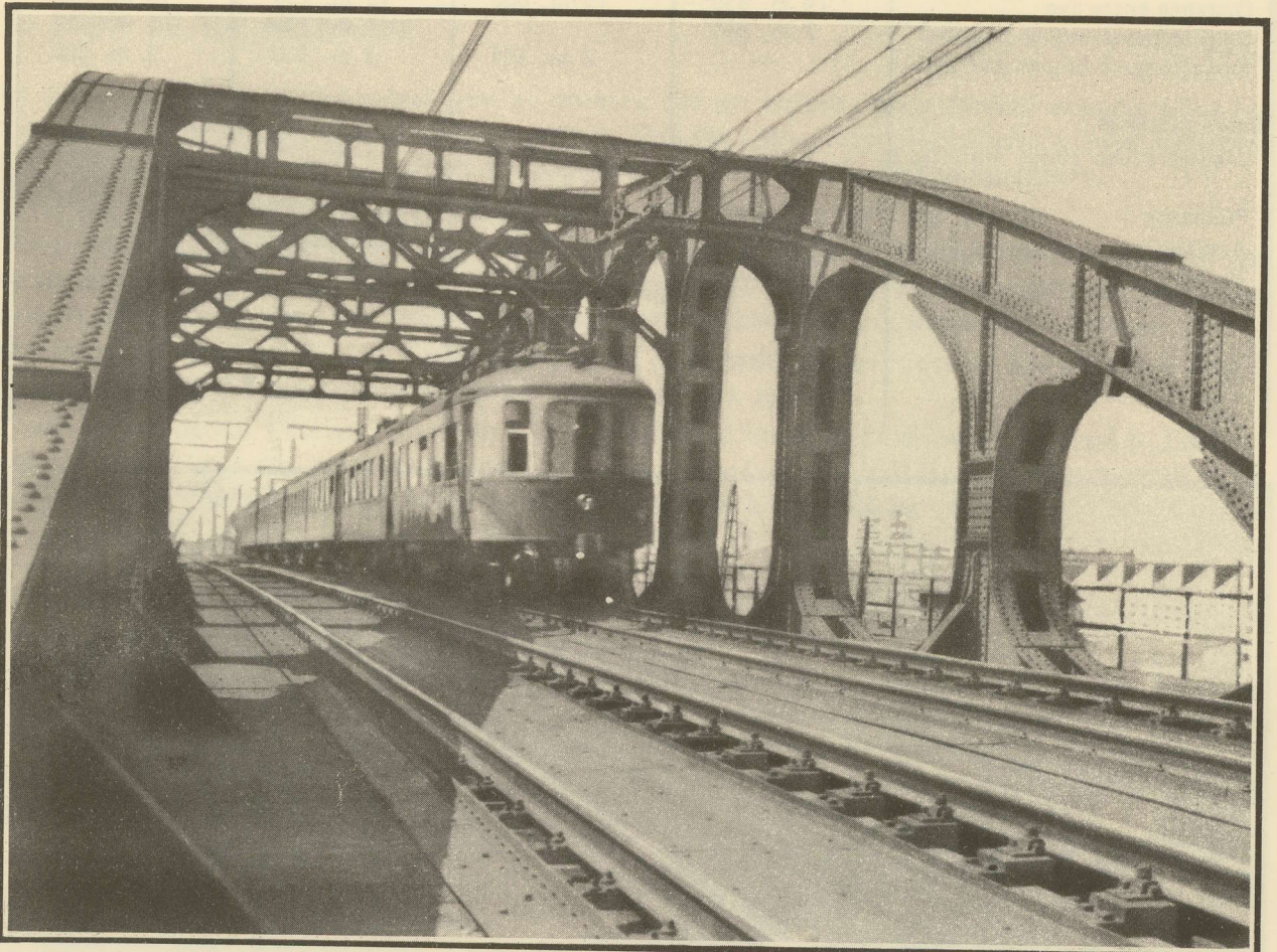
RAME ÉLECTRIQUE QUADRUPLE FRANCHISSANT, A MALINES, LE PONT MÉTALLIQUE DU TYPE VIERENDEEL, JETÉ SUR LE CANAL DE MALINES A LOUVAIN
