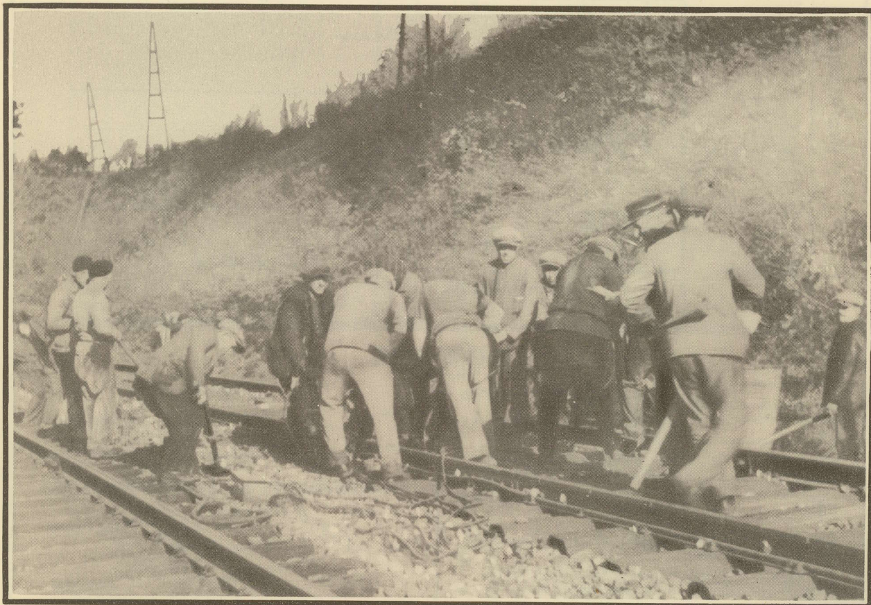
LIGNE FEXHE-LE-HAUT-CLOCHER A ANGLEUR. — LE BOURRAGE DES TRAVERSES
