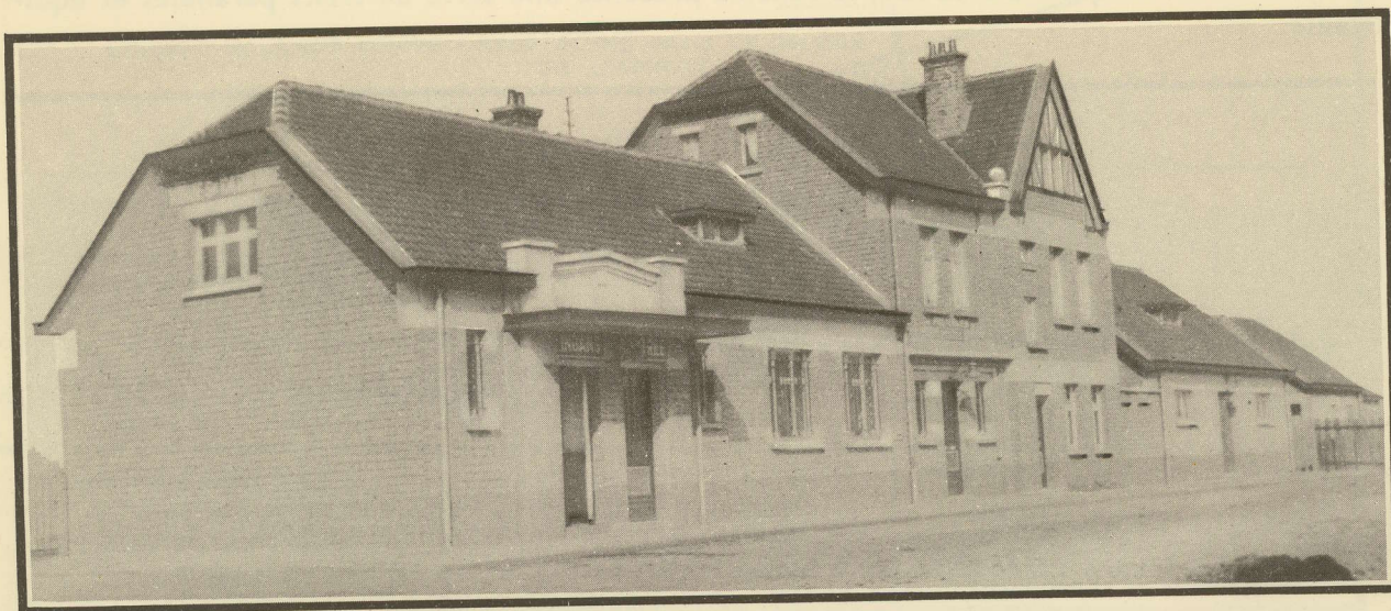
GARE DE WAVRE-SAINTE-CATHERINE, VUE DE LA PLACE DE STATIONNEMENT
