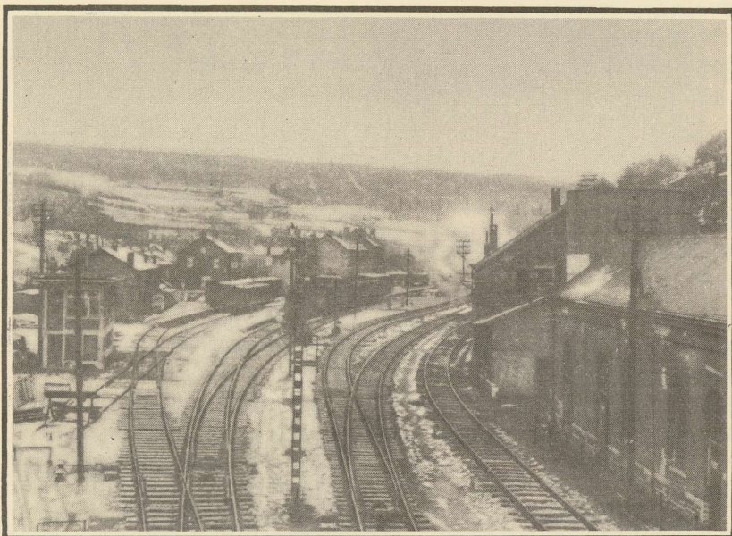
TROIS-PONTS — LES VOIES D'ENTRÉE DE LA STATION
