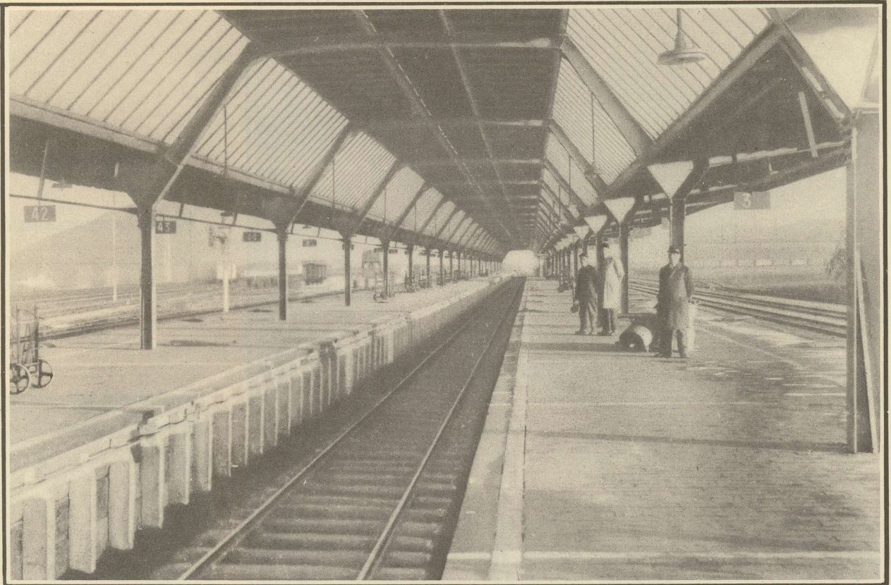
Vue intérieure le jour
