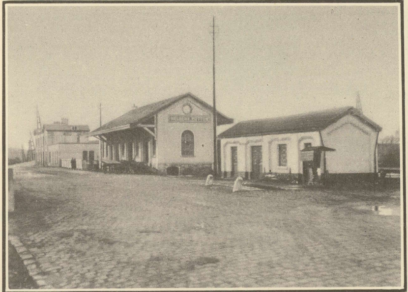
MELREUX — HANGAR AUX MARCHANDISES
