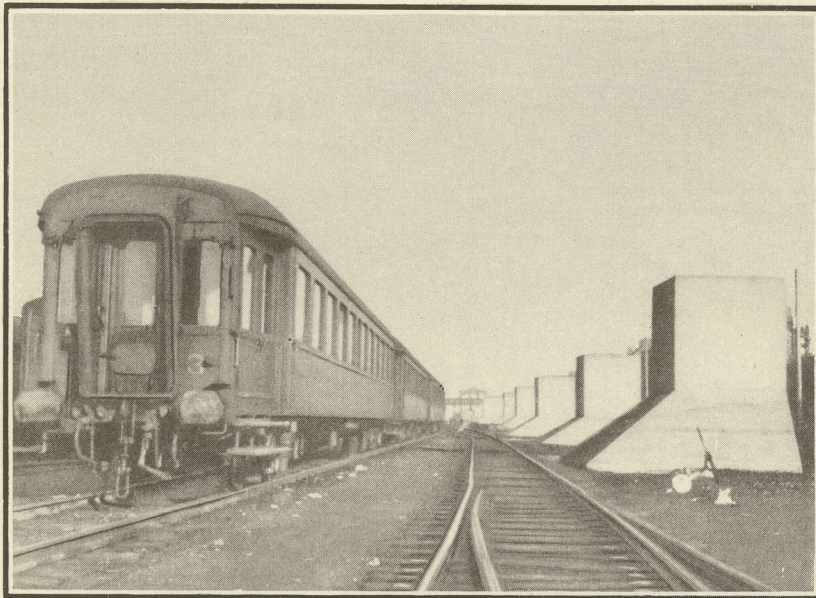
BRUXELLES-MIDI — FONDATION DES POTEAUX SUPPORT DE CATENAIRE
