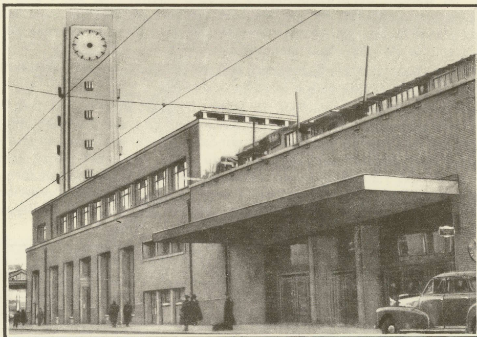
BRUXELLES-MIDI — LA FAÇADE PARTIELLE DE LA RUE DE FRANCE
