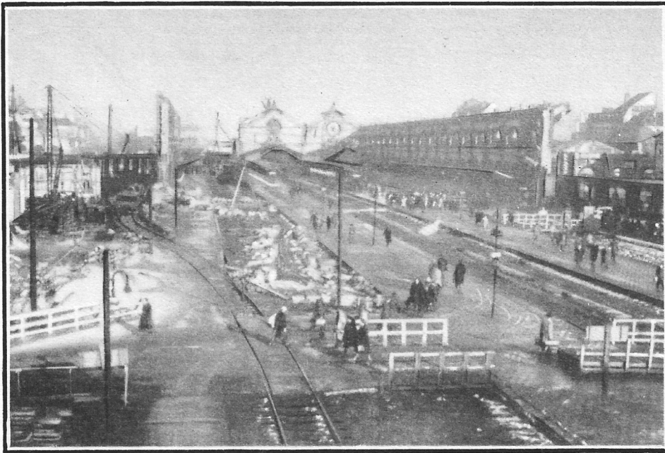
LES TRAVAUX DE DÉMOLITION DE L'ANCIENNE STATION DE BRUXELLES-MIDI
