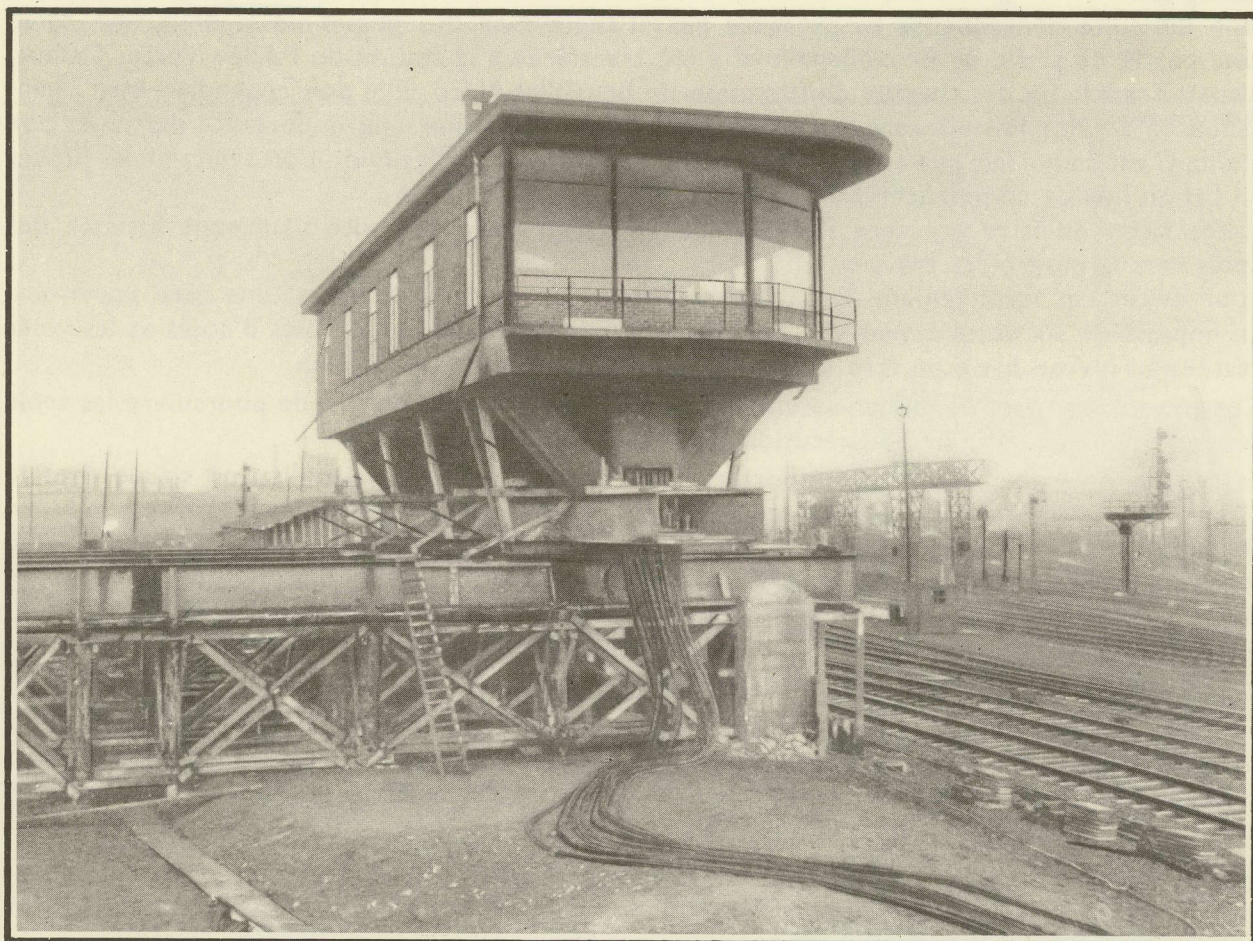
BRUXELLES-NORD — DÉPLACEMENT DE LA CABINE III
