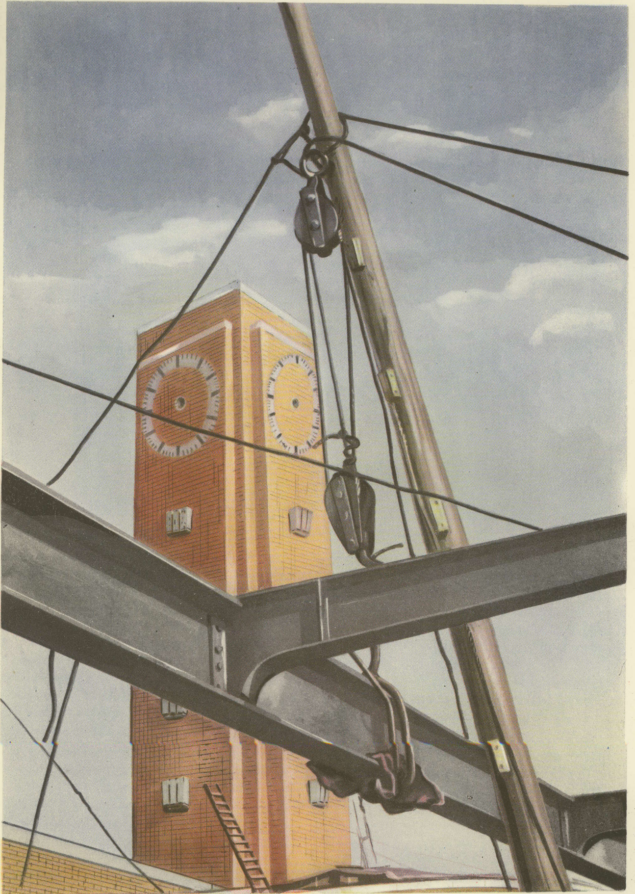
BRUXELLES-MIDI — MONTAGE DES ABRIS PARAPLUIE
