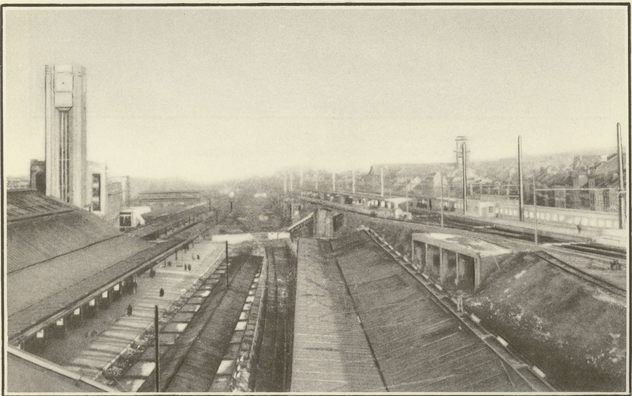
BRUXELLES-NORD — VUE D'ENSEMBLE DES TRAVAUX
