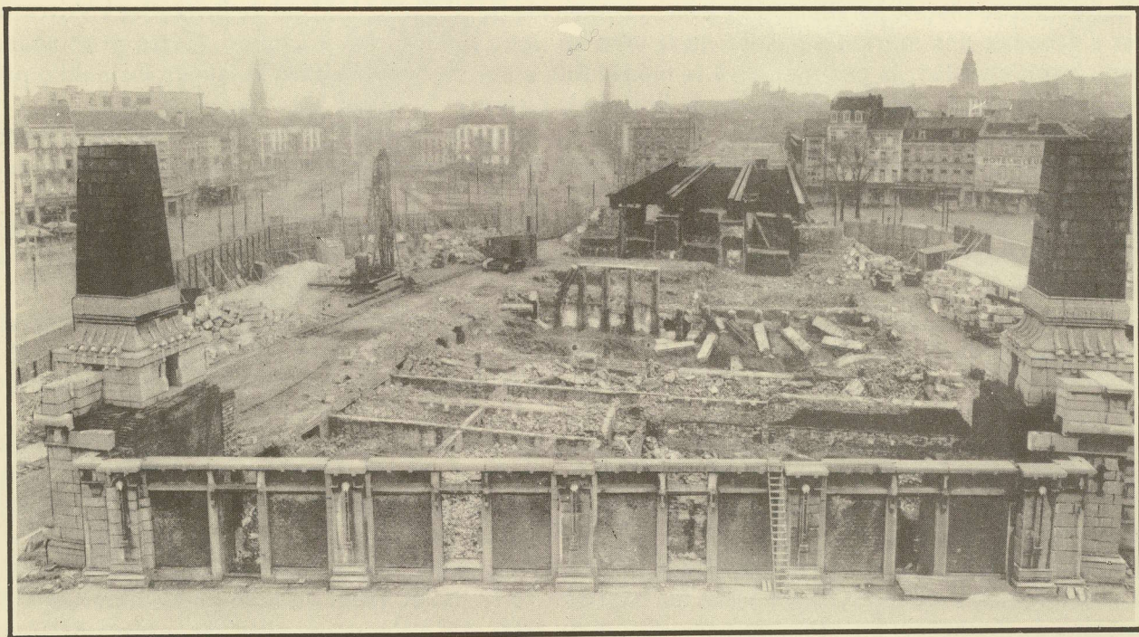
DÉMOLITION DES TRAVAUX EFFECTUÉS AVANT 1914
