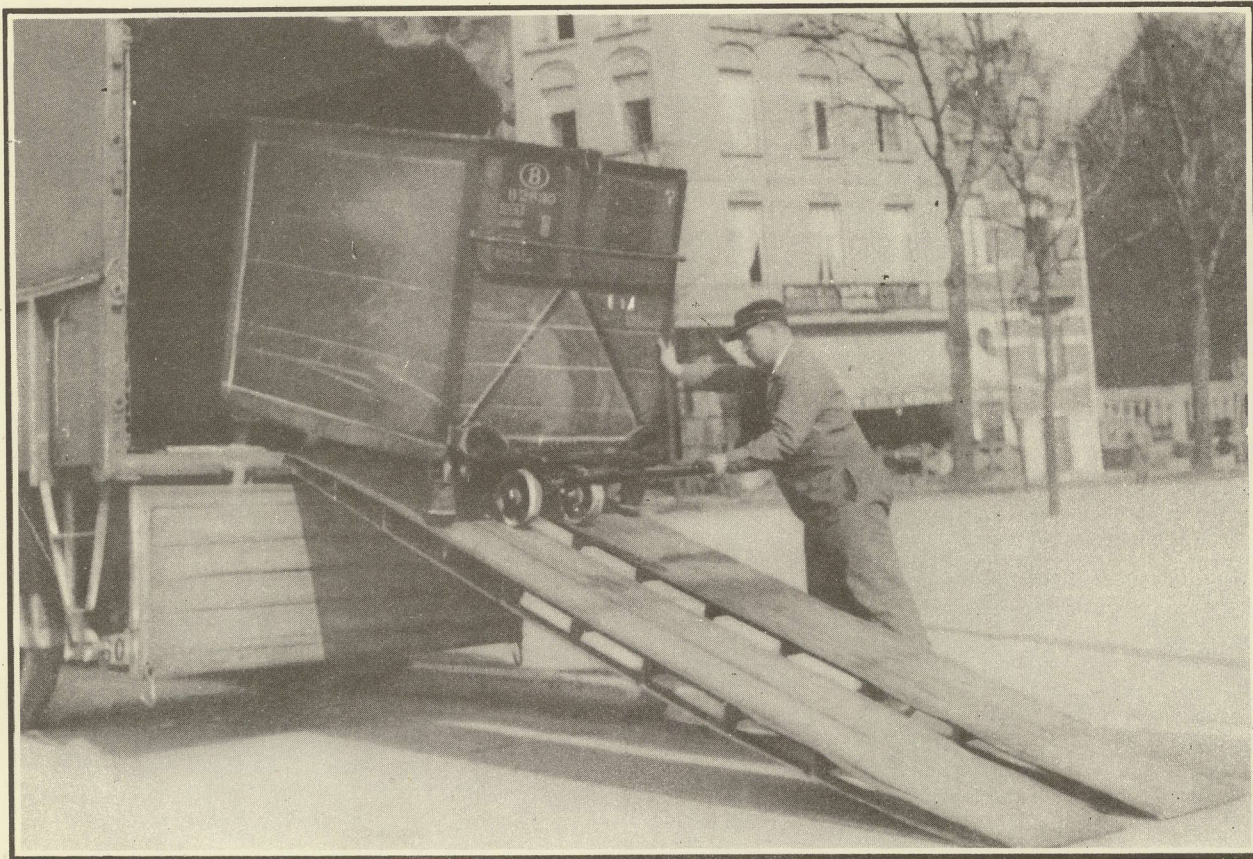
EMBARQUEMENT D'UN CONTAINER SUR UN CAMION DE LA S.N.C.B.
