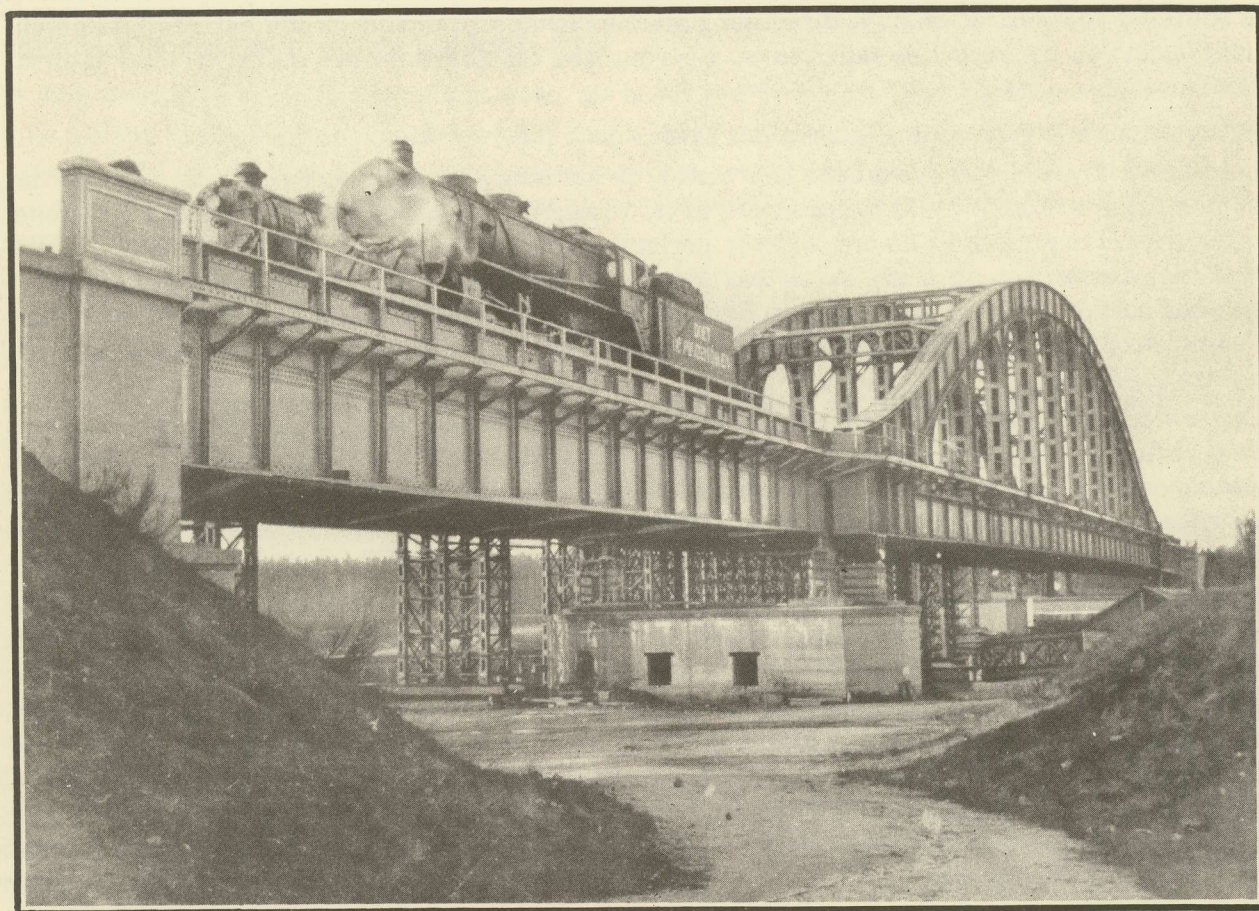
ESSAI DU NOUVEAU PONT-RAIL A HERENTHALS
