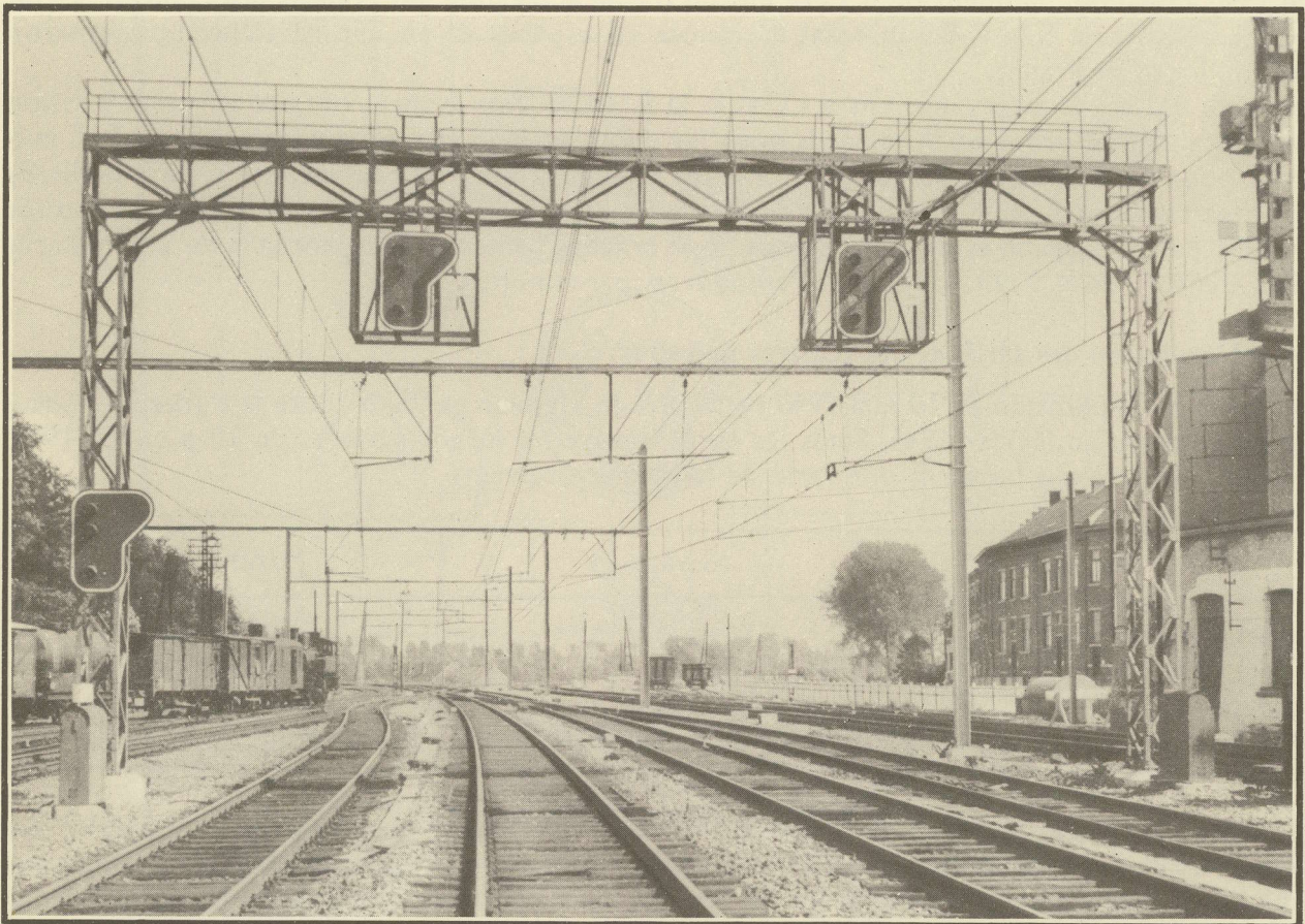
PASSERELLE DE SIGNALISATION POUR VOIES ÉLECTRIFIÉES
