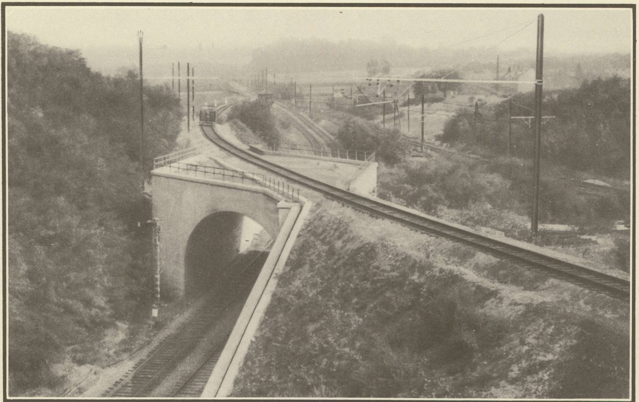
LE CHEVAUCHEMENT DES LIGNES A LINKEBEEK
