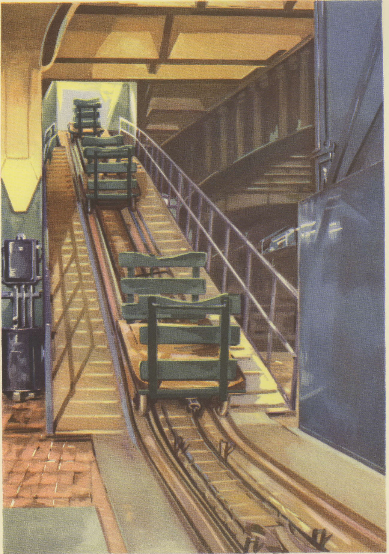
BRUXELLES-MIDI — INSTALLATION DE MANUTENTION MÉCANIQUE DES BAGAGES
