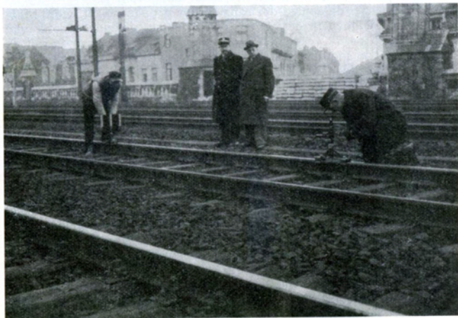
Fig. 70. Gebruik van het viziertoestel en nivelleerbord. (zie nummer 50, bladz. 59).
