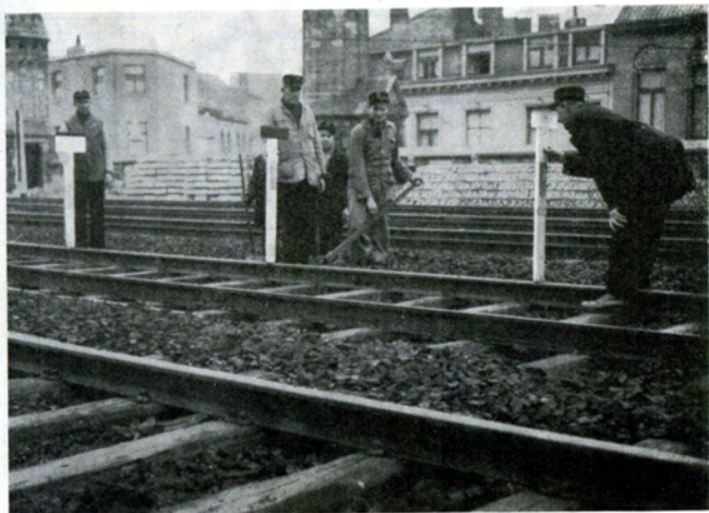
Fig. 65. Nivellering van het spoor voor de « onderstopping ». (zie nummer 37, bladz. 55).
