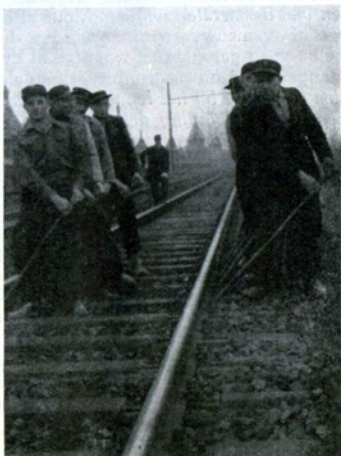
Fig. 64. Richten van het spoor met richtijzers. (zie nummer 33, bladz. 54).
