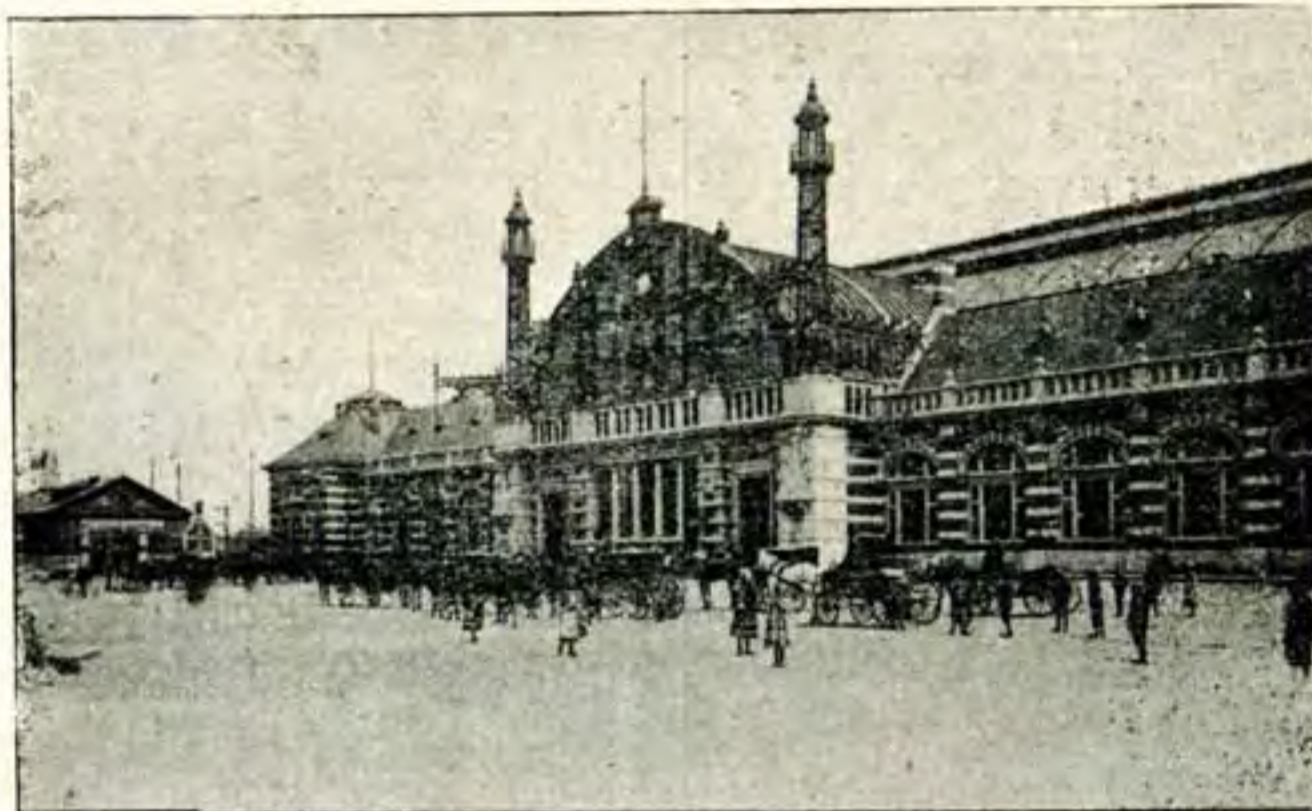
Station de Malines, remplaçant les planches de 1835
