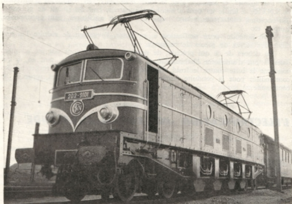
Le nouvelle 2D2-9101 de la S.N.C.F. est l'aboutissement d'une longue série de locomotives électriques de conception et de construction françaises.
